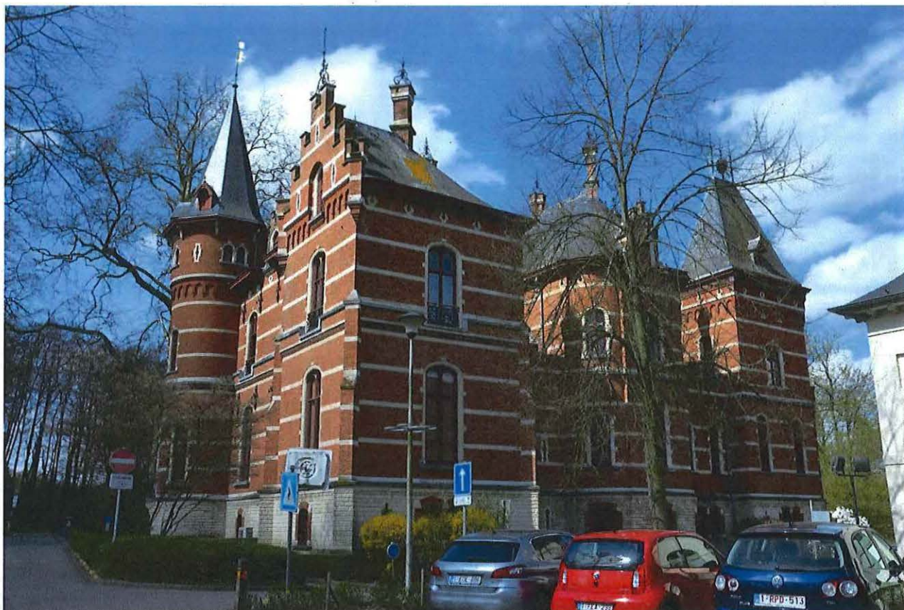
Foto 7: Achtergevel, algemeen beeld (10/04/2018).
