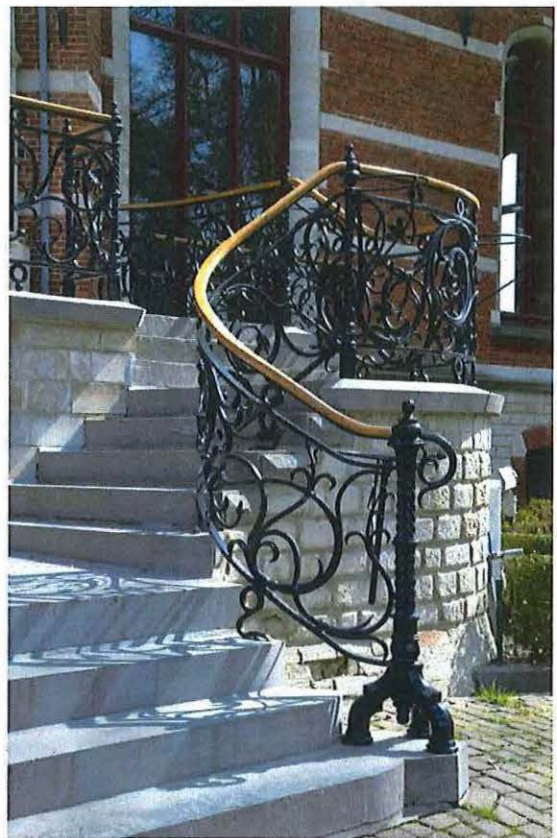
Foto 13: Voorgevel, buitentrap met smeedijzeren balustrade (10/04/2018).
