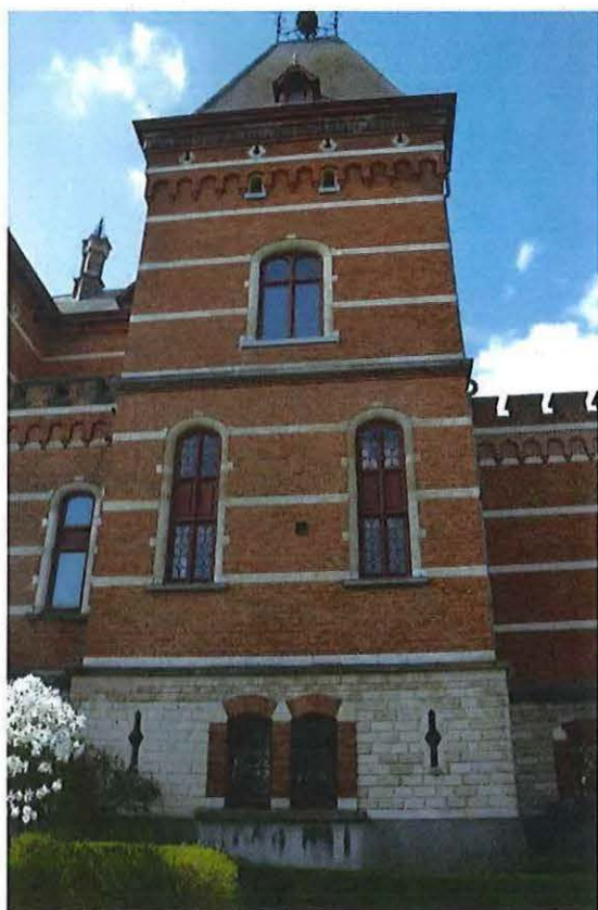
Foto 19: Achtergevel, noordoostelijke hoektoren (10/04/2018).
