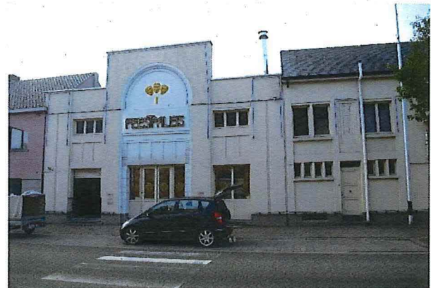
Foto 3: Feestpaleis, voorgevel, 5 november 2018
