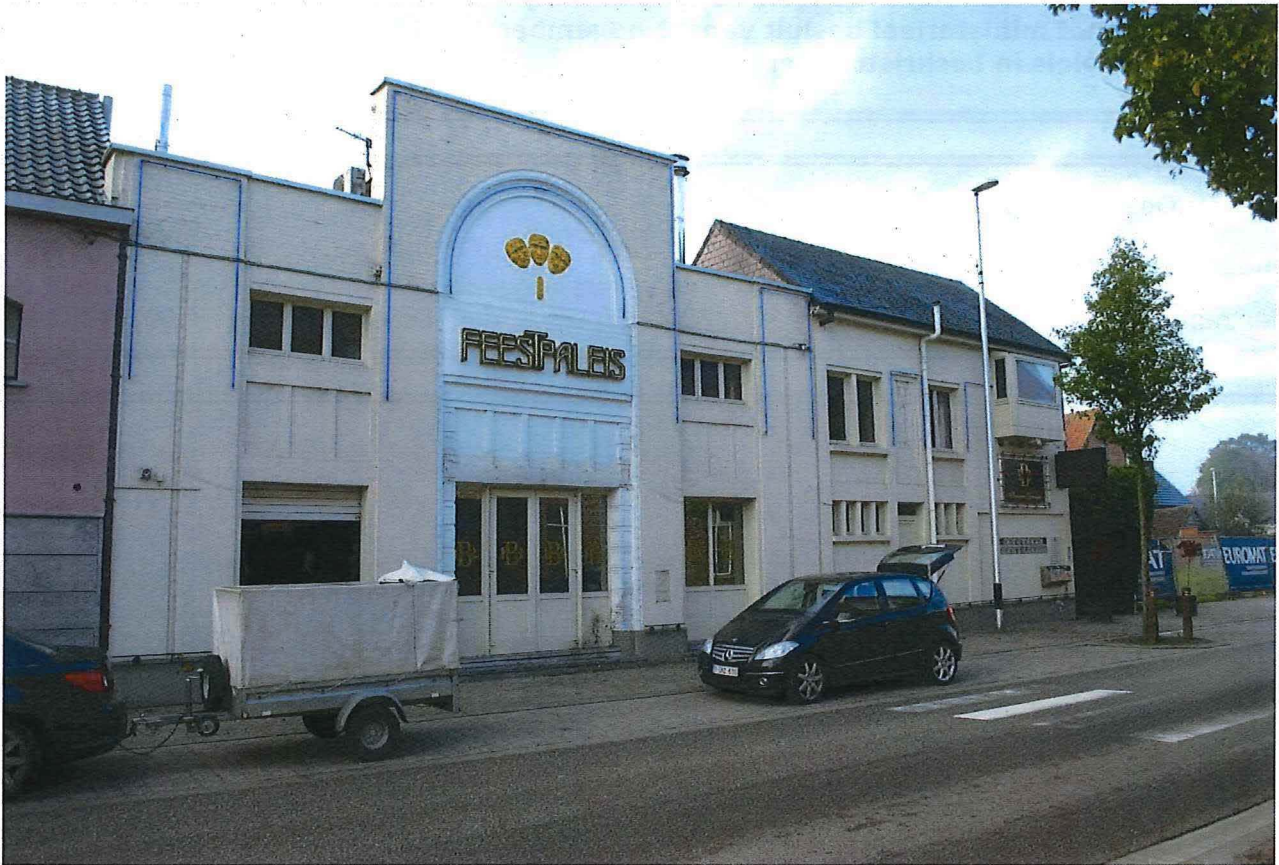
Foto 1: Feestpaleis, voorgevel, 5 november 2018
