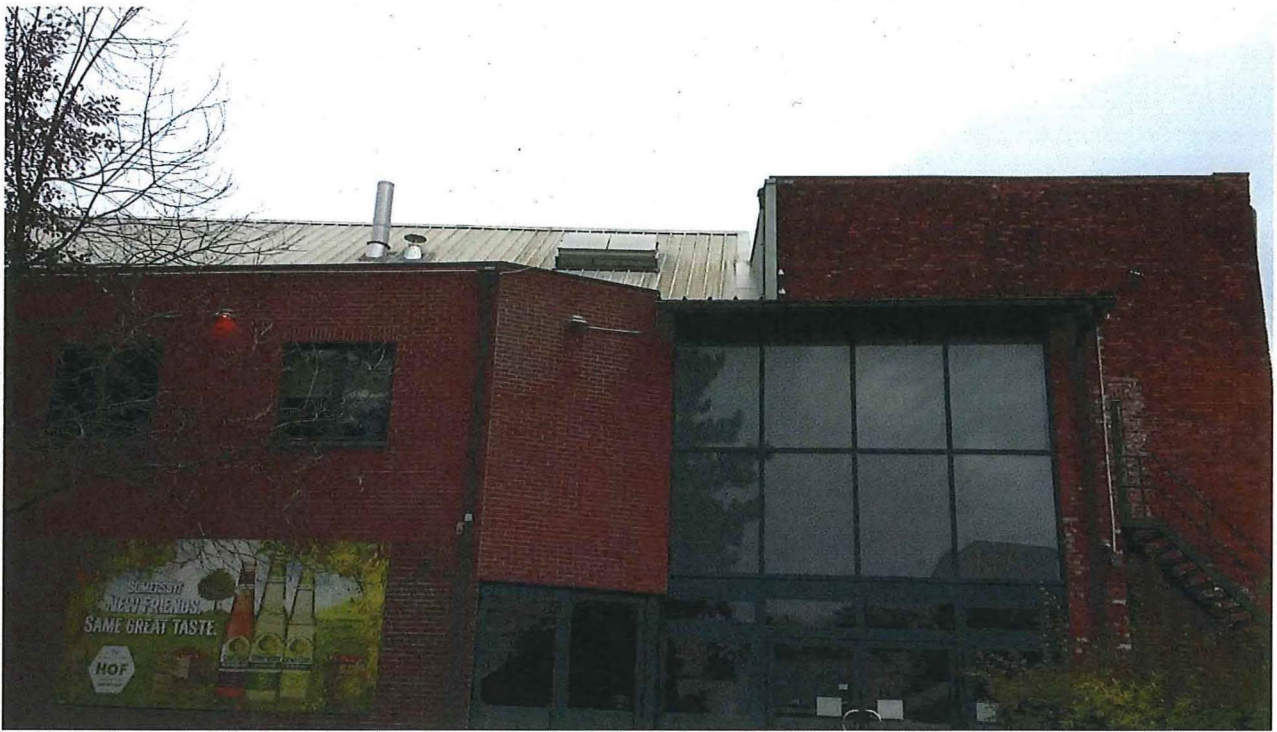
Foto 4: Feestpaleis, zijgevel (verbouwing 2002) met zicht op het vernieuwde dak en de deels bewaarde theatertoren, 28 september 2018
