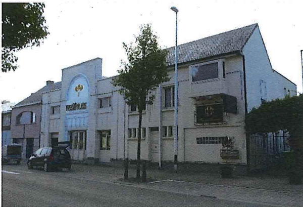
Foto 2: Feestpaleis, voorgevel, 5 november 2018
