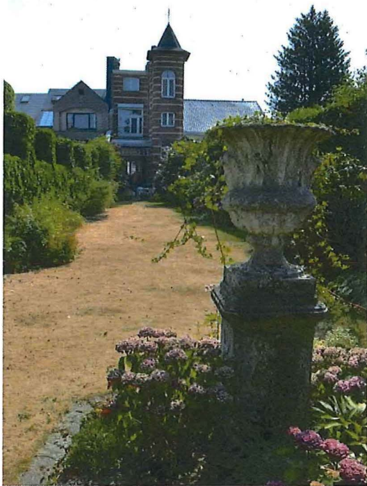
Foto 7: Zicht op de achtergevel, vanuit de tuin. Detail tuinornament in cementrustiek.
