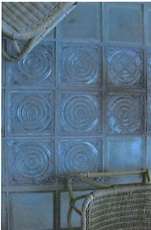
Foto 22: Detail, vloer van het terras met flessenbodemplaat in een metalen rooster.
