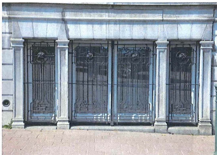
Foto 6: Voorgevel, detail vensters souterrain met smeedijzeren dievenijzers met geometrische vormgeving.
