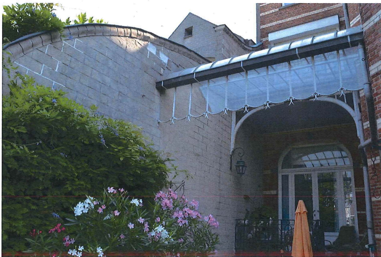
Foto 21: Terras, met zicht op de halfronde scheidingsmuur en de luifel.
