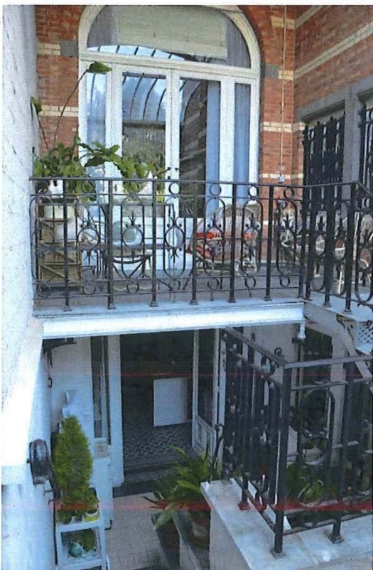
Foto 16: Achtergevel, zicht op de koer van het souterrain (onder) en het terras (boven).
