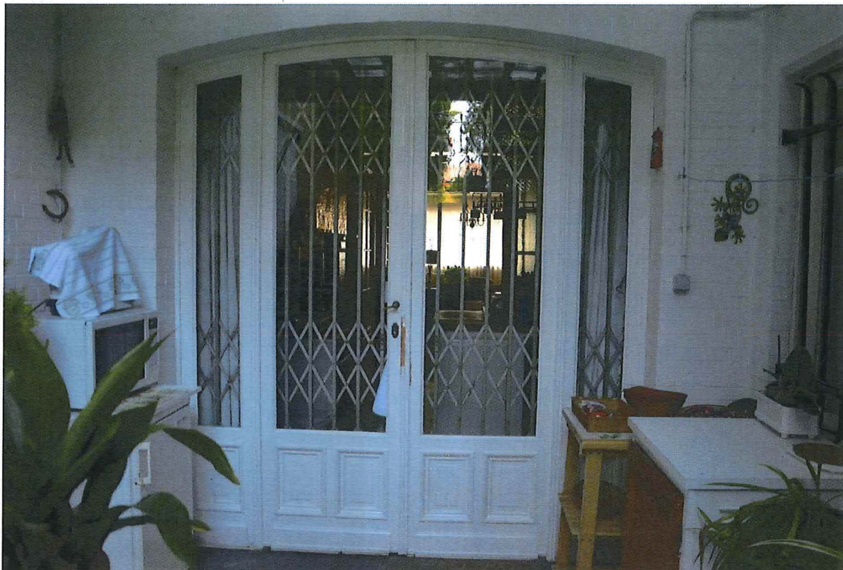
Foto 20: Vensterdeuren tussen de keuken en de koer van het souterrain, met schuifhek.
