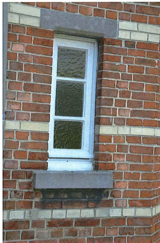
Foto 25: Raam van het toilet op het eerste bordes van de hoofdtrap, met bewaard schrijnwerk.
