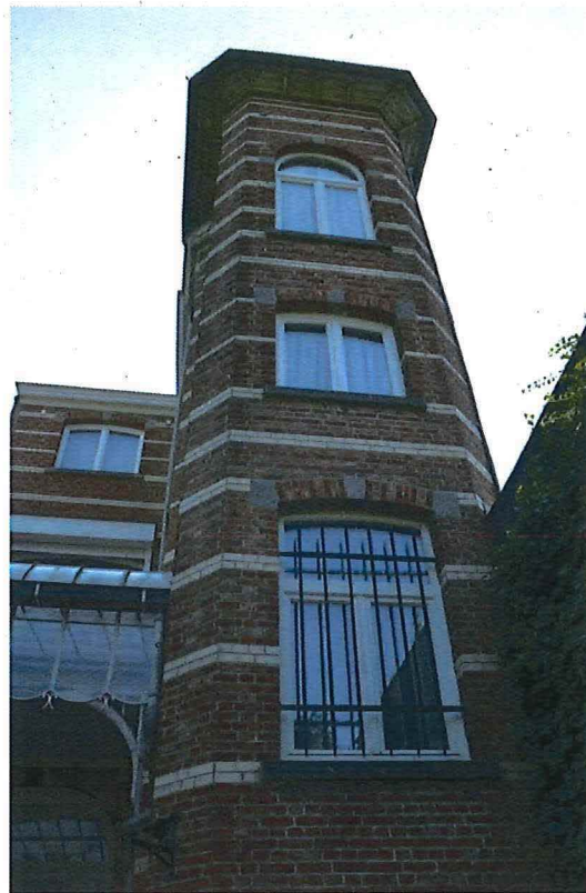
Foto 23: Torenvormige achterbouw die het trappenhuis bevat, vernieuwd schrijnwerk.
