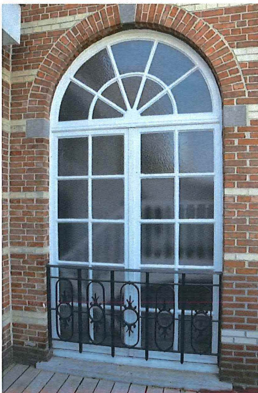
Foto 24: Groot venster dat de hoofdtrap verlicht, gezien vanaf het balkon op de verdieping, met bewaard schrijnwerk.
