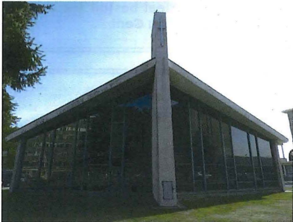
Foto 1: Noordwestelijke en zuidwestelijke vliesgevels
