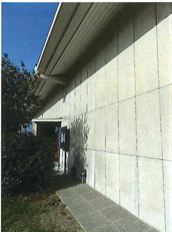
Foto 9: Detail zuidelijke gevel
