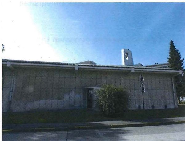
Foto 4: Noordgevel in witte portlandsteen
