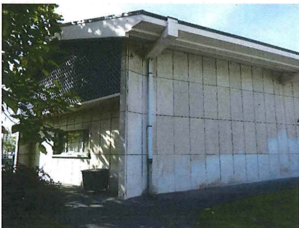
Foto 5: Achterzijde kapel met raam sacristie. Het laatste stukje van de lange gevel maakt een kleine hoek met de achtergevel
