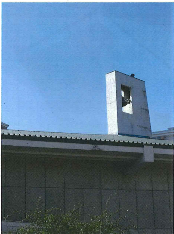
Foto 11: Detail dak en klokkenstoel
