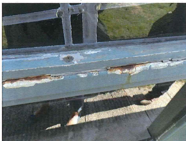
Foto 13: Detail stalen raamprofiel met achterliggend glas in loodraam
