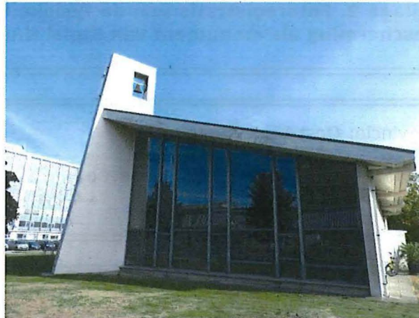
Foto 2: Vliesgevel in het zuidwesten
