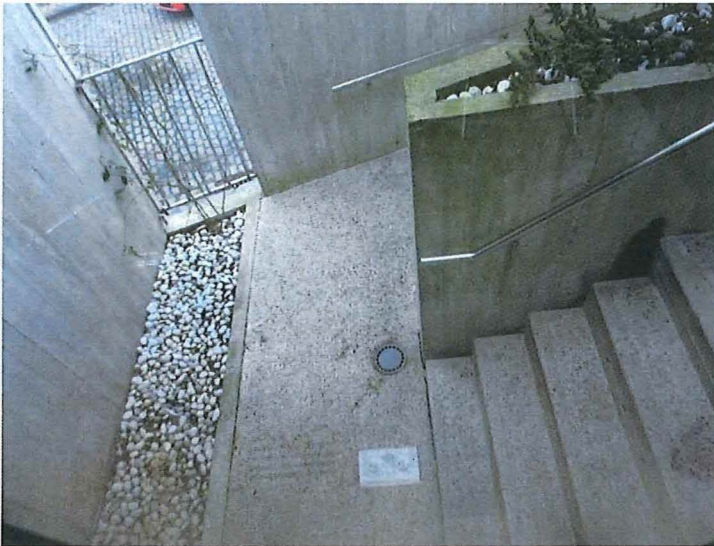
Foto 9: oostgevel, detail trap en bordes met plantenbakken
