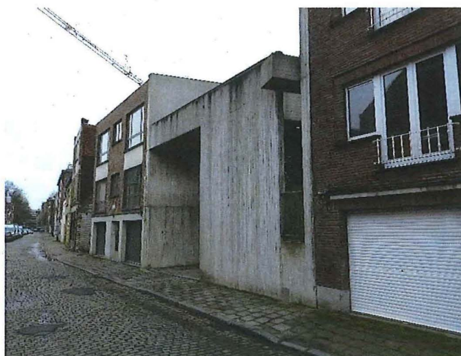
Foto 3: oostgevel vanuit noordzijde
