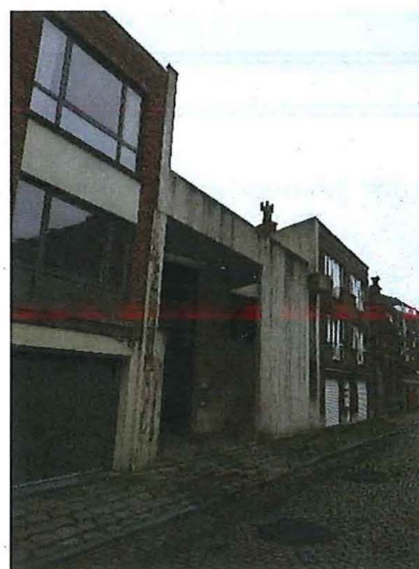
Foto 5: oostgevel vanuit zuiden
