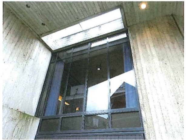
Foto 16: oostgevel, praktijkruimte 2, vensterzone en dakdoorbreking
