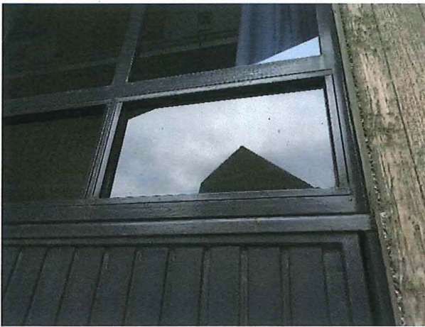
Foto 15: oostgevel, detail van raamwerk en garagepoort
