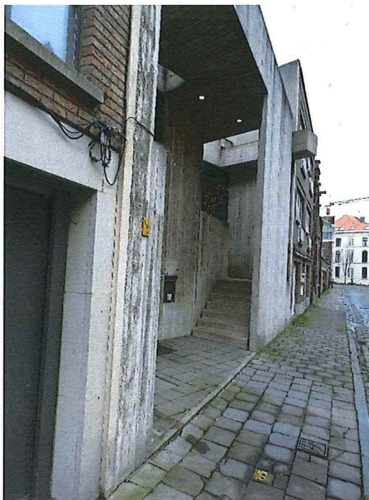
Foto 6: oostgevel vanuit zuiden, ingangspartij met portiek
