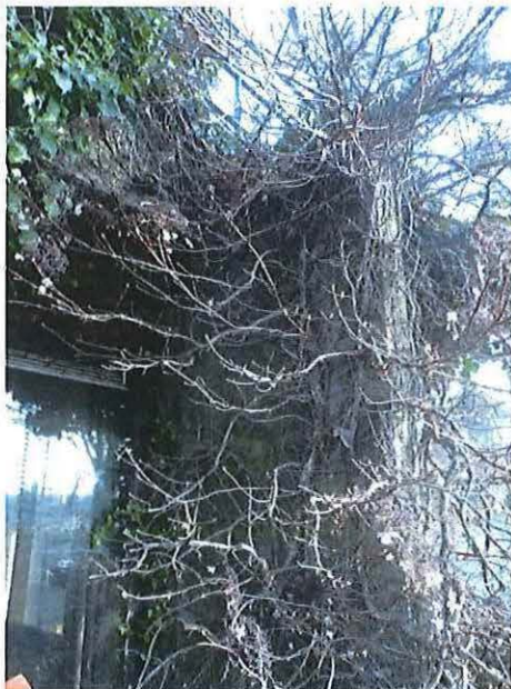
Foto 61: Terras, betonstenen muurtje tot dak (06/03/2018).
