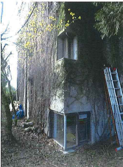
Foto 28: Noordoostelijke hoek en oostgevel (06/03/2018).
