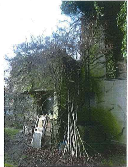
Foto 44: Uitbouw garage, terras en waterput (06/03/2018).
