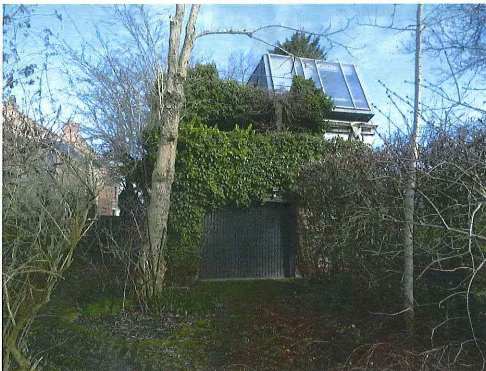
Foto 10: Algemeen zicht van de woning vanaf de oprit (06/03/2018).
