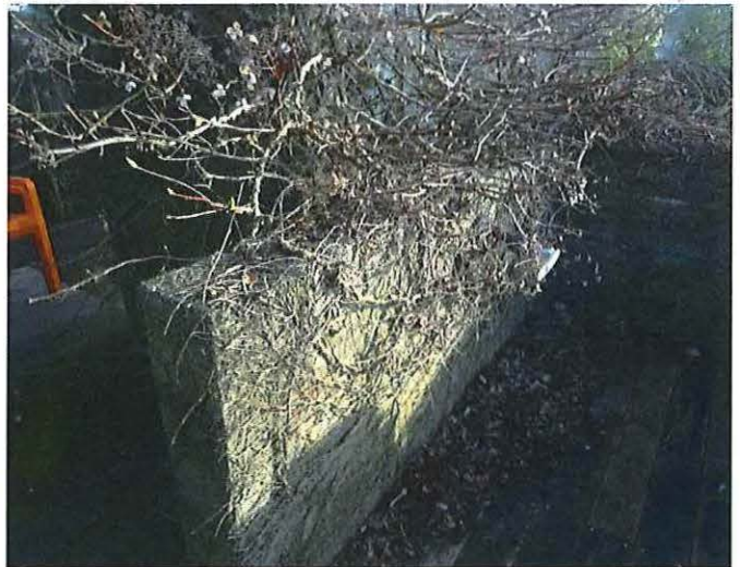
Foto 60: Terras, betonstenen muurtje (06/03/2018).
