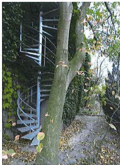
Foto 21: Westgevel, zicht naar zuiden (24/10/2018).
