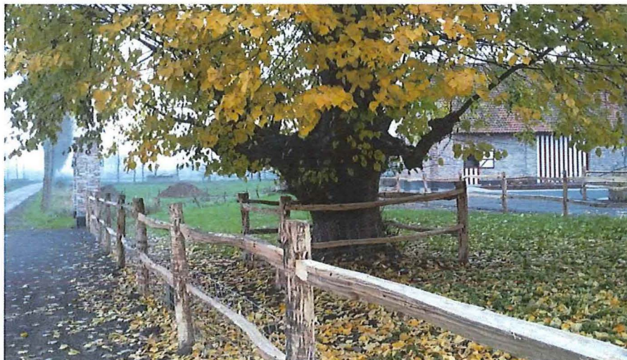
Foto 18: Etagelinde zuidoostzijde, sleuf voor nutsleidingen gegraven tussen beide hekwerken (16/11/2017)
