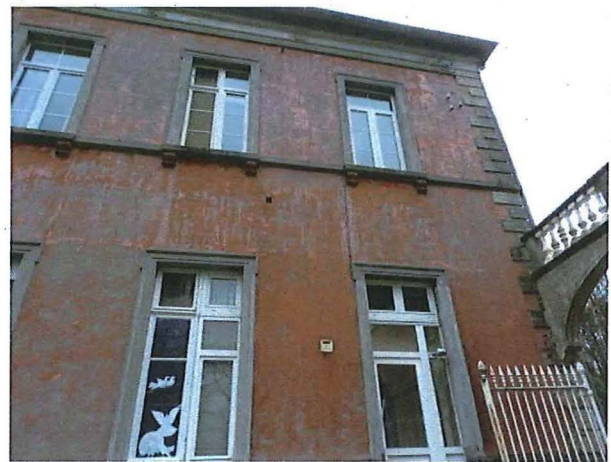
Foto 10: Zijgevel hoofdgebouw: detail
