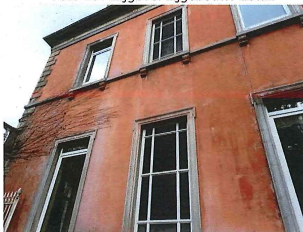
Foto 21: Zijgevel hoofdgebouw: detail
