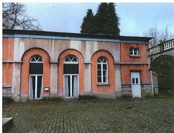
Foto 19: Zijgevel zijgebouw: detail
