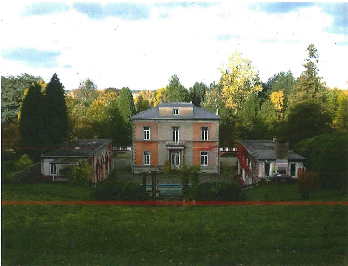
Foto 11: panoramaperk met uitzicht op de achtergevel van de Villa 'La Chênaie' met zijgebouwen.
