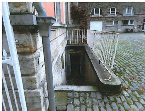
Foto 15: Achtergevel hoofdgebouw: detail toegang kelder
