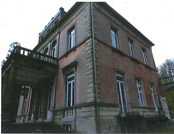
Foto 9: Voor- en zijgevel hoofdgebouw
