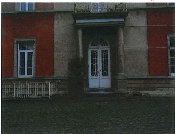
Foto 14: Achtergevel hoofdgebouw: detail achterdeur
