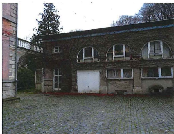
Foto 17: Zijgevel zijgebouw: detail
