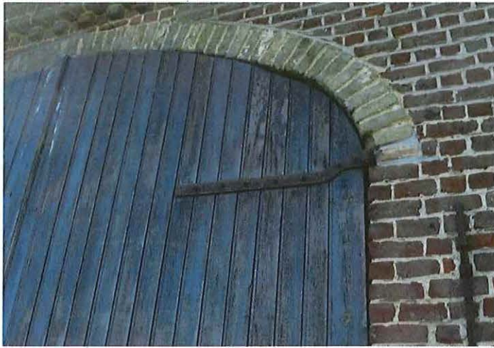
Foto 76: schuurpoort met hang- en sluitwerk (achtergevel) – strek van geeloranje baksteen (19.04.2018). Foto 77: achter- of oostgevel van dwarsschuur ter hoogte van aardappelkelder – storende inbreng van grote muuropening na 1975, waarboven barst in het metselwerk (19.04.2018).
