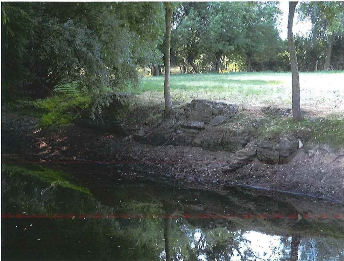
Foto 15: restant van betonnen oorlogsconstructie op de westelijke oever van de vijver. Deze constructie werd tijdens de Eerste Wereldoorlog ingebouwd tussen de resterende muren van de schuur (beeld vanaf de overzijde van de vijver, 26.07.2018).
