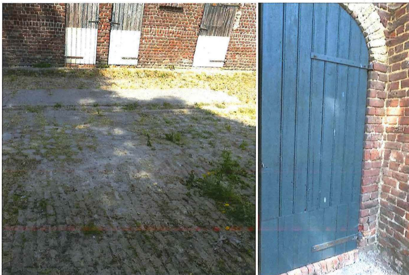
Foto 58: de oorspronkelijke erfaanleg: bakstenen op hun strek voor de paardenstal en de varkensstal. Stoep langs de stallen en strook verderlopend tot de overdekte mestvaalt (26.07.2018).
