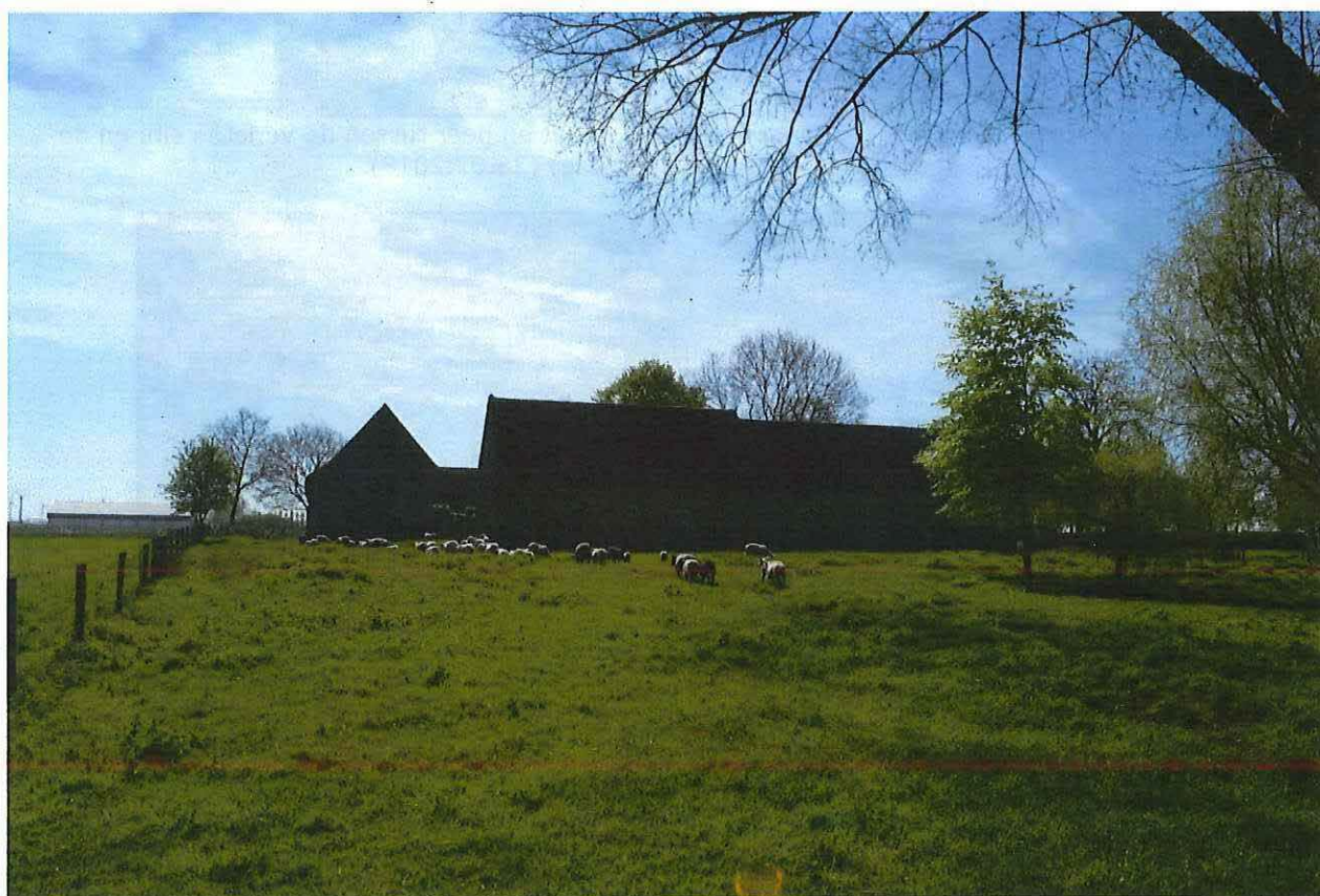
Foto 17: zicht op de semi-gesloten configuratie van de wederopbouwhoeve vanaf de verlaten site. Er bestaat een sterke ensemblewerking tussen de vooroorlogse site en wederopbouwhoeve (19.04.2018).
