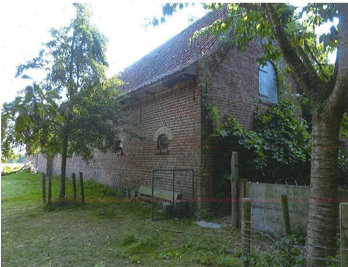
Foto 82: achtergevel van paardenstal en -varkensstal ter hoogte van de boomgaard (26.07.2018).
