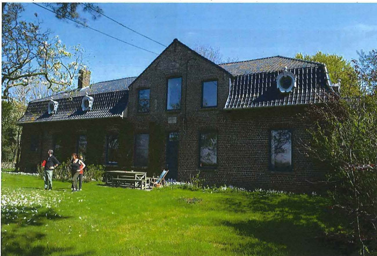
Foto 34: representatieve straatgevel van de boerenwoning - breed dakvenster ter hoogte van de deur. Blauwpannen mansardedak met oeils de boeuf - vernieuwd houtwerk met uitzondering van het keldervenster (19.04.2018).
