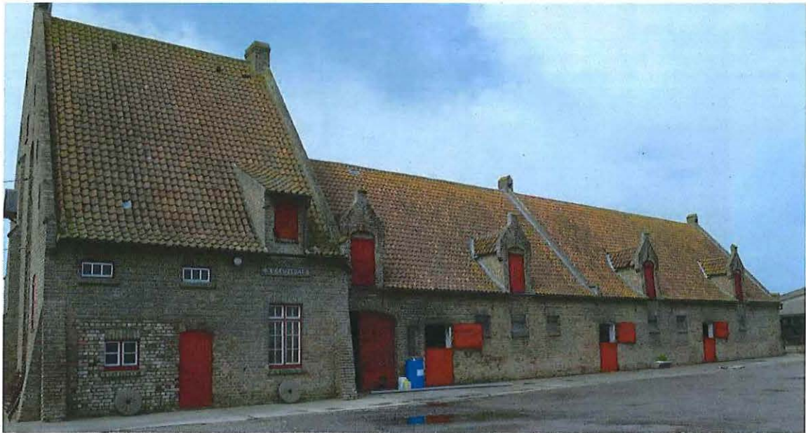
Foto 13: Hoeve 't Geuzegat'. Stalvleugel, erf- of oostgevel, mei 2018 (Onroerend Erfgoed)
