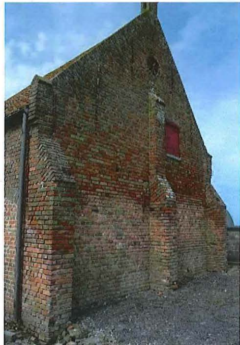
Foto 20: Hoeve 't Geuzegat'. Schuurvleugel. Oostgevel, mei 2018 (Onroerend Erfgoed)
