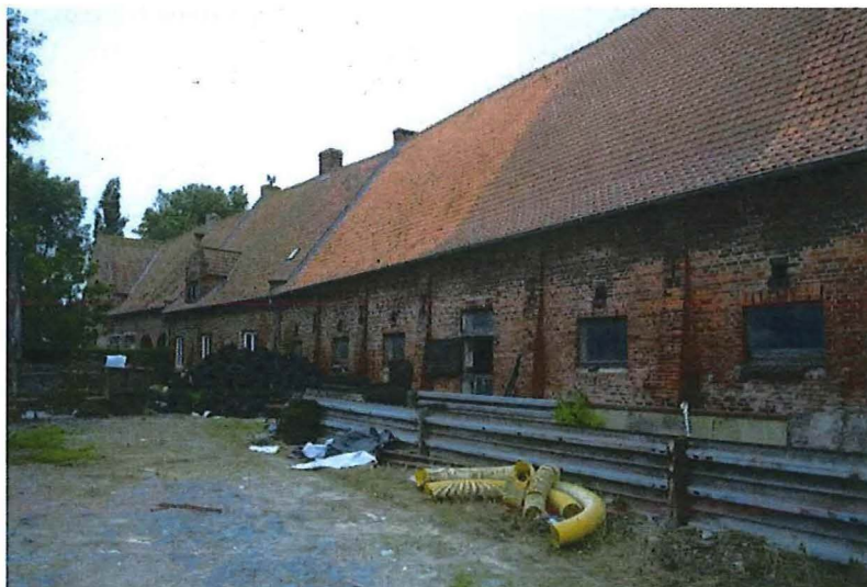
Foto 24: Hoeve 'Oosthof'. Koestal. Achter- of westgevel, juni 2018 (Onroerend Erfgoed)
