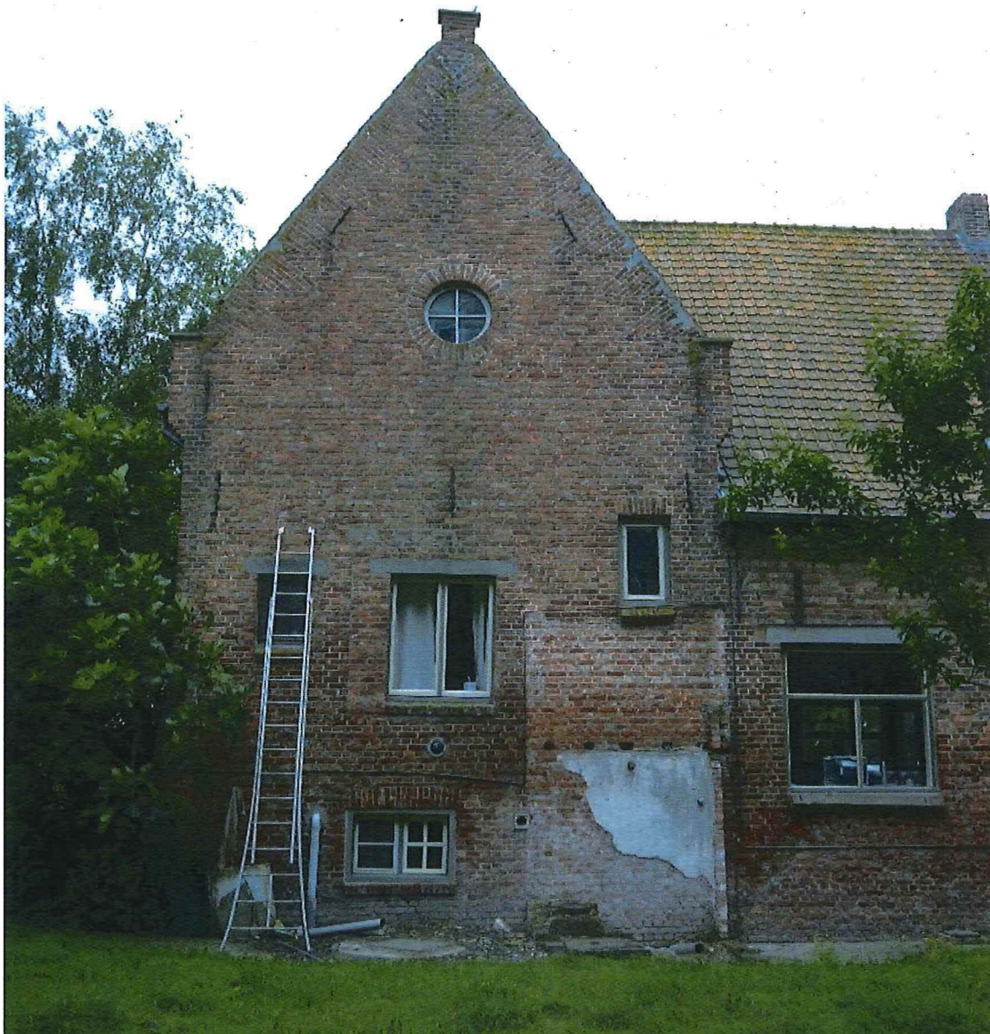
Foto 13: Hoeve 'Oosthof'. Boerenhuis. Achter- of oostgevel, juni 2018 (Onroerend Erfgoed)
