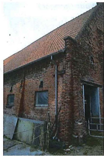
Foto 23: Hoeve 'Oosthof'. Koestal. Achter- of westgevel, juni 2018 (Onroerend Erfgoed)
