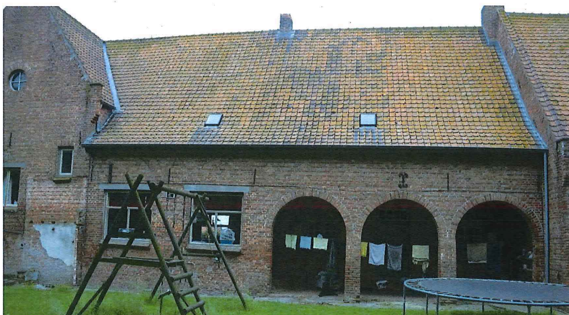
Foto 14: Hoeve 'Oosthof'. Boerenhuis. Achter- of oostgevel, juni 2018 (Onroerend Erfgoed)
