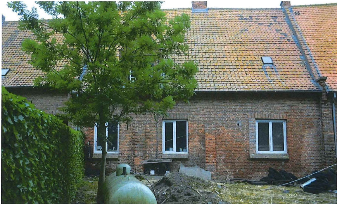
Foto 17: Hoeve 'Oosthof'. Boerenhuis. Achter- of oostgevel, juni 2018 (Onroerend Erfgoed)
