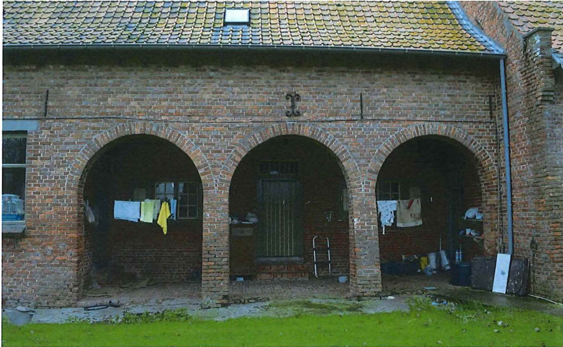
Foto 15: Hoeve 'Oosthof', Boerenhuis. Achter- of oostgevel met arcade van drie open rondbogen, juni 2018 (Onroerend Erfgoed)
