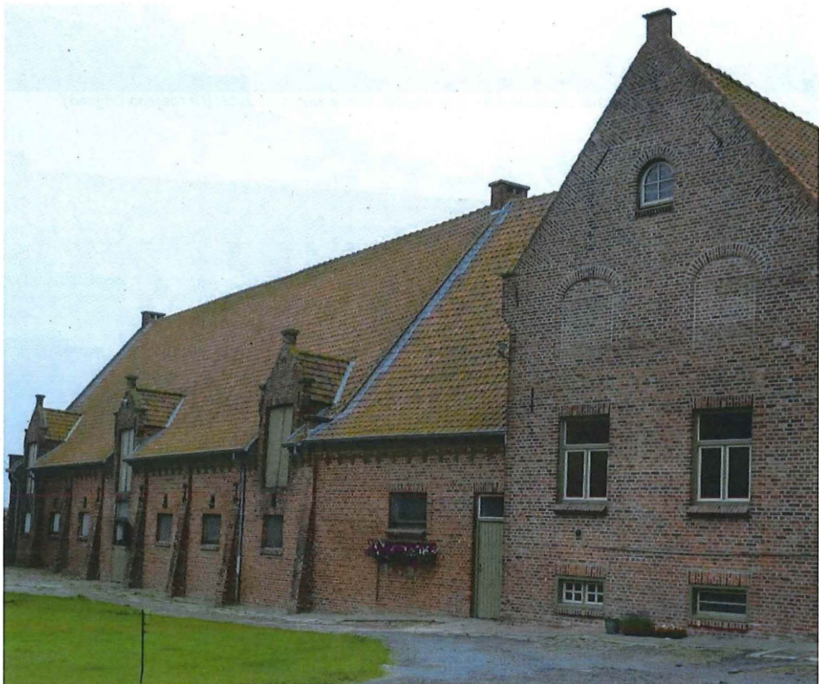
Foto 18: Hoeve 'Oosthof'. Koestal. Erf- of oostgevel, juni 2018 (Onroerend Erfgoed)
