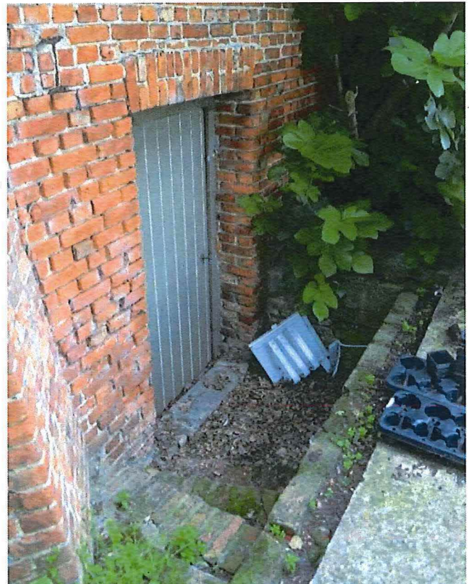
Foto 12: Hoeve 'Oosthof'. Boerenhuis. Zuidgevel, keldertoegang, juni 2018 (Onroerend Erfgoed)
