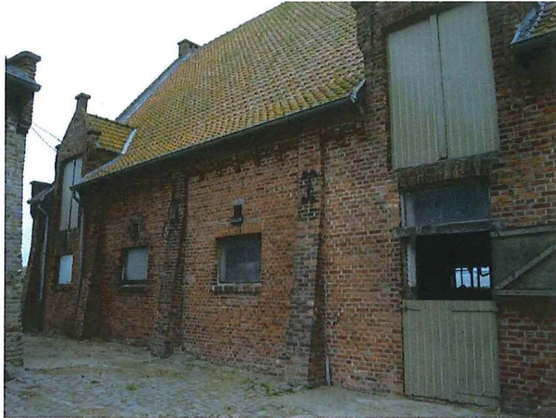
Foto 21: Hoeve 'Oosthof'. Koestal. Erf- of oostgevel, juni 2018 (Onroerend Erfgoed)
