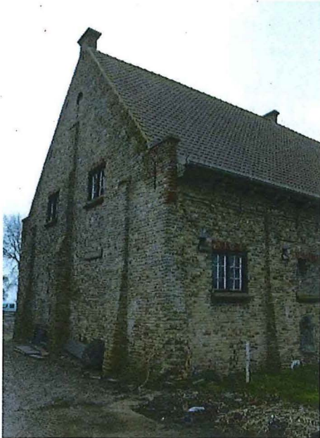
Foto 31: Hoeve 'Oosthof'. Boerenhuis. Paardenstal, oostgevel, juni 2018 (Onroerend Erfgoed)
