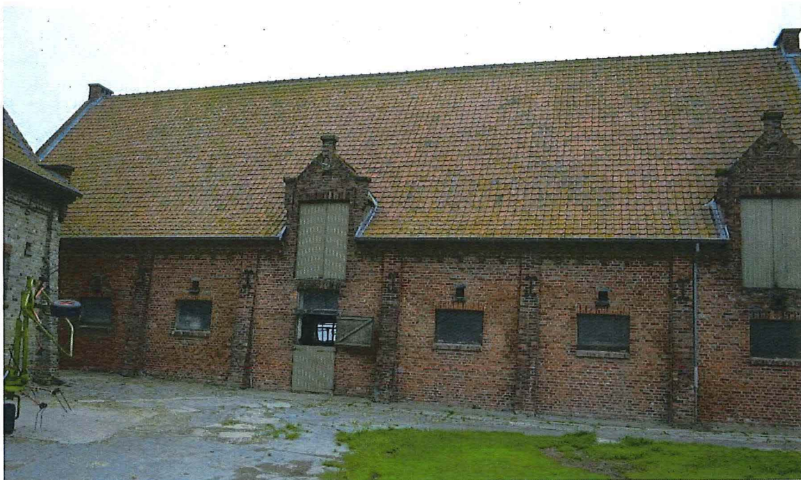
Foto 20: Hoeve 'Oosthof'. Koestal. Erf- of oostgevel, juni 2018 (Onroerend Erfgoed)
