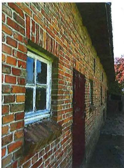
Foto 33: achtergevel van de achterbouw.
