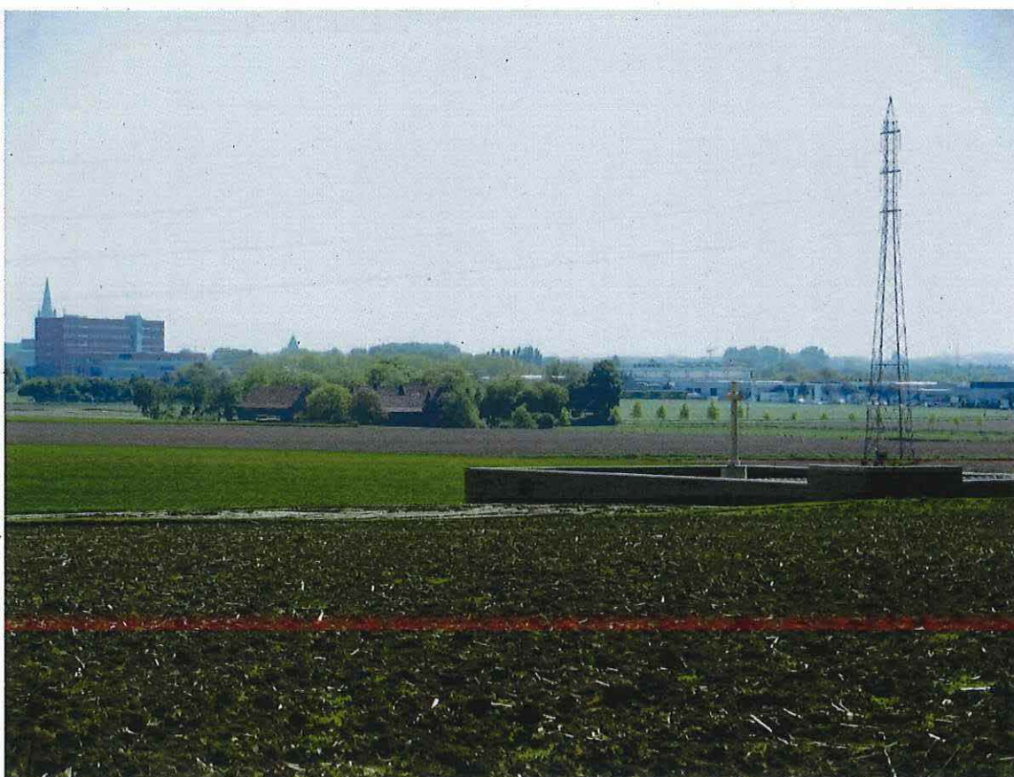
Foto 2: de hoeve Pilkemseweg 130 vanuit het noordoosten.
