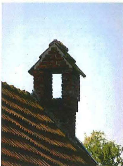
Foto 32: schoorsteen van de achterbouw.
