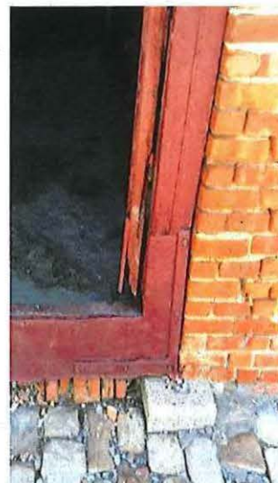
Foto 23: voorgevel van de schuur, met oorspronkelijk poortluik op betonnen draaisteen. De dorpel in baksteen is eveneens oorspronkelijk.
