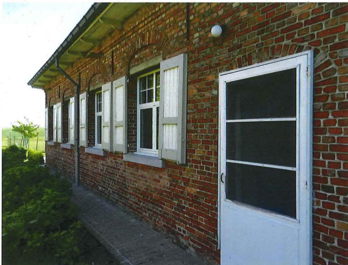
Foto 27: achtergevel van het woonhuis.
