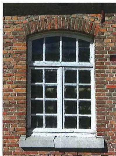
Foto 16: venster in de voorgevel met oorspronkelijk schrijnwerk.
