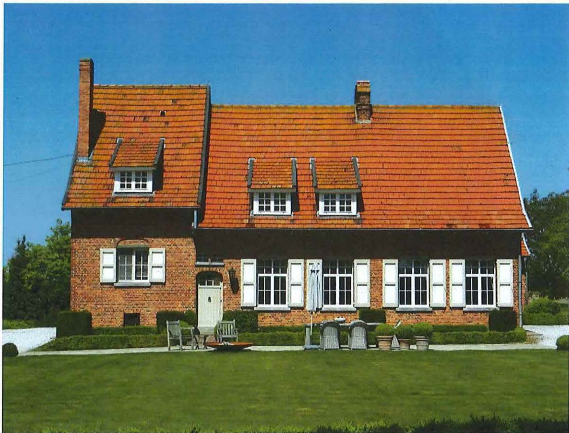
Foto 24: voorgevel van het woonhuis.
