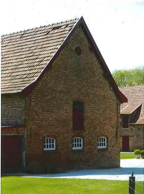
Foto 19: de noordelijke dwarsgevel van de schuur.
