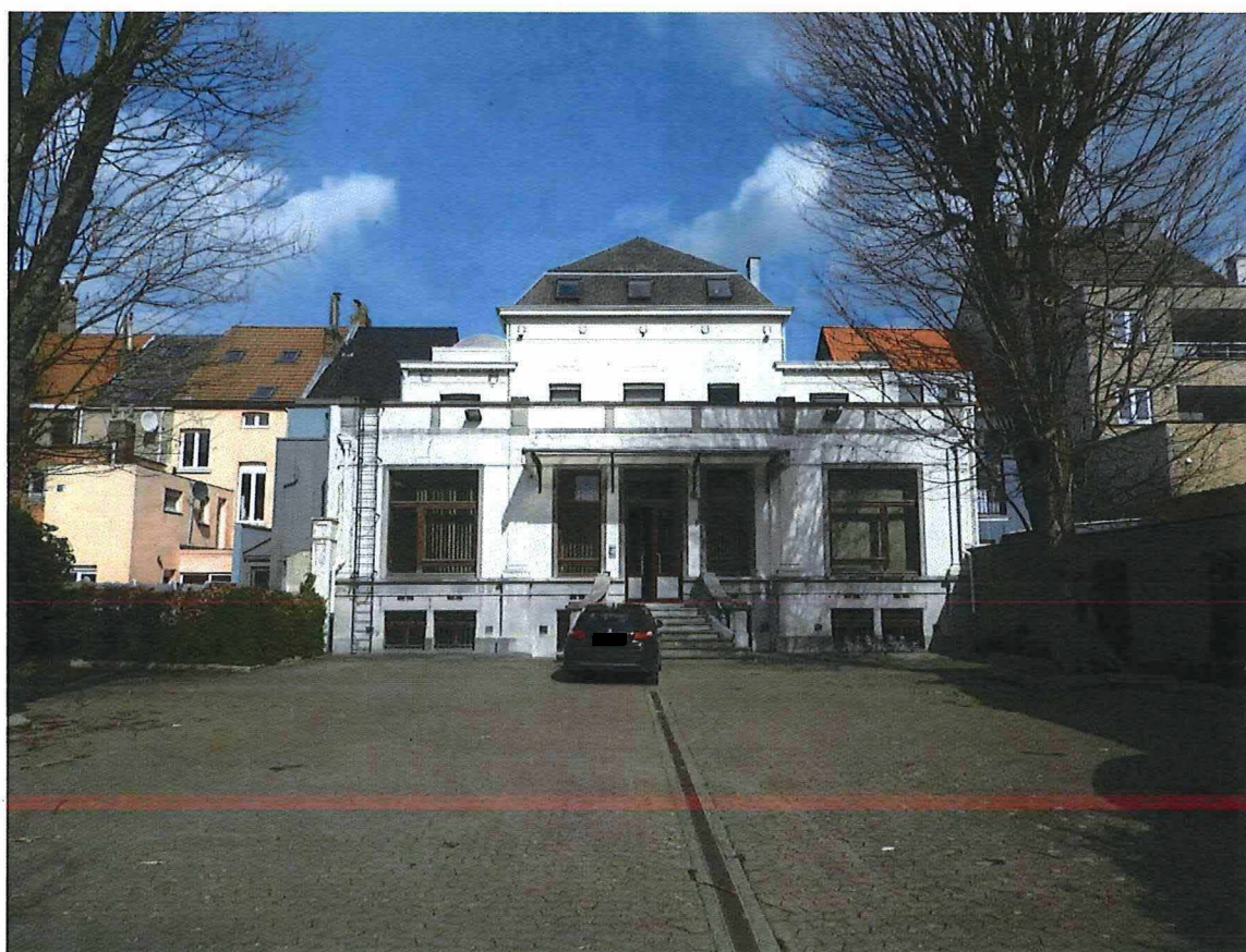
Foto 4: Achtergevel directeurswoning Keller gezien vanop de achterliggende verharde koer (14/03/2018).
