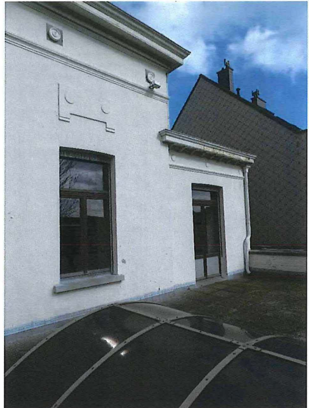
Foto 16: Achtergevel directeurswoning Keller. Zicht op de rechter zijtravee ter hoogte van de tweede bouwlaag (14/03/2018).
