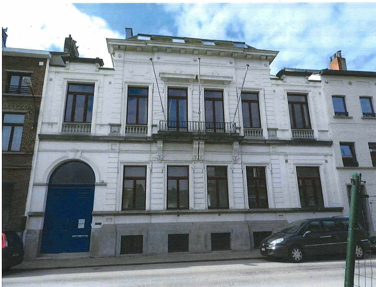
Foto 1: Voorgevel directeurswoning Keller (24/04/2017).
