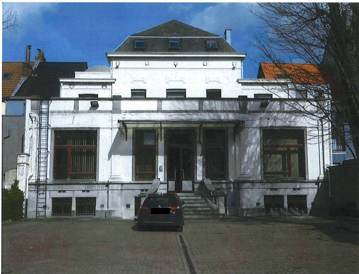
Foto 3: Achtergevel directeurswoning Keller (14/03/2018).
