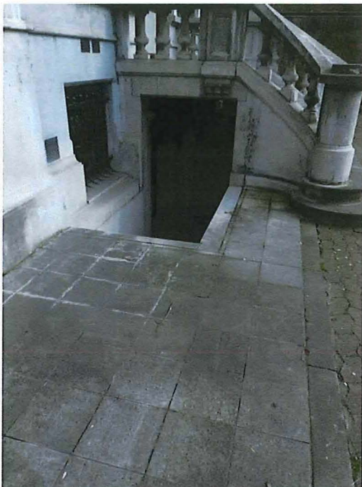
Foto 10: Achtergevel directeurswoning Keller. Een steektrap geeft toegang tot de dienstingang onder de hardstenen buitentrap (14/03/2018).
