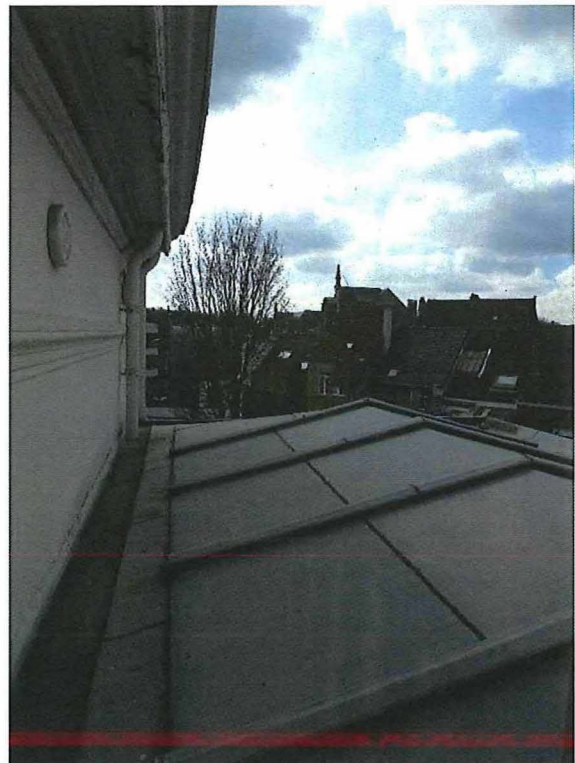
Foto 18: Westelijke zijgevel hoofdvolume directeurswoning Keller (tuinzijde). Detail fries met steigergaten en daklijst (14/03/2018).
