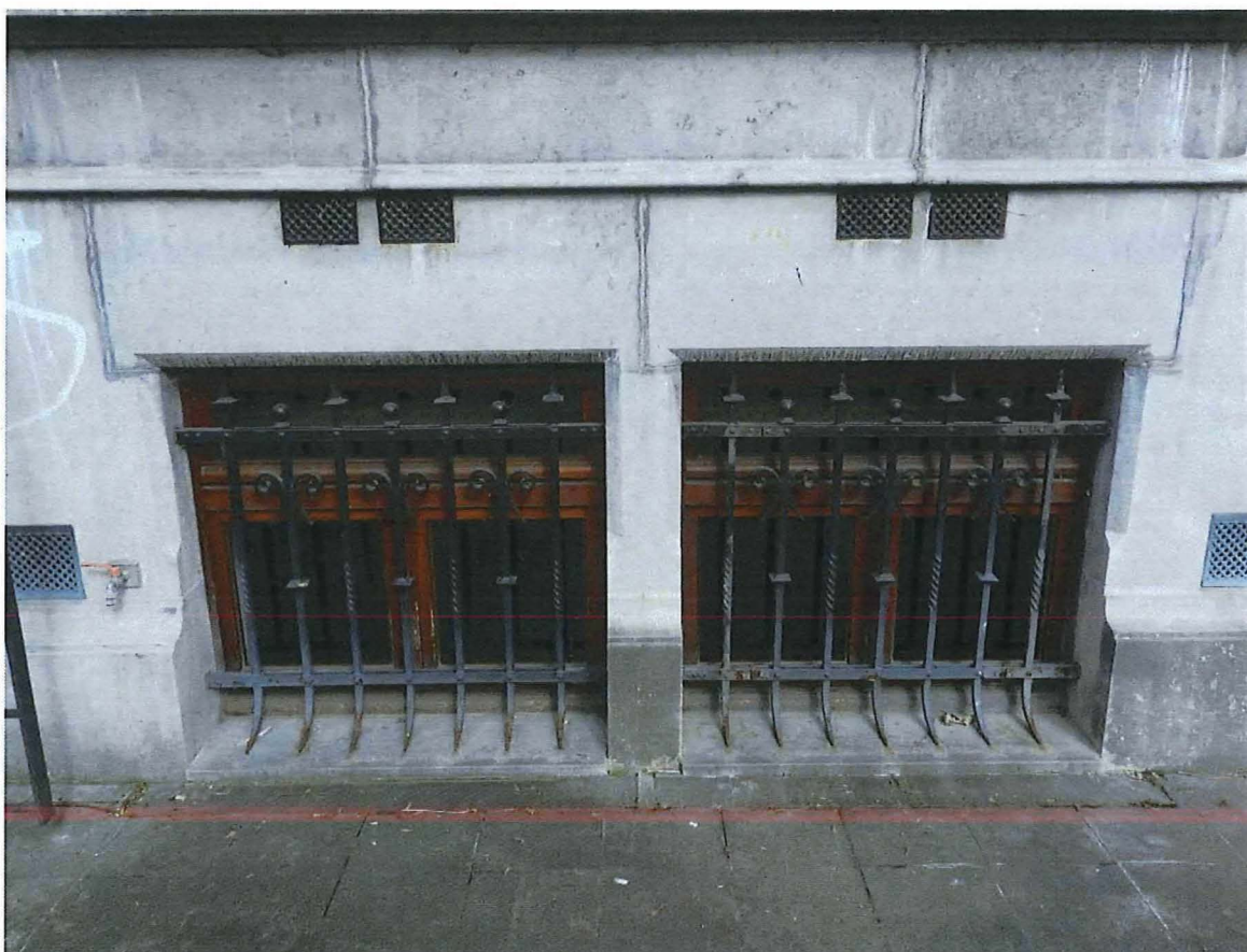
Foto 9: Achtergevel directeurswoning Keller. Detail kelderramen en verluchtingsroosters in de hardstenen plint (14/03/2018).
