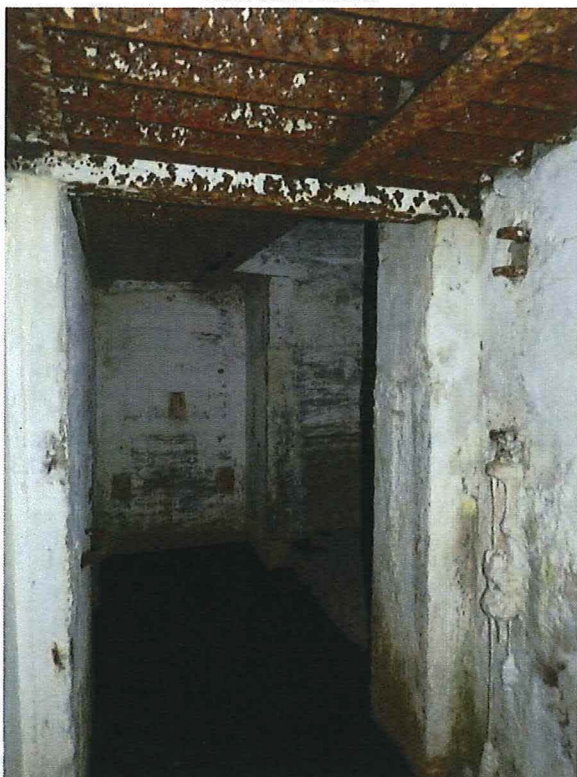
Foto 31: Bunker 16 (type IX): interieur. Foto genomen op 13 februari 2018.
