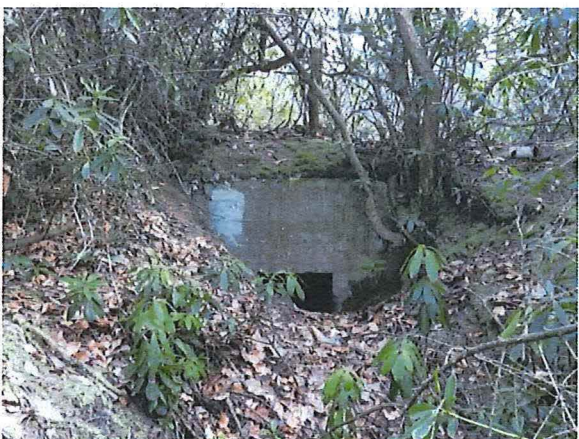
Foto 84: Bunker 42 (type IX). Foto genomen op 21 februari 2018.
