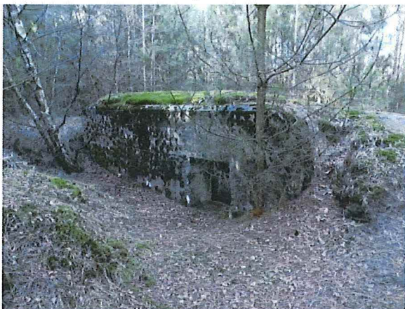
Foto 29: Bunker 16 (type IX). Foto genomen op 13 februari 2018.
