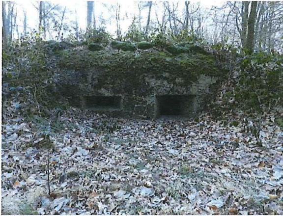
Foto 94: Bunker 46 (type IV): muuropeningen frontzijde. Foto genomen op 21 februari 2018.
