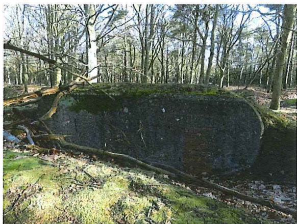
Foto 43: Bunker 21 (type XVII). Foto genomen op 16 februari 2018.
