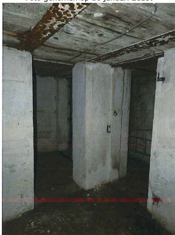
Foto 148: Bunker 69 (type XVI): interieur. Foto genomen op 16 januari 2019.
