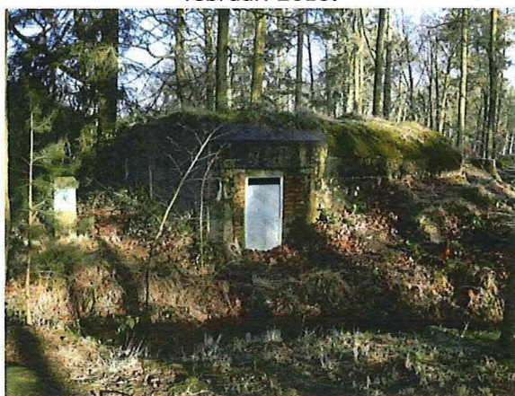
Foto 140: Bunker 66 (type II). Foto genomen op 16 februari 2018.
