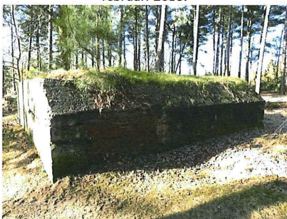
Foto 3: Bunker 2 (type II): dichtgemetselde toegangszijde. Foto genomen op 13 februari 2018.
