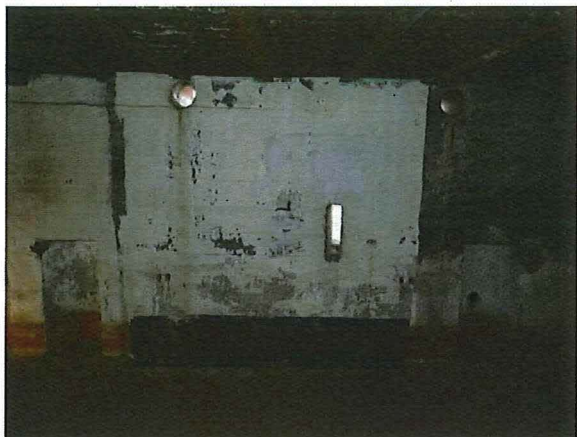
Foto 135: bunker 63 (type VII): zicht op achtermuur binnenzijde. Foto genomen op 21 februari 2018.
