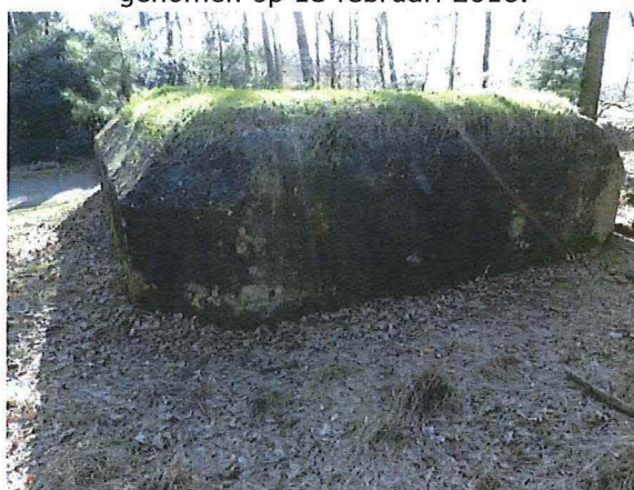
Foto 4: Bunker 2 (type II): noordelijke frontzijde. Foto genomen op 13 februari 2018.
