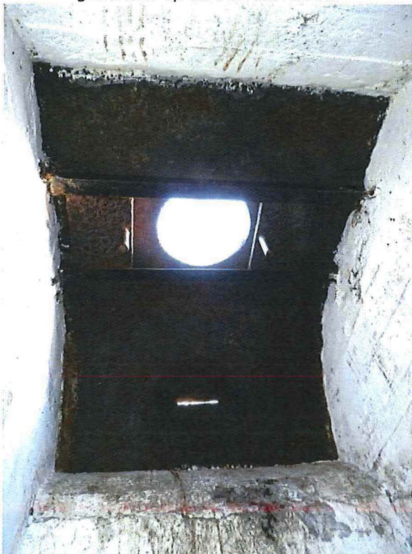
Foto 109: Bunker 52 (type X): pantserplaat met schuiven. Foto genomen op 21 februari 2018.
