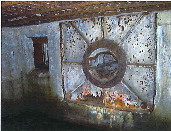
Foto 117: Bunker 57 (type VIII): dichtgemetselde schietopening frontzijde met bouten plaataffuit. Foto genomen op 21 februari 2018.
