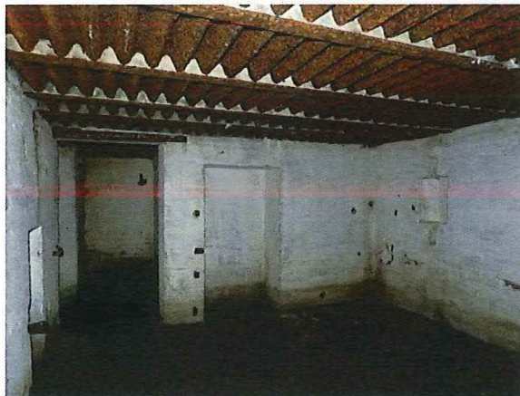
Foto 14: Bunker 7 (type VI): interieur. Foto genomen op 13 februari 2018.
