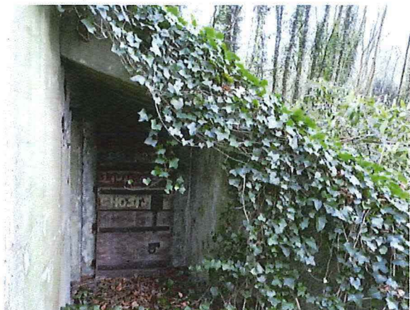
Foto 149: Bunker 69 (type XVI): overkapping toegang zuidwestelijke hoek. Foto genomen op 16 januari 2019.
