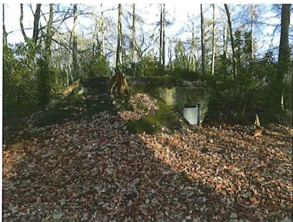
Foto 82: Bunker 41 (type XVII). Foto genomen op 16 februari 2018.
