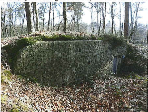
Foto 137: Bunker 64 (type XVII). Foto genomen op 21 februari 2018.
