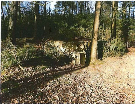
Foto 21: Bunker 12 (type IX). Foto genomen op 13 februari 2018.
