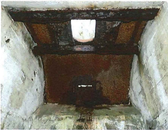
Foto 23: Bunker 12 (type IX): pantserplaat aan binnenzijde. Foto genomen op 13 februari 2018.
