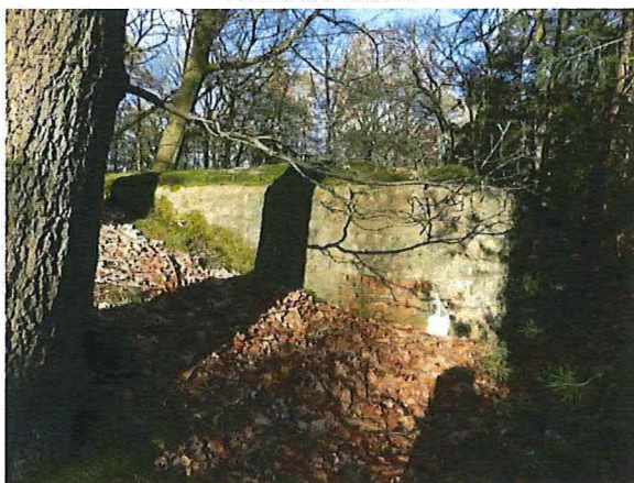
Foto 73: Bunker 37 (type IX). Foto genomen op 16 februari 2018.
