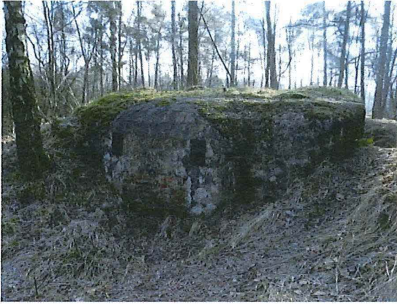
Foto 117: Bunker 57 (type VIII): dichtgemetselde schietopening frontzijde met bouten plaataffuit. Foto genomen op 21 februari 2018.
