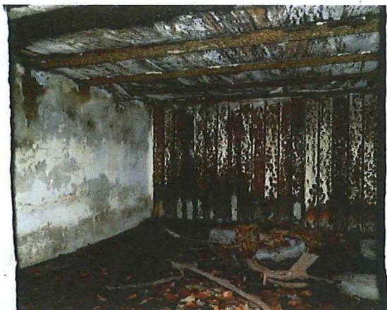
Foto 143: Bunker 67 (type II): stalen bekleding aan frontmuur binnenzijde. Foto genomen op 21 februari 2018.
