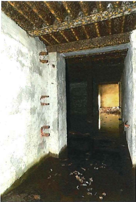
Foto 76: Bunker 38 (type VI): interieur met verticale balk. Foto genomen op 16 februari 2018.
