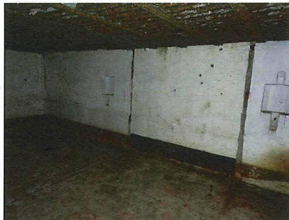
Foto 136: Bunker 63 (type VII): zicht op frontmuur binnenzijde. Foto genomen op 21 februari 2018.
