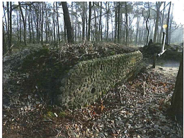
Foto 97: Bunker 47 (type IX). Foto genomen op 21 februari 2018.
