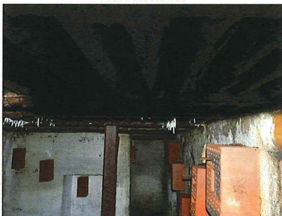
Foto 17: Bunker 9 (type VI): interieur. Foto genomen op 13 februari 2018.
