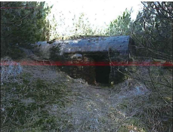
Foto 27: Bunker 15 (type IV). Foto genomen op 13 februari 2018.
