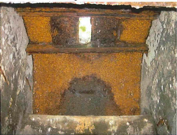
Foto 98: Bunker 48 (type XIV). Pantserplaat met ronde observatieopening bovenaan, die deels met schuiven is gedicht, en kleine observatiegleuf. Foto genomen door Tom Oliviers op 17 juli 2013.
