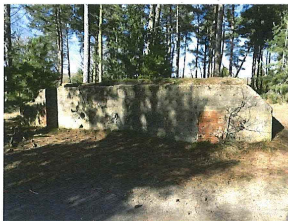
Foto 2: Bunker 1 (type VI): toegangszijde. Foto genomen op 13 februari 2018.
