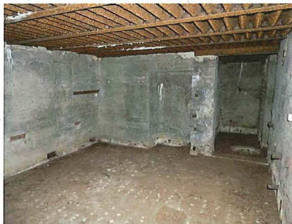
Foto 51: Bunker 26 (type VI): interieur. Foto genomen op 16 februari 2018.
