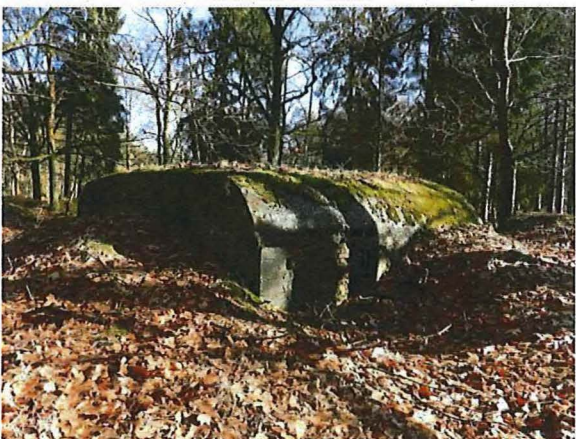
Foto 52: Bunker 27 (type IV): dichtgemetselde toegang. Foto genomen op 16 februari 2018.
