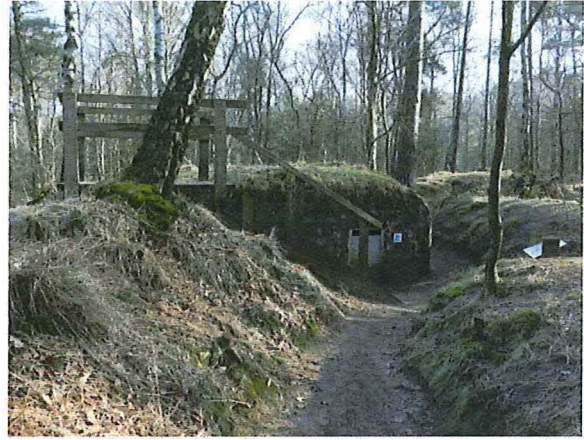
Foto 118: Bunker 57 (type VIII): toegang en uitkijkpunt. Foto genomen op 21 februari 2018.
