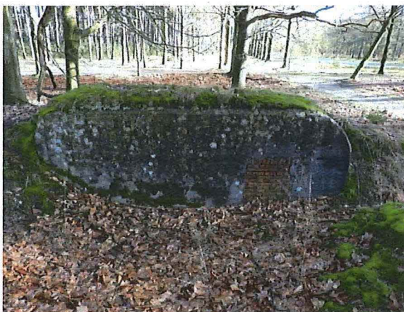
Foto 47: Bunker 24 (type IX). Foto genomen op 16 februari 2018.
