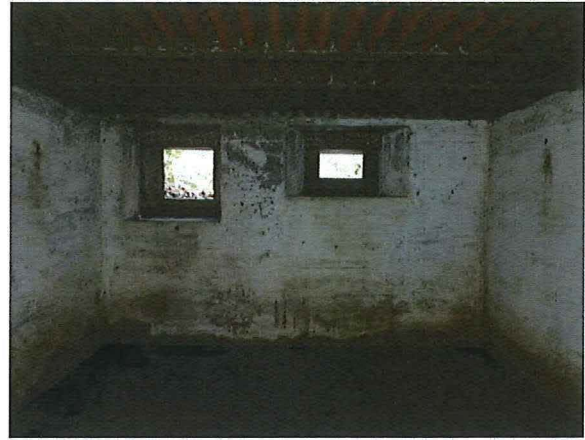
Foto 95: Bunker 46 (type IV). Muuropeningen frontzijde in binnenruimte. Foto genomen op 21 februari 2018.
