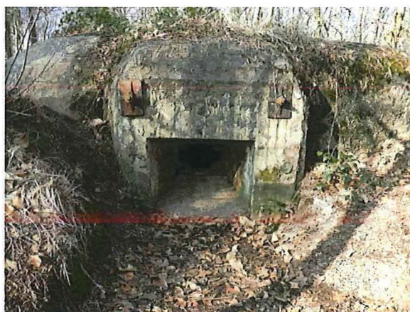
Foto 127: Bunker 60 (type VIII): schietopening. Foto genomen op 21 februari 2018.
