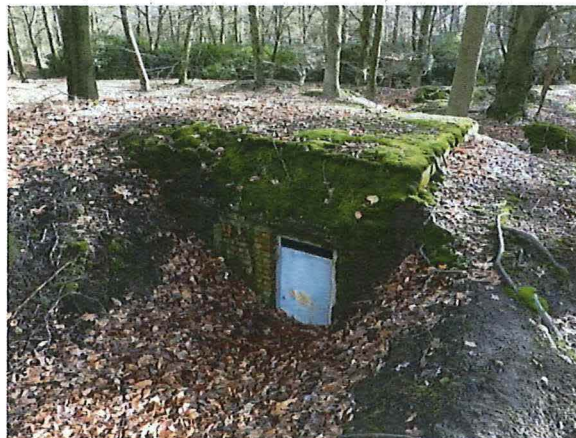
Foto 69: Bunker 34 (type II). Foto genomen op 16 februari 2018.
