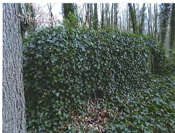
Foto 146: Bunker 69 (type XVI): westelijke zijde. Foto genomen op 16 januari 2019.
