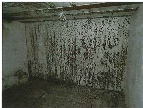
Foto 150: Bunker 69 (type XVI): stalen bekleding tegen binnenmuur frontzijde grootste ruimte. Foto genomen op 16 januari 2019.
