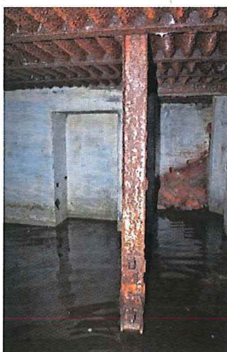
Foto 87: Bunker 43 (type VI): Verticale stalen balk in bunker. Foto genomen door Tom Oliviers op 13 september 2016.
