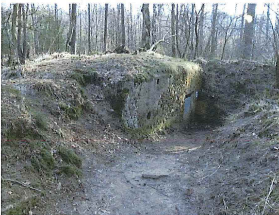
Foto 121: Bunker 58 (type IX). Foto genomen op 21 februari 2018.
