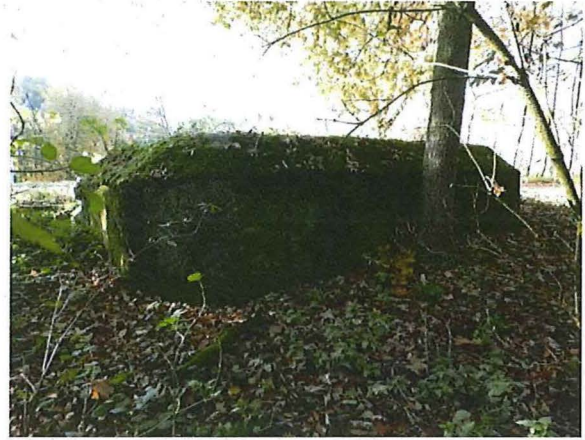
Foto 25: Zicht op de bunker vanaf noordelijke zijde.
