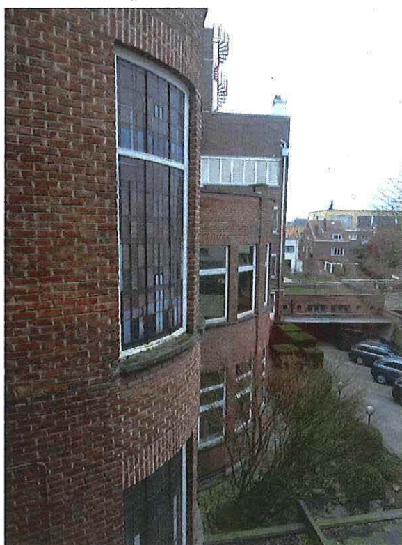
Foto 11: Secretariaat en kantoren ACLVB, achterbouw, noordgevel, detail traphal.
