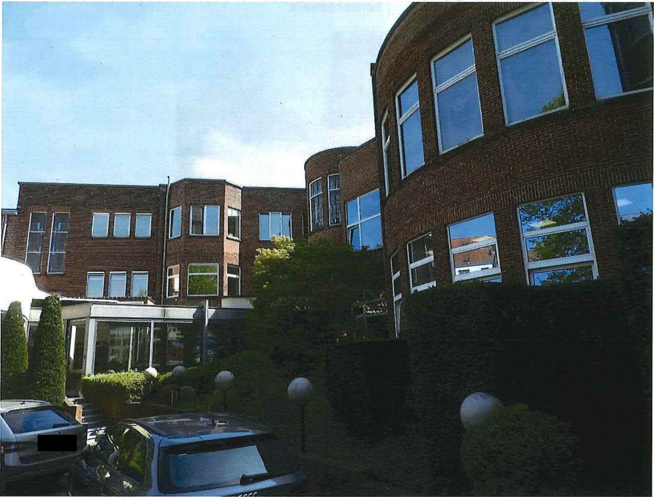
Foto 14: Woning Velghe en Secretariaat en kantoren ACLVB, achtergevels (west) en zijgevel achterbouw (noord), zicht vanuit het binnengebied.
