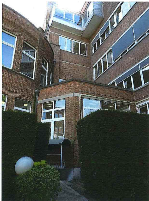
Foto 15: Kantoren ACLVB; achterbouw, verbinding tussen bouwphase 1937 en kantoortoren van 1955.
