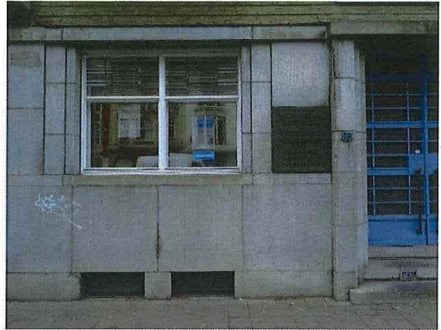
Foto 6: Detail linkertravee, gelijkvloerse verdieping.
