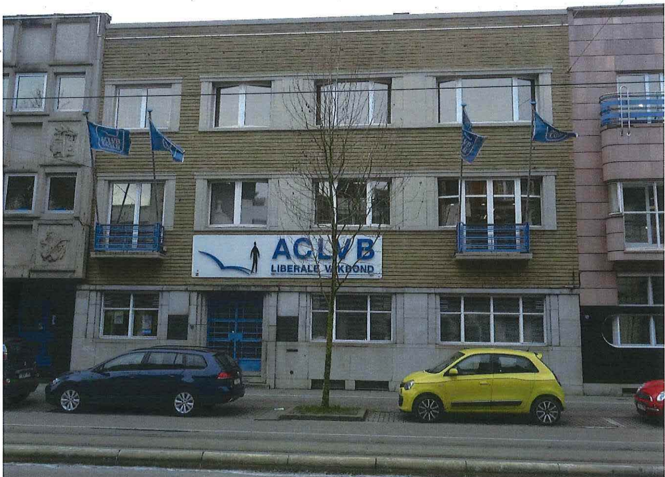
Foto 4: Secretariaat en kantoren ACLVB, Koning Albertlaan 95, voorbouw, straatgevel.
