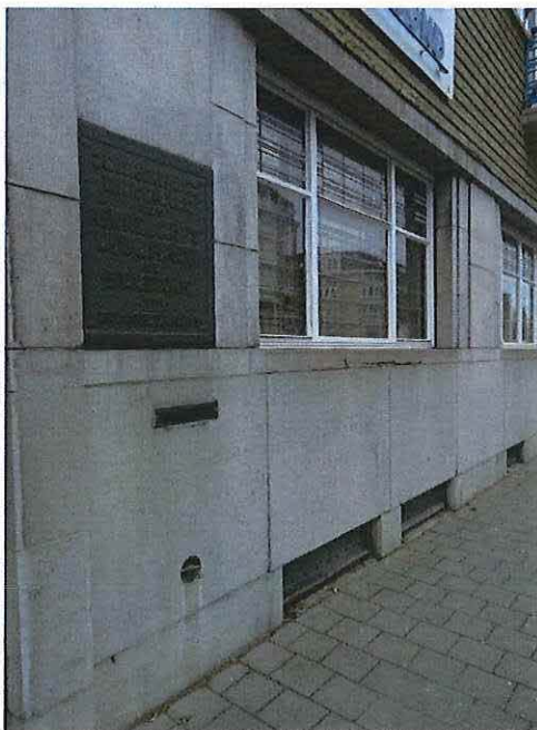
Foto 8: Detail derde travee, gelijkvloerse verdieping.
