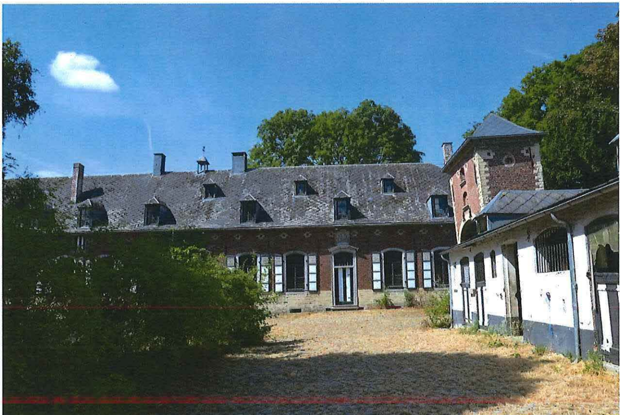
Foto 25: Erfgevel van de noordwestelijke vleugel met boerenwoning. Rechts de straatvleugel met poortgebouw en paardenstallen.
