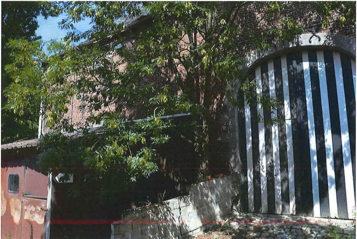
Foto 10: De veldpoort in de nagenoeg gesloten buitengevel, met links aangebouwde paardenboxen.
