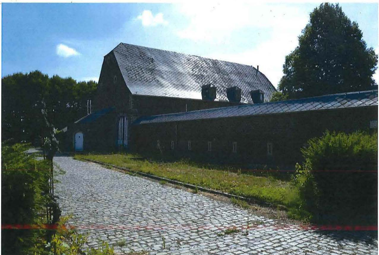
Foto 2: Straatvleugel met verluchtigsgaten ('asemgaten'). Links de schuur met aanbouw uit 1932, aangepast in 1970 en 1985.
