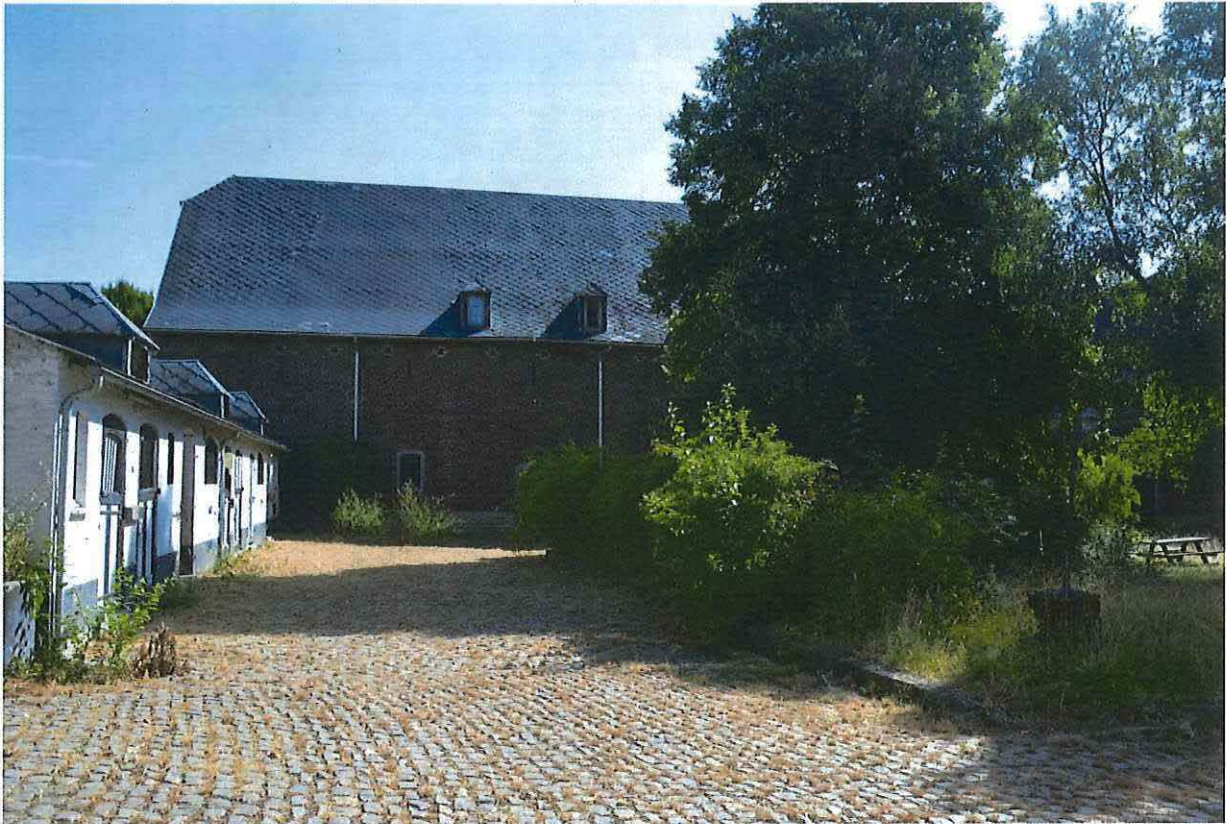
Foto 15: Gekasseide binnenplaats, met zicht op de paardenstallen tegen de straatgevel en de erfgevel van de schuur.
