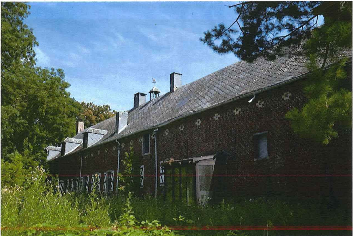
Foto 12: De buitengevel van de noordwestelijke vleugel met boerenwoning, rentmeesterswoning, tussenruimte (met veranda) en paardenstallen.
