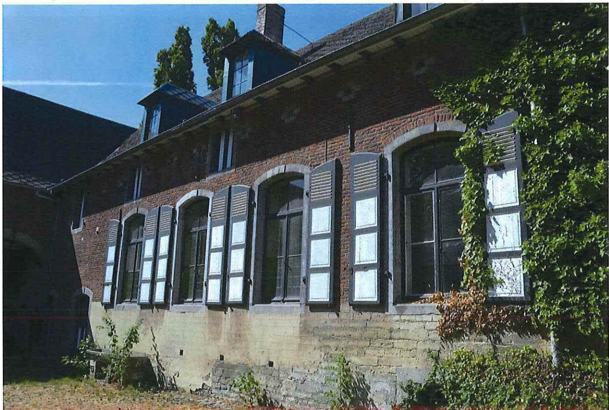
Foto 18: Erfgevel rentmeesterswoning, met links de twee deuren van de aanpalende tussenruimte en de stal. Uiterst links bevindt zich de veldpoort.
