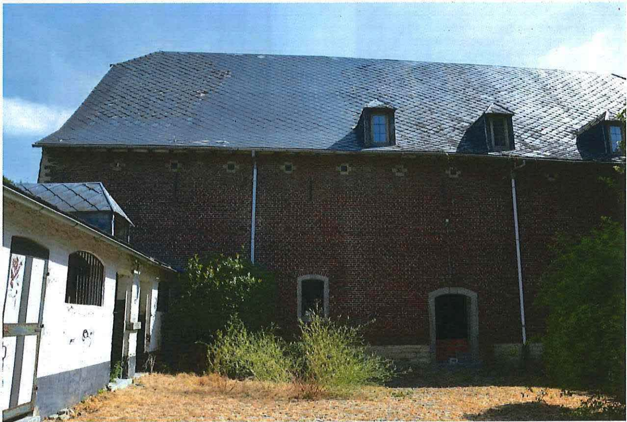
Foto 24: Erfgevel van de schuur, met links de aanpalende paardenstallen aan de straatvleugel.
