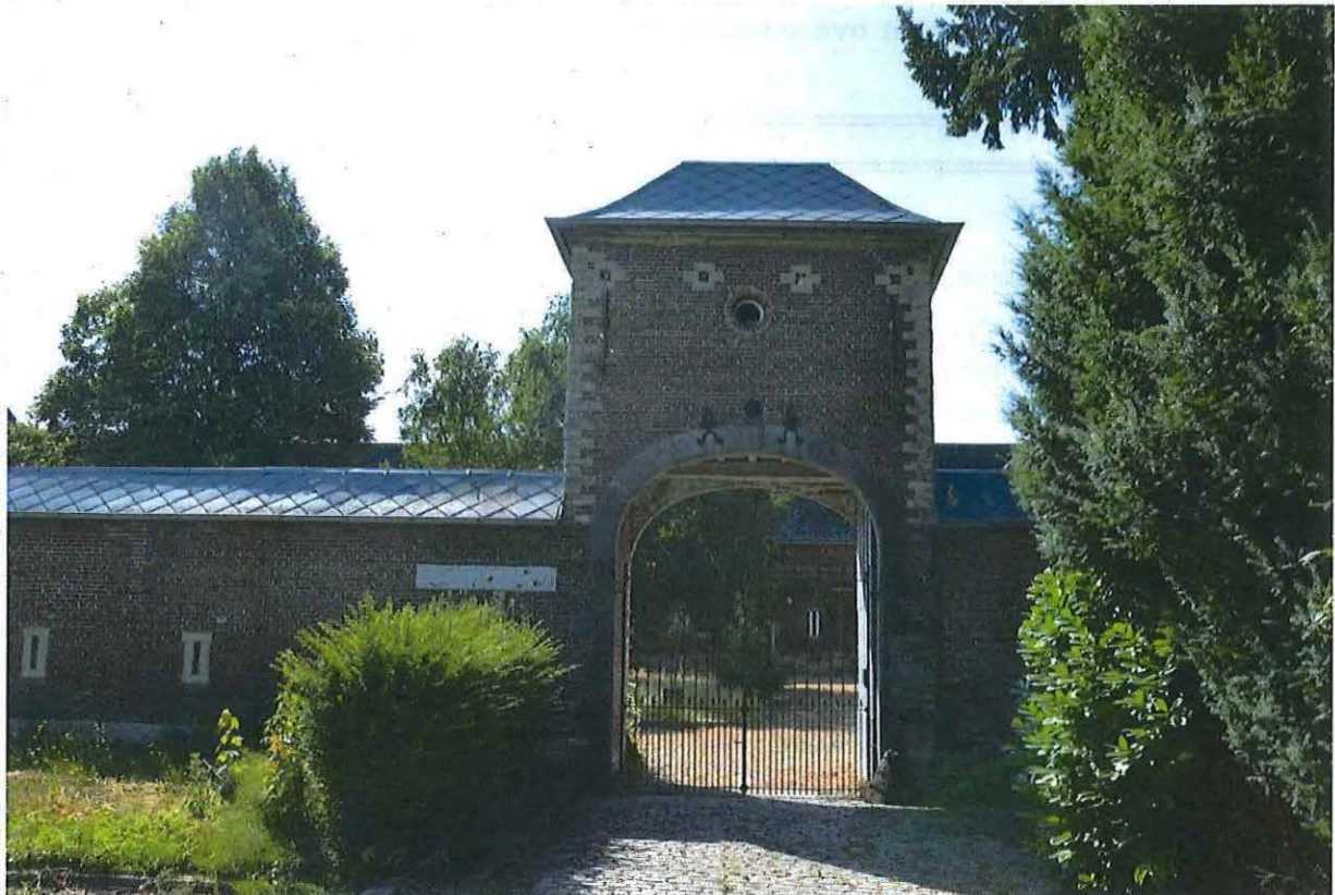
Foto 1: Hof ten Brukom, gezien vanaf de Bergensesteenweg. De straatvleugel met het poortgebouw met duiventil.
