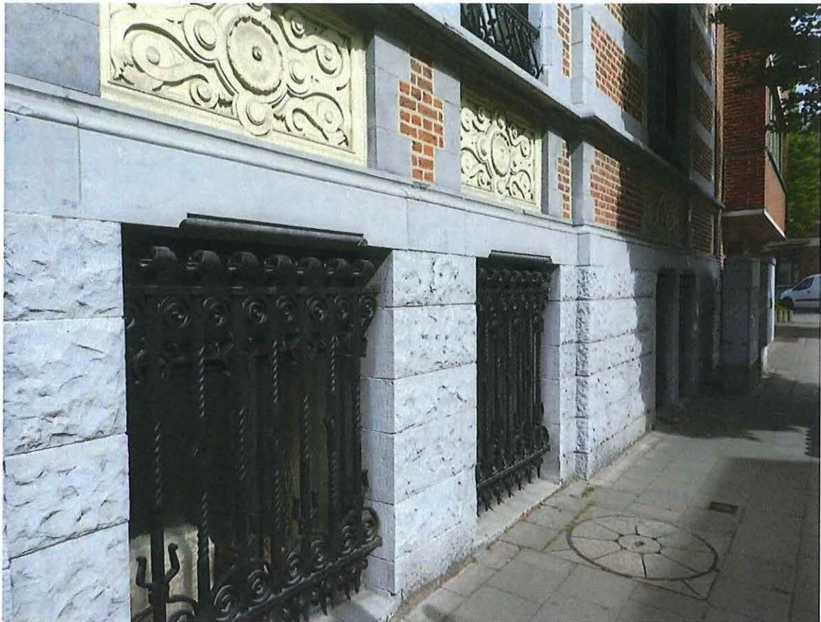
Foto 13: Detail onderbouw herenwoning Delacre (18 juni 2018).
