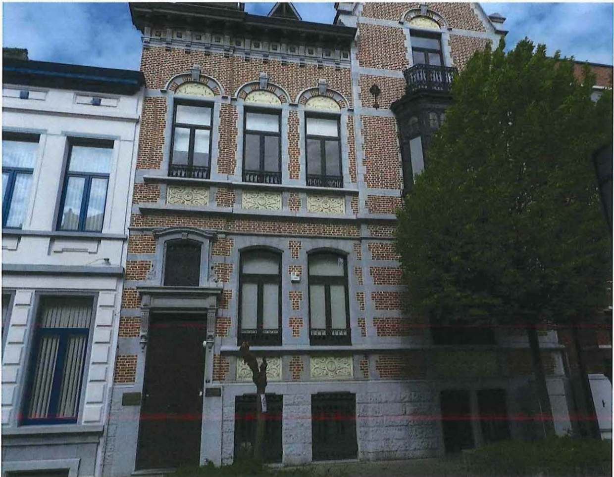
Foto 6: Detail lijstgevel herenwoning Delacre (18 juni 2018).
