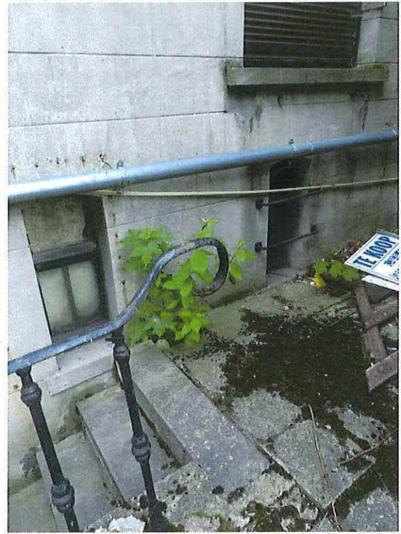
Foto 22: Detail balusterborstwering (18 juni 2018).
