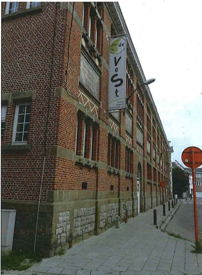
Foto 4: Voorgevel aan de Vestenstraat, hoek met Achterham.
