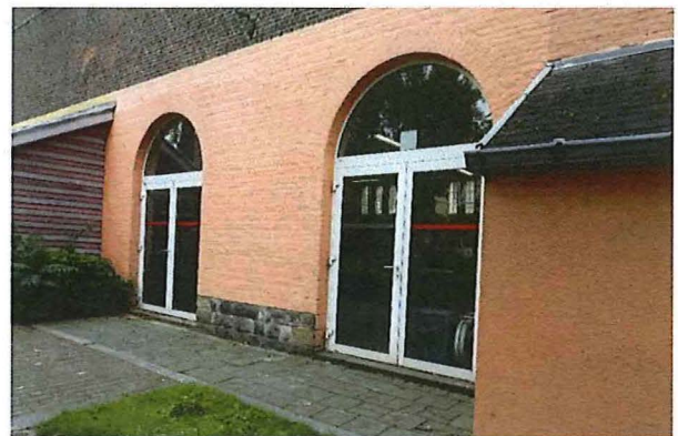
Foto 26: Gelijkvloerse verdieping, voormalige muuropeningen tot de overdekte speelplaats.
