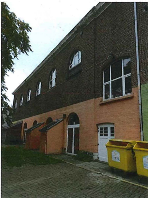
Foto 27: Achtergevel, de zeven noordwestelijke traveeën.
