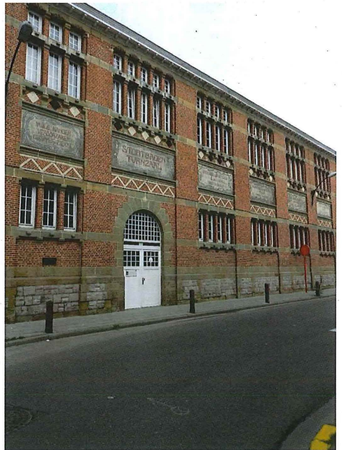
Foto 5: Voorgevel, detail toegang tot badhuis en turnzaal, en flankerende traveeën.
