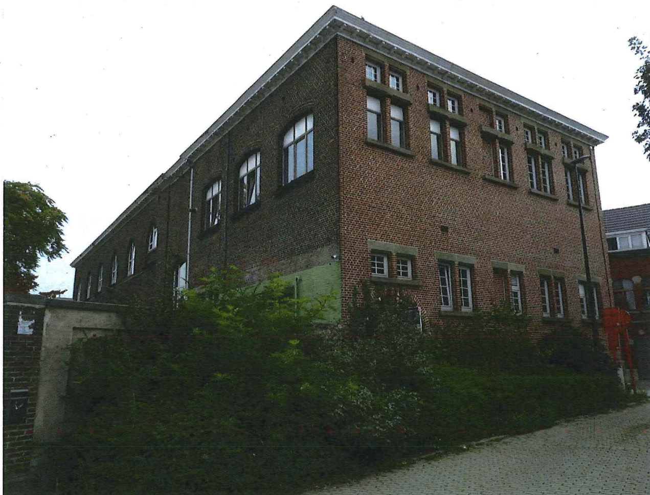
Foto 22: Zijgevel (zuidwest) en achtergevel (noordwest) van de schoolvleugel, zicht vanaf Achterham.
