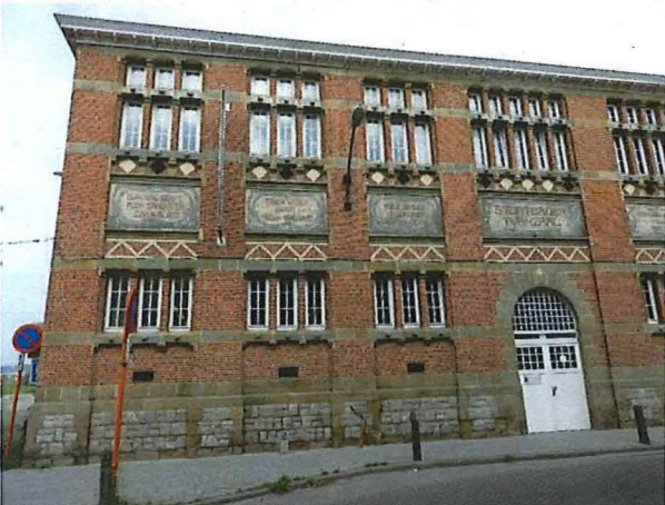
Foto 8: Linkertraveeën met voormalige stookplaats (beneden) en badhuis (boven).
