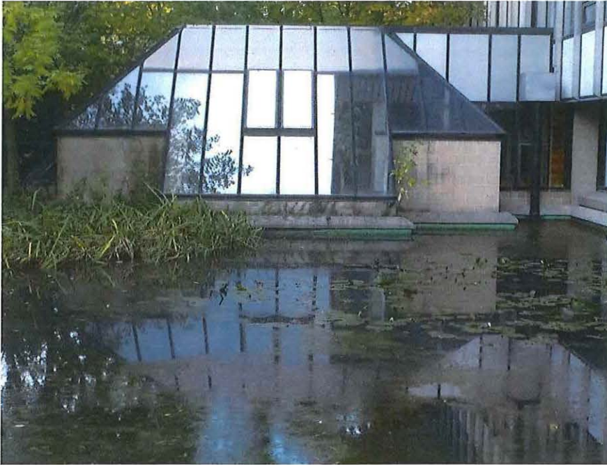
Foto 13 : blok G (noordwestgevel, leraarskamer), Henleykaai 83-84 (6 november 2018).
