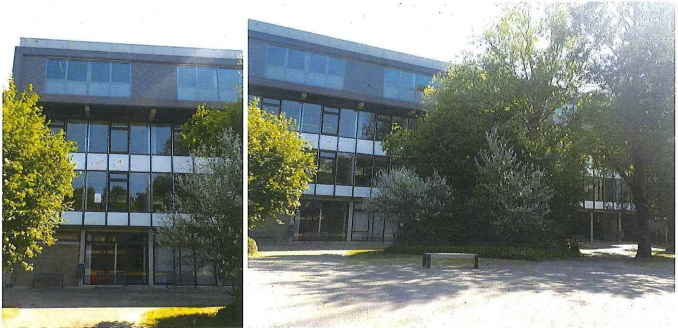
Foto 36-37 : blok B (zuidwestgevel), Abdisstraat 56 (28 juni 2018).
