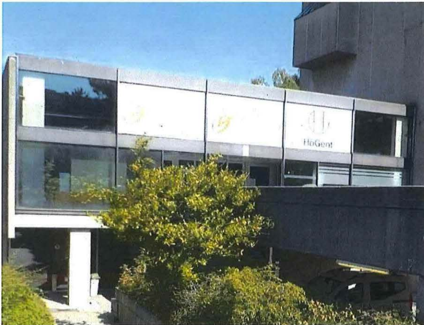
Foto 14 : blok A (zuidoostgevel), Abdisstraat 56 (28 juni 2018).
