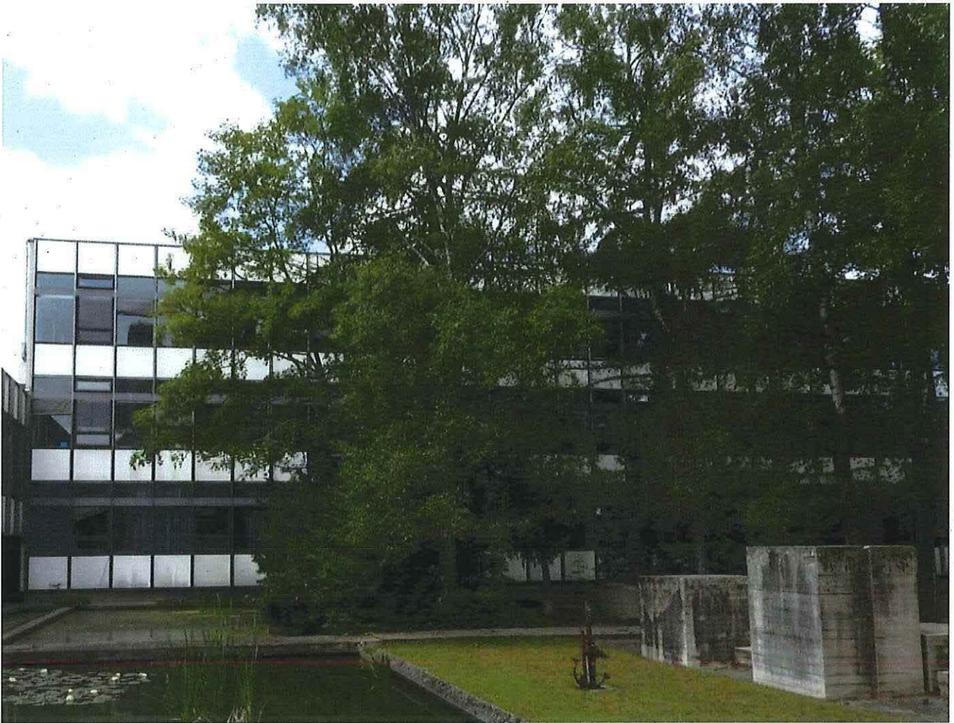
Foto 25 : blok E (zuidoostgevel), Abdisstraat 56 (13 juni 2018).
