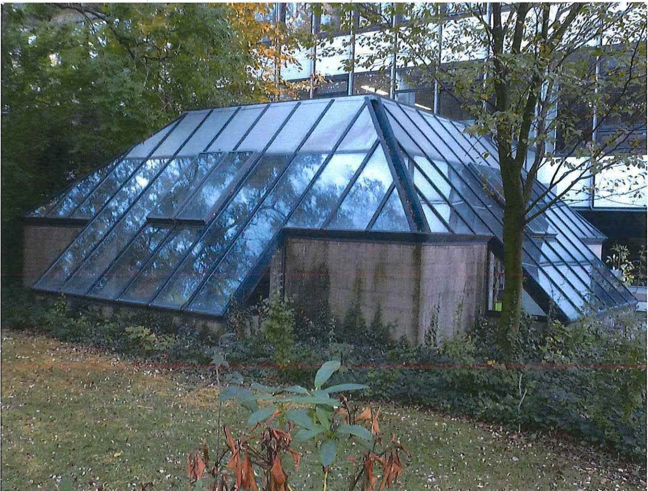
Foto 12 : blok G (noordwestgevel, leraarskamer), Henleykaai 83-84 (6 november 2018).
