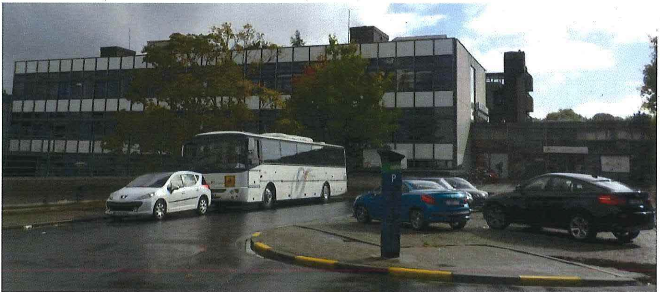
Foto 28 : blok E en ingang blok A, Abdisstraat 56 (5 december 2017).
