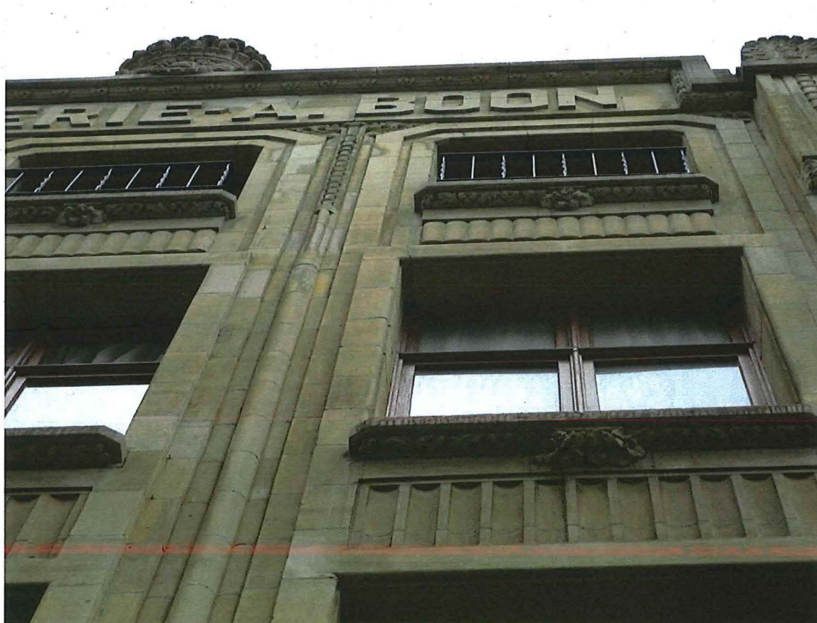
Foto 13: Ganterie A. Boon, voorgevel – tweede en derde verdieping – details gevelafwerking.
