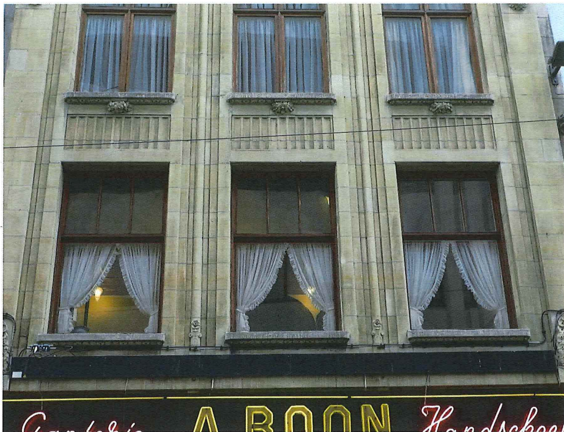
Foto 9: Ganterie A. Boon, voorgevel – puilijst en eerste verdieping.
