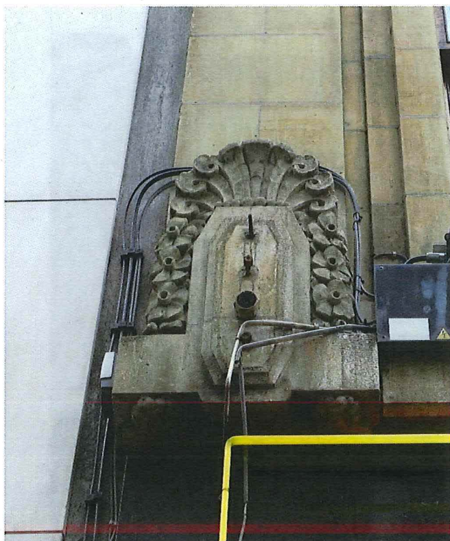
Foto 10: Ganterie A. Boon, voorgevel – detail van een gestileerd medaillon in de puilijst waar volgens het bouwplan de thans verdwenen metalen uithangborden met opschrift 'A. Boon' waren verankerd.
