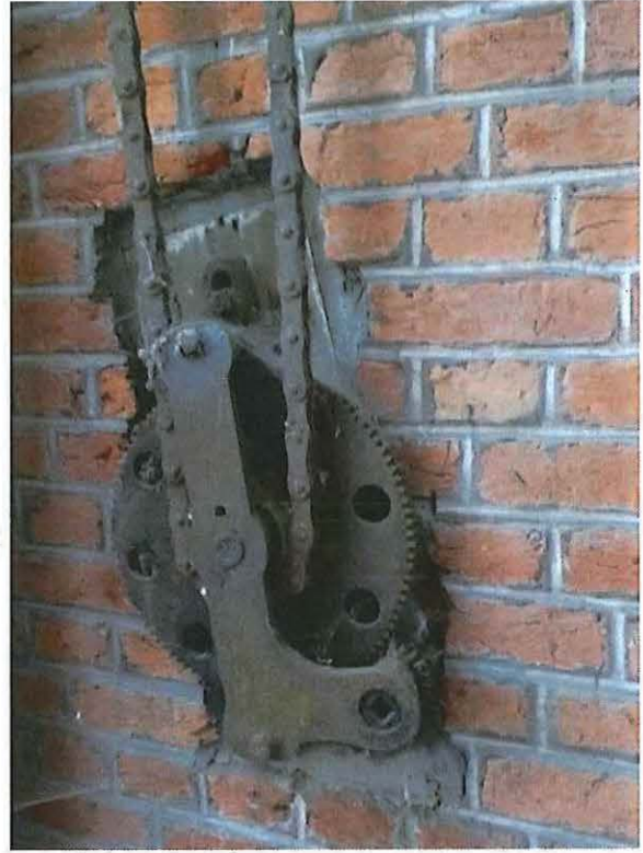
Foto 34: Noordgevel van de voormalige directeurswoning Dassonville, detail rolluikstelsel.
