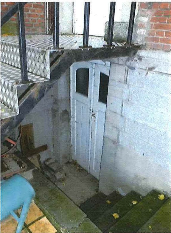
Foto 31: Noordgevel van de voormalige directeurswoning Dassonville, toegang tot kelder.
