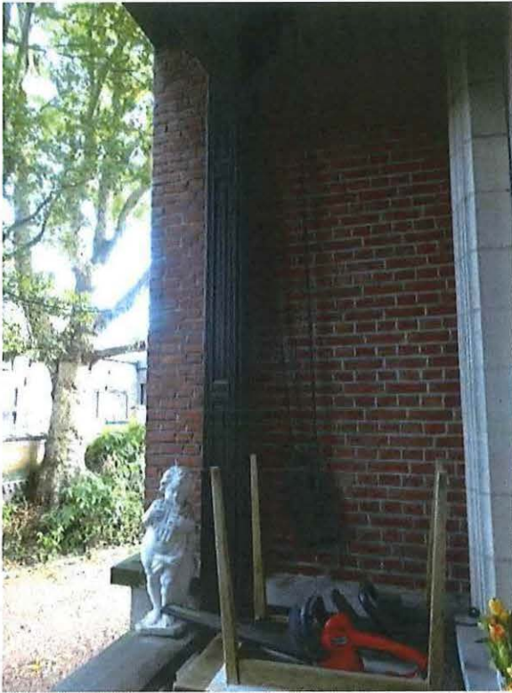
Foto 33: Noordgevel van de voormalige directeurswoning Dassonville, rolluikstelsel.
