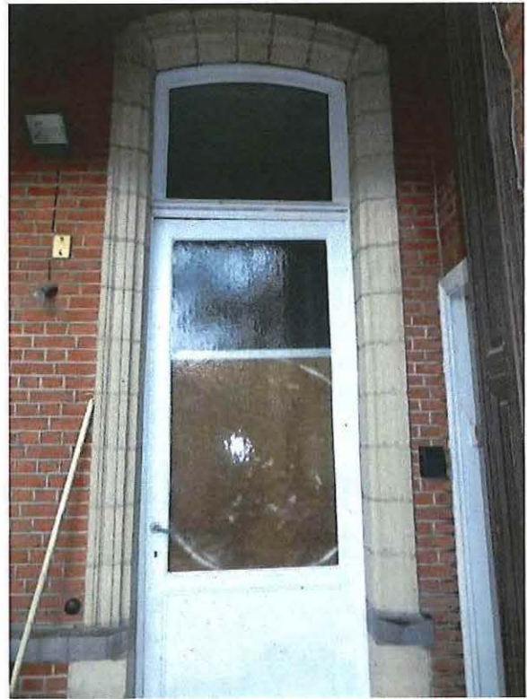
Foto 36: Noordgevel van de voormalige directeurswoning Dassonville, detail deur.
