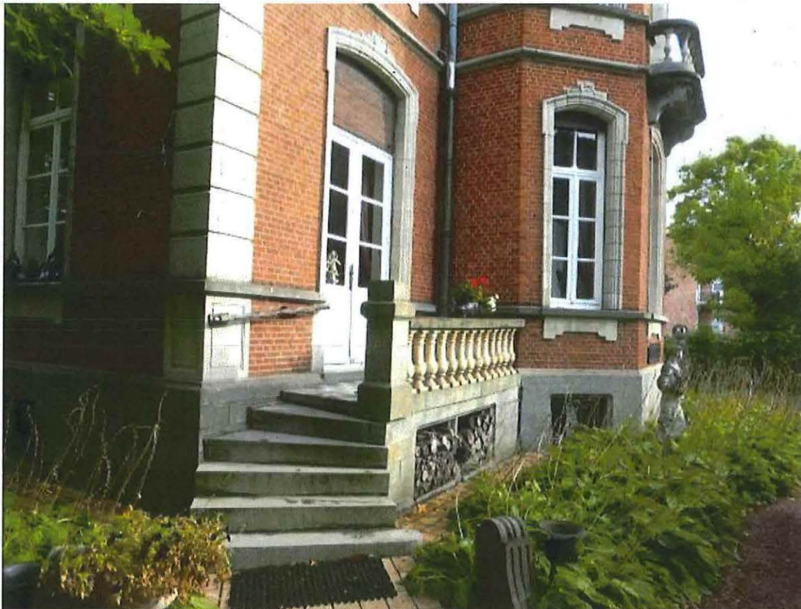
Foto 18: Zuidgevel van de voormalige directeurswoning Dasonville, kant Dorpsplein, toegangstrap.
