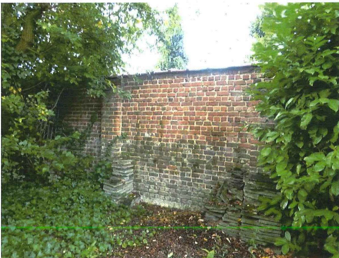
Foto 52: Tuinmuur, kant A. Dassonvillelaan.
