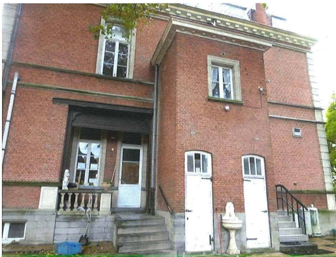
Foto 26: Noordgevel van de voormalige directeurswoning Dassonville.
