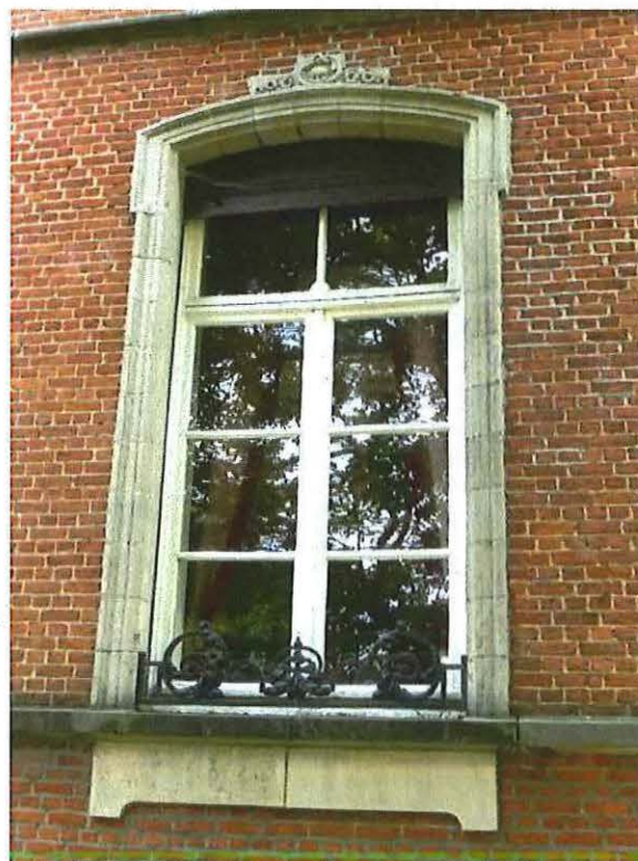
Foto 20: Zuidgevel van de voormalige directeurswoning Dasonville, kant Dorpsplein, detail vensteropening met behouden schrijnwerk getypeerd door grote roeden en mok.
