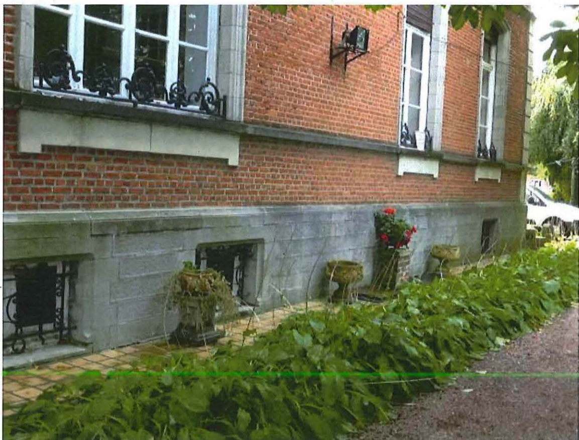
Foto 22: Westgevel van de voormalige directeurswoning Dassonville, plint met kelderopeningen.
