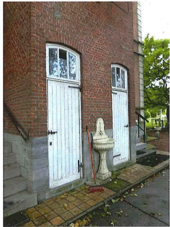
Foto 32: Noordgevel van de voormalige directeurswoning Dassonville, detail deuren van het sanitair blok.
