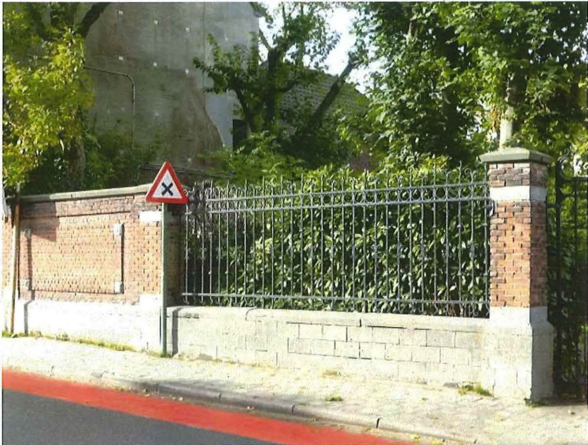
Foto 7: Tuinmuur en hekwerk aan de Izegemsestraat.
