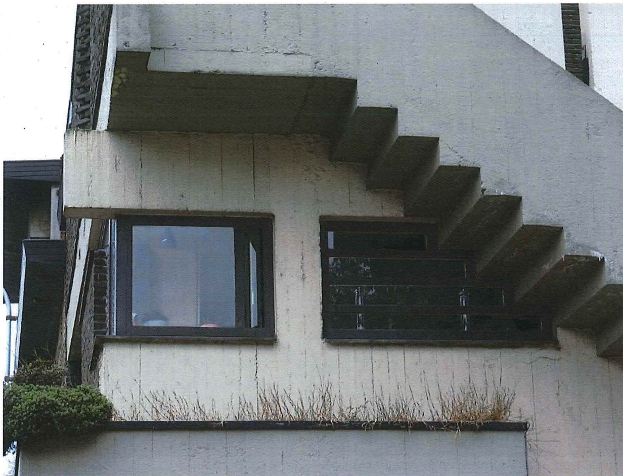
Foto 3 : keukenramen in zijgevel (13 september 2018).
