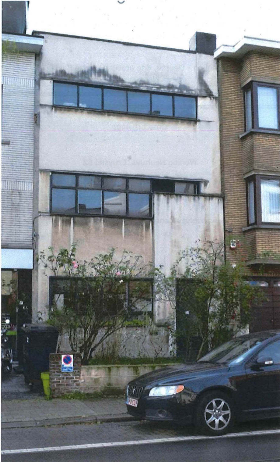
Foto 1: Voorgevel met similipleisterwerk en vensterbanden met stalen schrijnwerk
