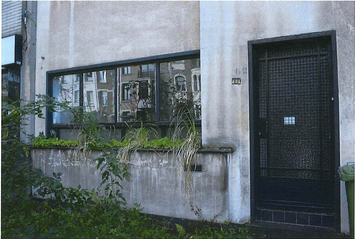
Foto 2: Voorgevel: begane grond: vensterband met stalen schrijnwerk-geïntegreerde plantenbak en brievenbus
