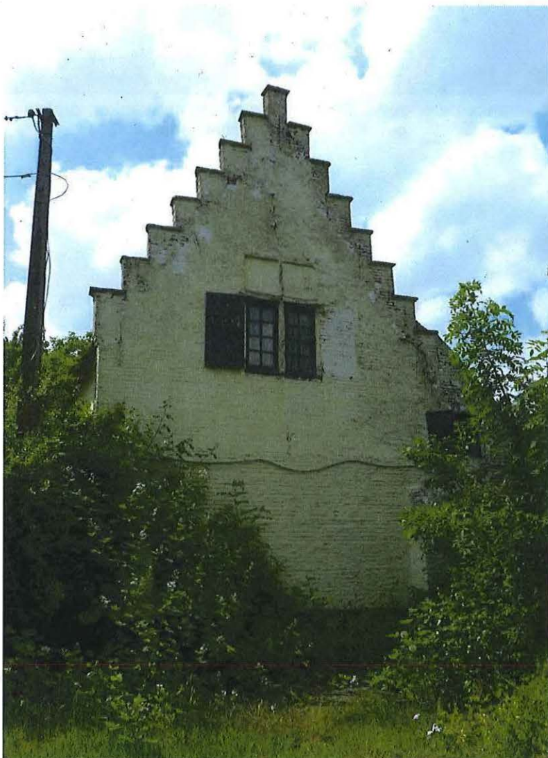
Foto 18: Boerenhuis, verankerde oostelijke zijtrapgevel met kruisvenster in geveltop, steunberen, vlechtingen in uitgelengd zadeldak
