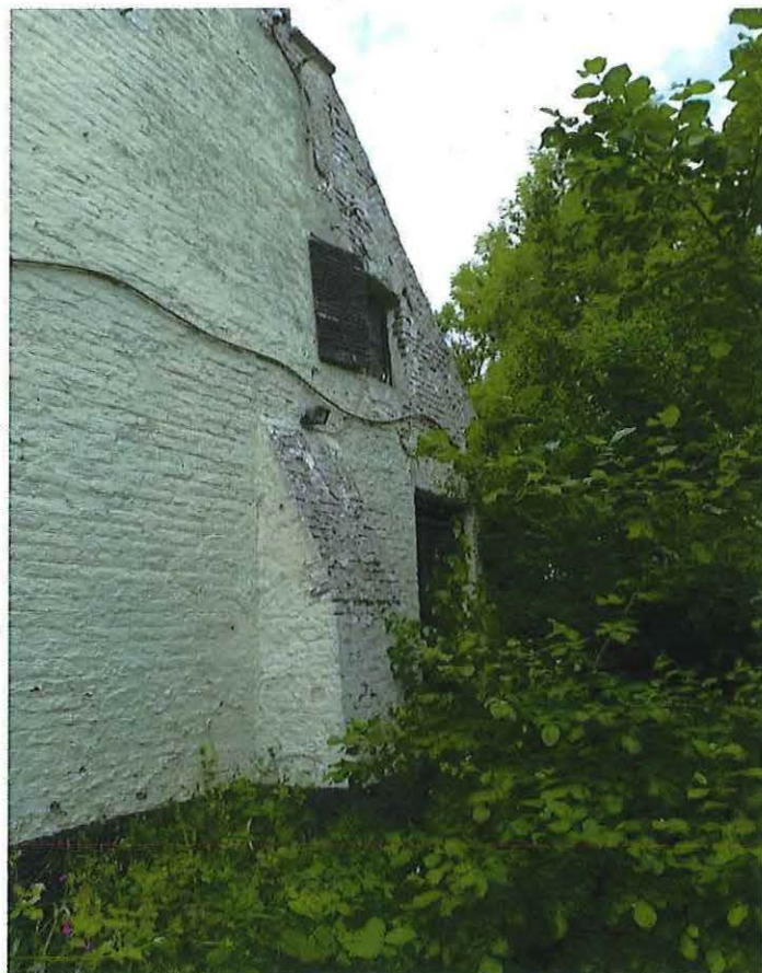
Foto 20: Boerenhuis , verankerde oostelijke zijtrapgevel met vlechtingen onder uitgelengd zadeldak, steunberen, en deur naar lagere uitbouw .
