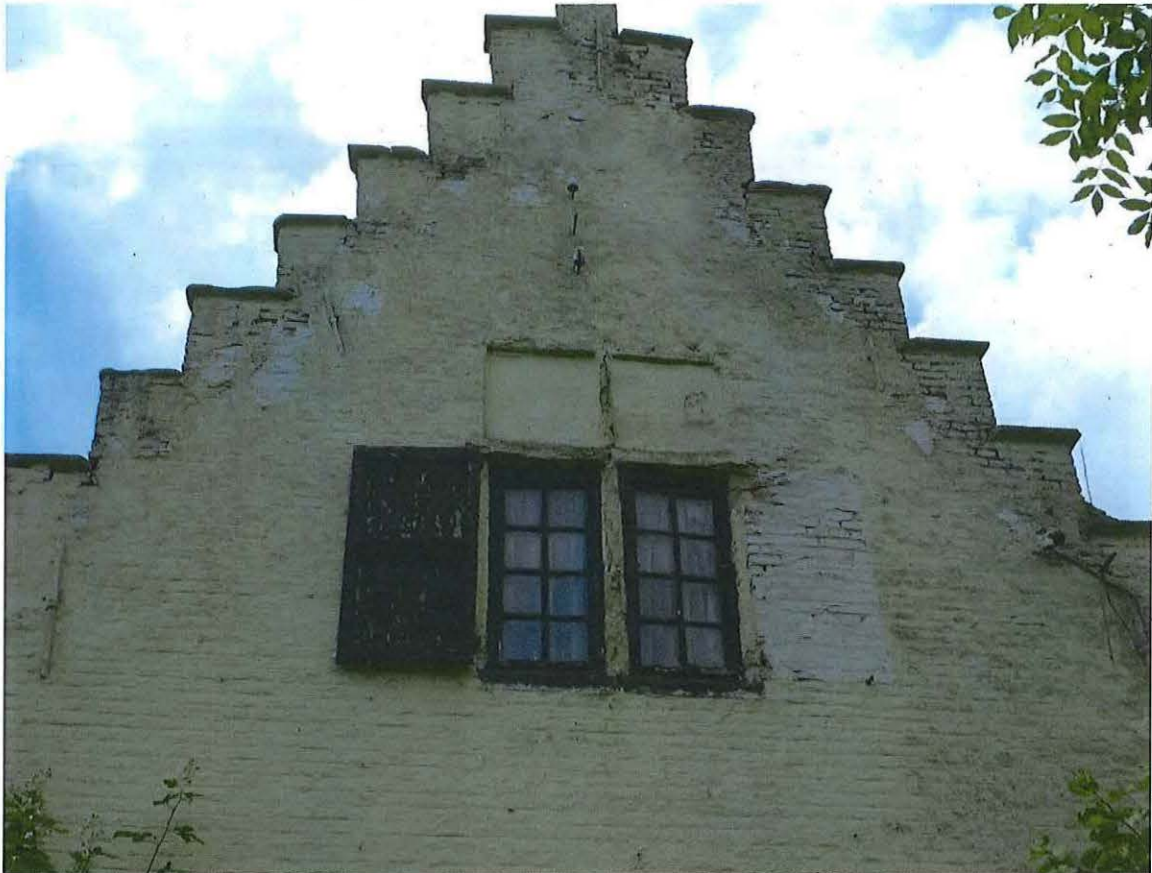
Foto 19: Boerenhuis , verankerde oostelijke zijtrapgevel met deels gedicht natuurstenen kruisvenster in geveltopy
