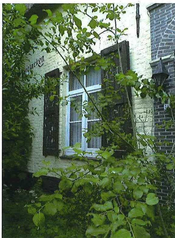
Foto 9: Boerenhuis, verankerde erfgevel, detail beluikte venster. De gedichte deur is verstopt achter de hoge struik.
