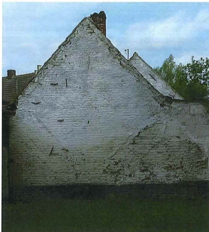
Foto 36: Bakhuis – zuidgevel met sporen van de gedichte rondboogvormige opening, wellicht de ovenkelder, nabij het maaiveld.
