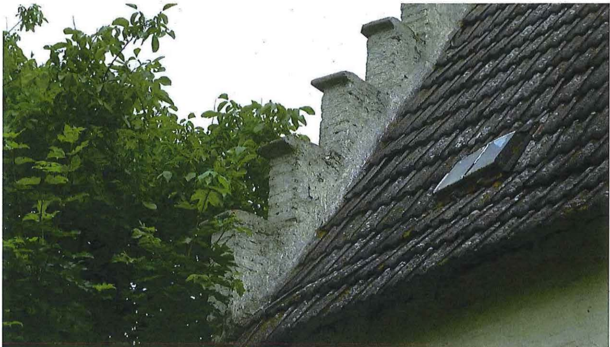
Foto 23: Boerenhuis, westelijke zijtrapgevel.
