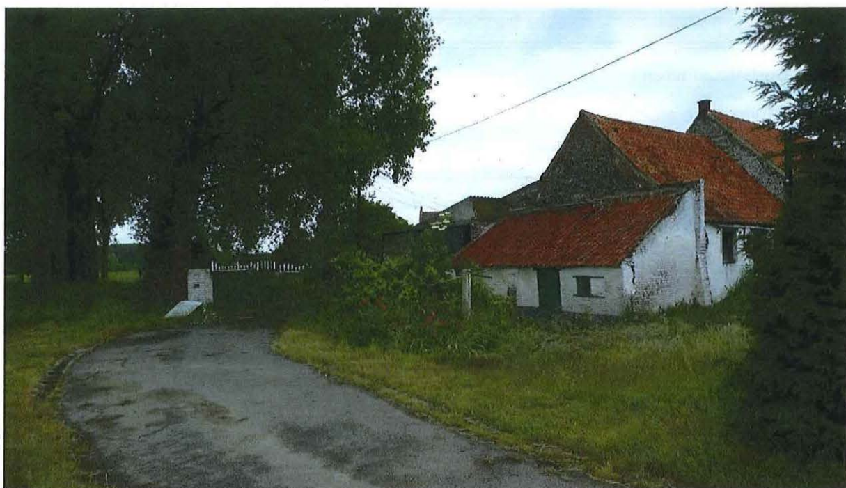
Foto 1: Verharde Boelakendreef met rechts dwarsschuur met stal en wagenhuis, centraal hekwerk aan bakstenen pijlers en links beboomde losweg
