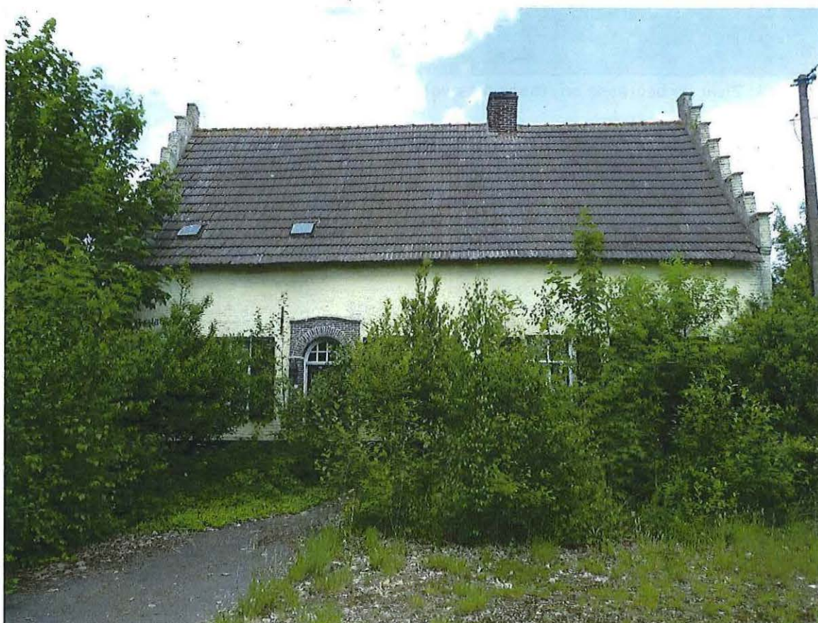
Foto 7: Boerenhuis, met zuidgerichte erfgevel, door begroeiing deels aan het gezichtsveld onttrokken
