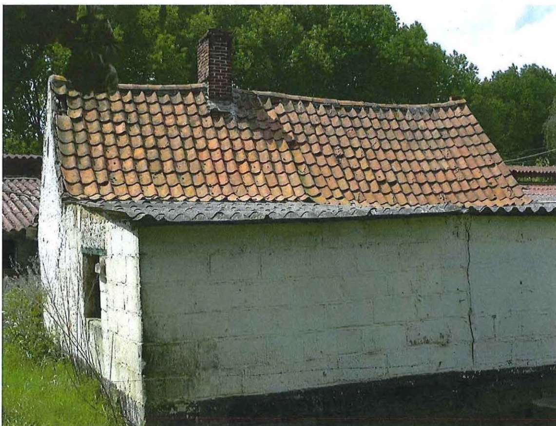
Foto 37: Bakhuis – pannen zadeldak met schouw ter hoogte van de schoorsteen – volume ingebouwd door jongere stallen.
