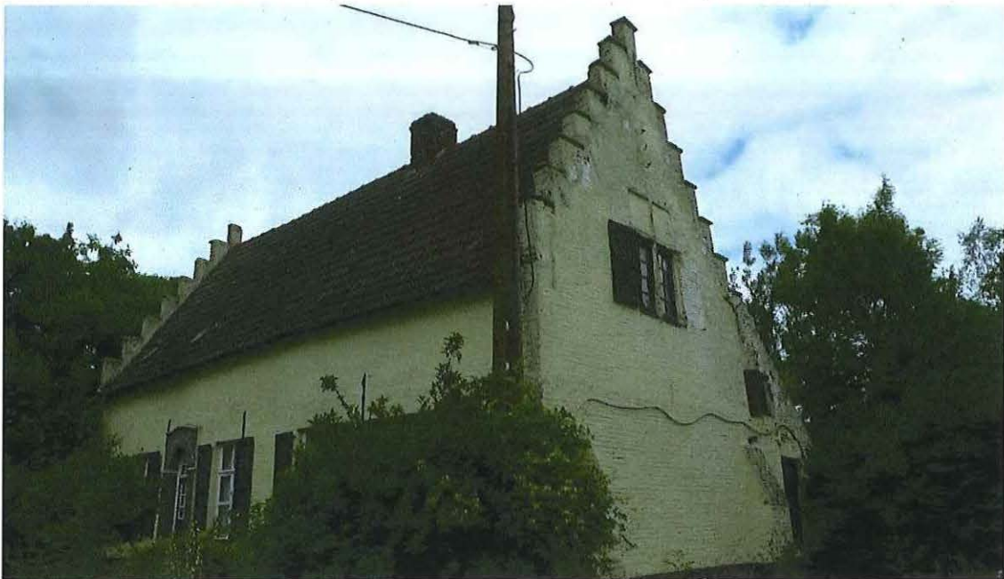
Foto 17: Boerenhuis, erfgevel en oostelijke zijtrapgevel – toestand 18 juni 2015 met minder begroeiing.
