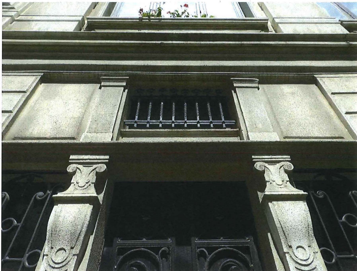
Foto 40: Achtergevel – detail deurtravee.
