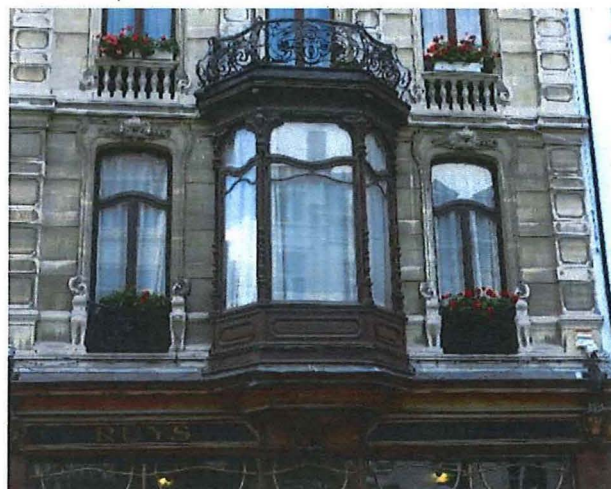
Foto 23: Eerste verdieping – erker met flankerende venster.
