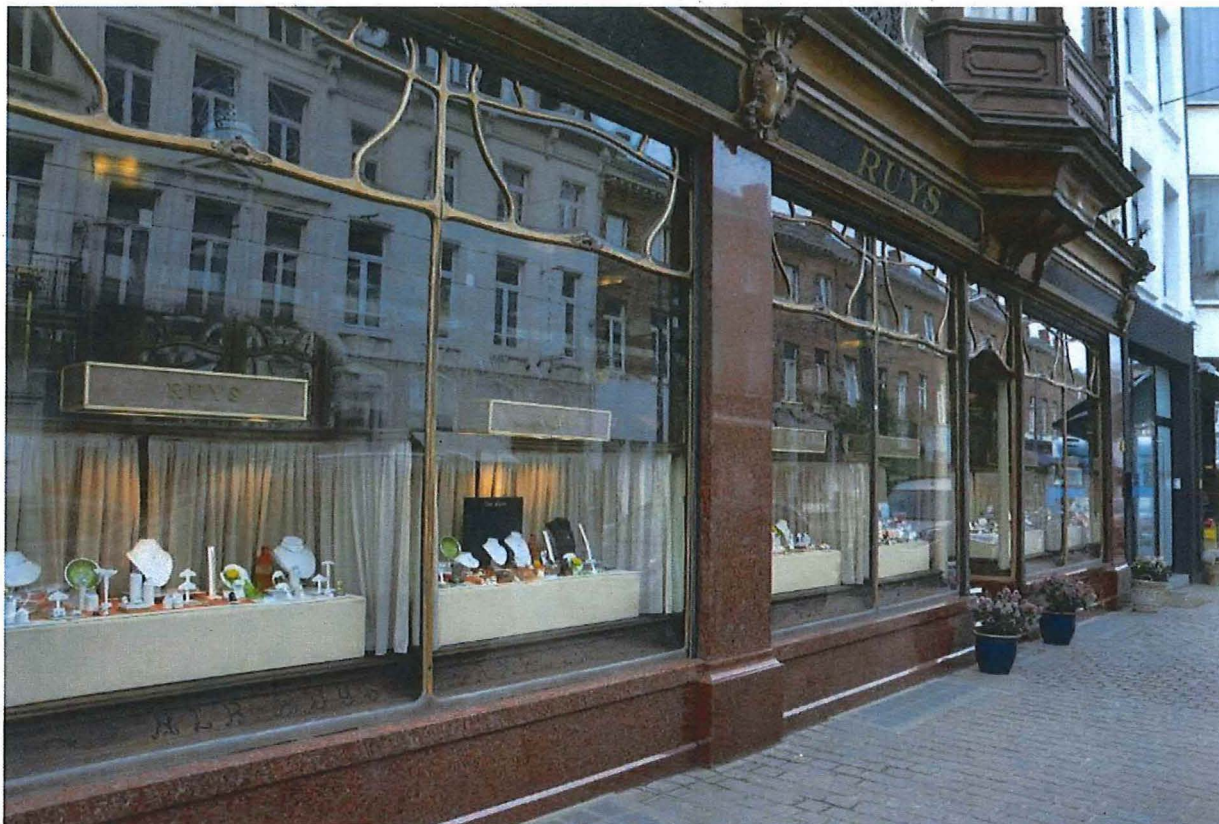
Foto 7: Voorgevel - begane grond – winkelpui.
