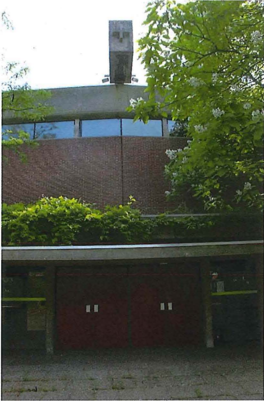
Foto 11: Westgevel met trompetboom.
