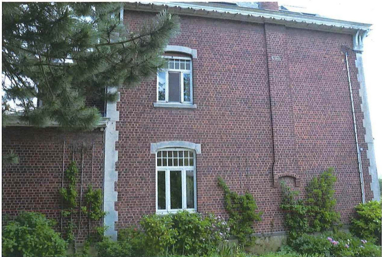
Foto 10: Serristenvilla Muyldermans, westgevel (25/05/2018).
