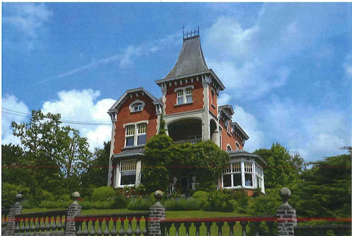
Foto 4: Serristenvilla Muyldermans, zuidgevel (25/05/2018).
