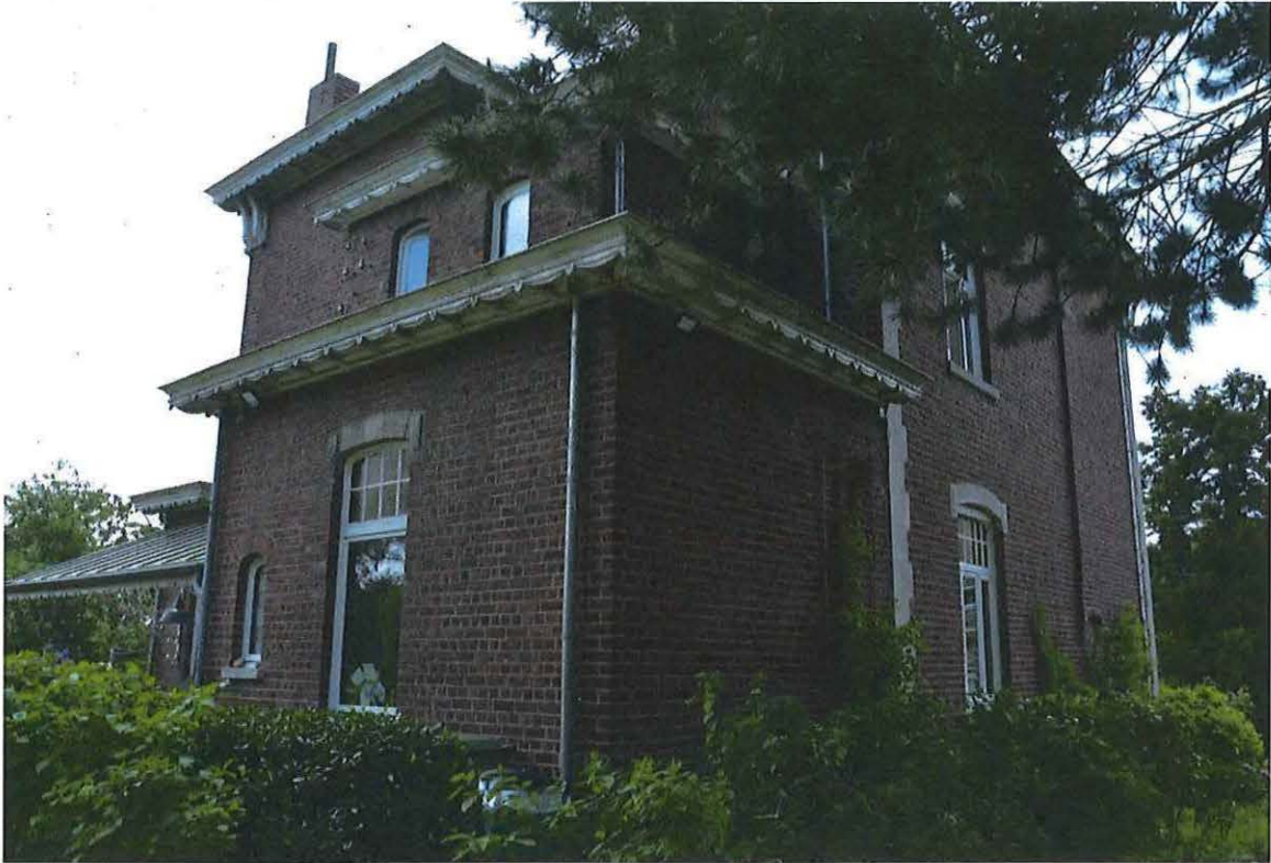
Foto 9: Serristenvilla Muyldermans, vanaf het noordwesten (25/05/2018).
