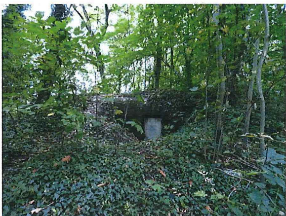
Foto 11: Zicht op de (noordwestelijke) achterzijde van de geschutsbunker. Foto genomen op 11 oktober 2017.
