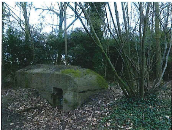
Foto 7: Zicht op de noordwestelijke achterzijde van de observatiepost. Foto genomen op 22 maart 2017.
