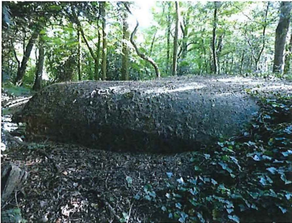
Foto 3: De zuidwestelijke voorzijde van de bunker. De gaten voor de zware bouten ter bevestiging van de pantserplaat aan de binnenzijde zijn zichtbaar. Bovenaan zijn camouflagespatten aangebracht. Foto genomen op 14 juni 2017.
