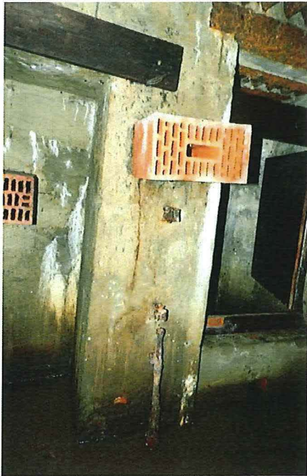
Foto 24: Restanten van ijzeren elementen voor de bevestiging van bedrading in de bunker. Foto genomen op 14 juni 2017.
