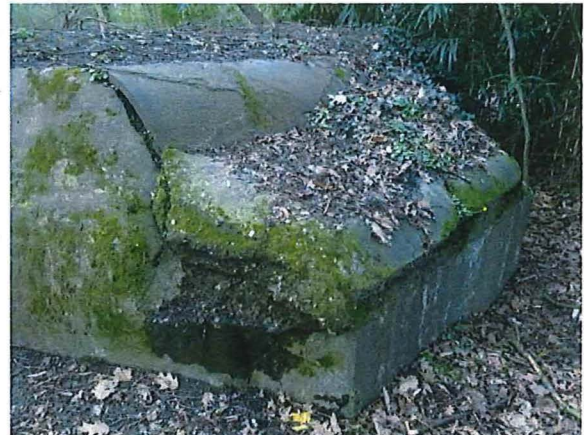
Foto 6: De pantserplaat aan de (zuidoostelijke) voorzijde van de bunker. Foto genomen op 22 maart 2017.
