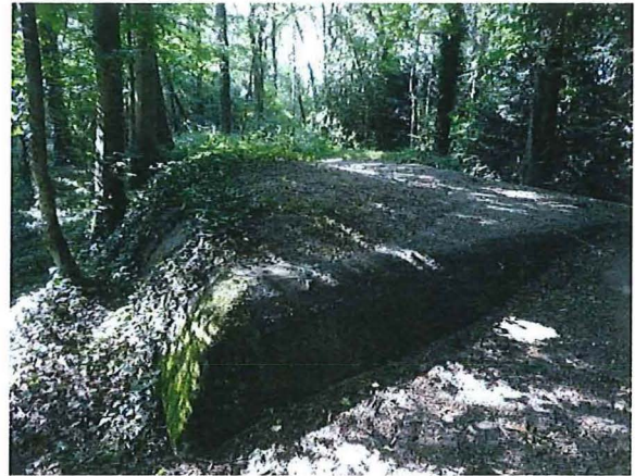
Foto 2: De westelijke geschutsbunker vanuit noordoostelijke hoek. Foto genomen op 14 juni 2017.
