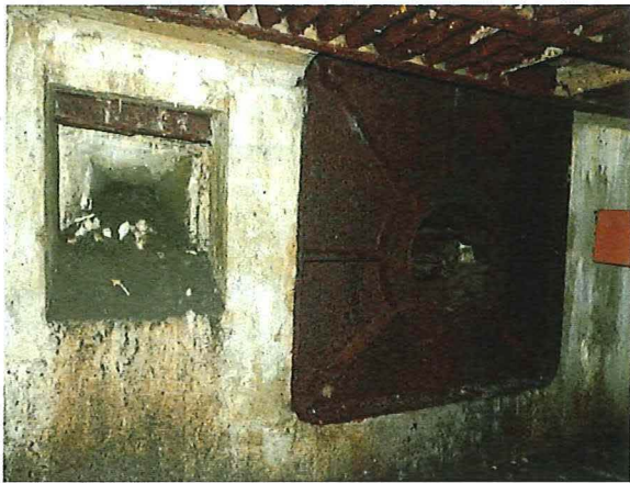
Foto 13: Zicht op de observatieopening en de plataffuit voor het kanon aan de noordoostelijke voorzijde van de bunker. Foto genomen op 14 juni 2017.
