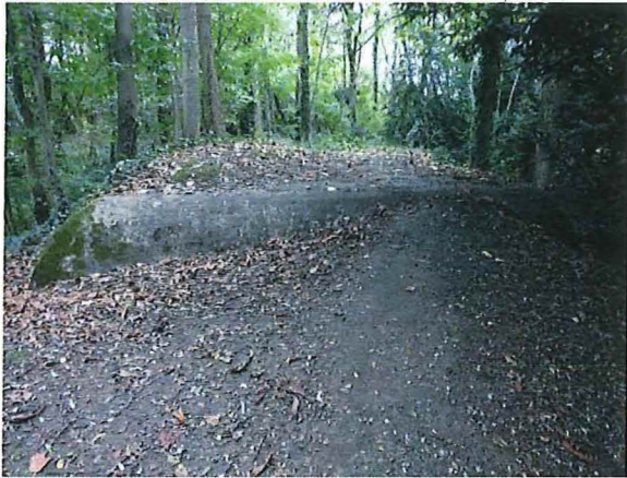
Foto 1: De westelijke geschutsbunker, waarover een pad loopt. Foto genomen op 11 oktober 2017.
