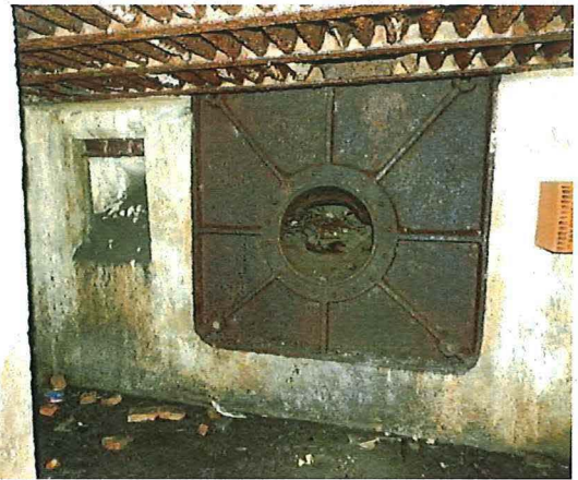
Foto 14: Zicht op de observatieopening en de plataffuit voor het kanon aan de noordoostelijke voorzijde van de bunker. Foto genomen op 14 juni 2017.
