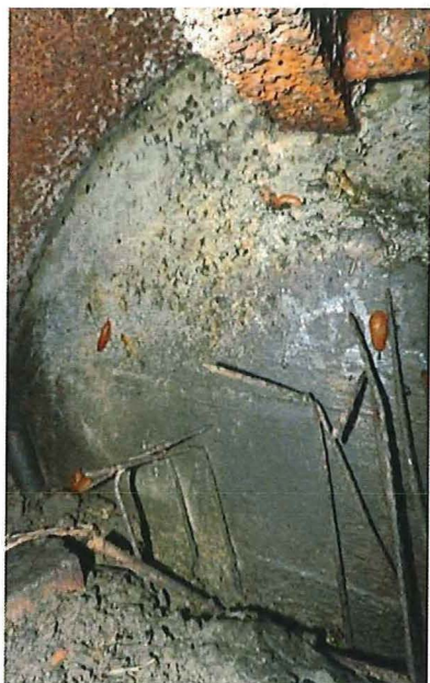
Foto 18: Elementen van de pantserkoepel aan binnenzijde. Foto genomen op 14 juni 2017.
