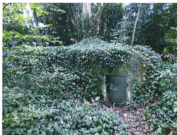
Foto 21: Zicht op de noordwestelijke achterzijde van het manschappenonderkomen. Foto genomen op 11 oktober 2017.
