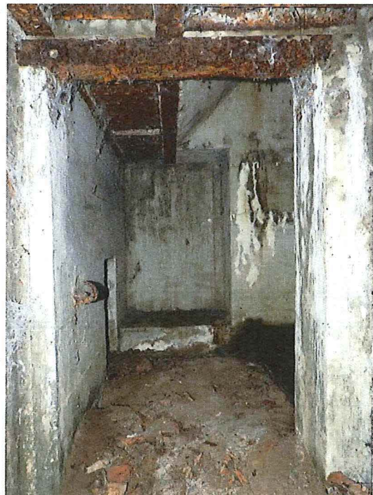
Foto 3: Zicht in de bunker vanuit de toegang. Foto genomen op 13 oktober 2017.
