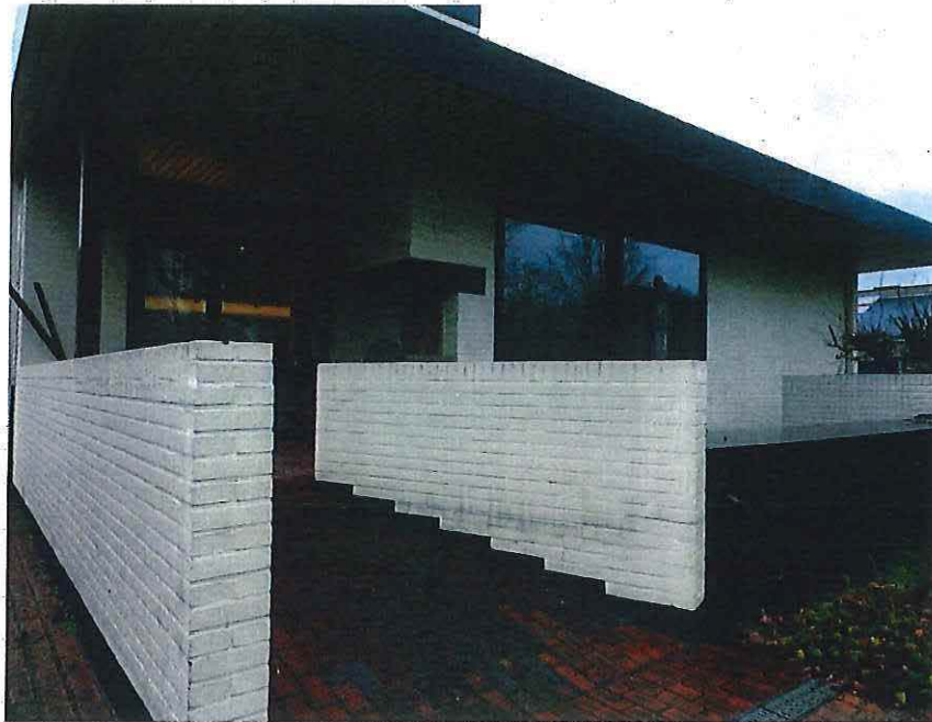
Foto 11: Westgevel, detail avondterras (21 december 2018).
