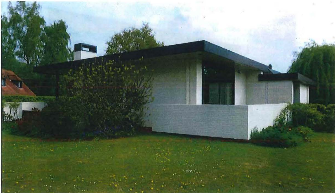
Foto 6: West- en zuidgevel (24 april 2017).
