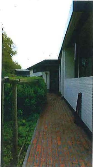
Foto 16: Noordgevel, pad tot de achterdeur (24 april 2017).
