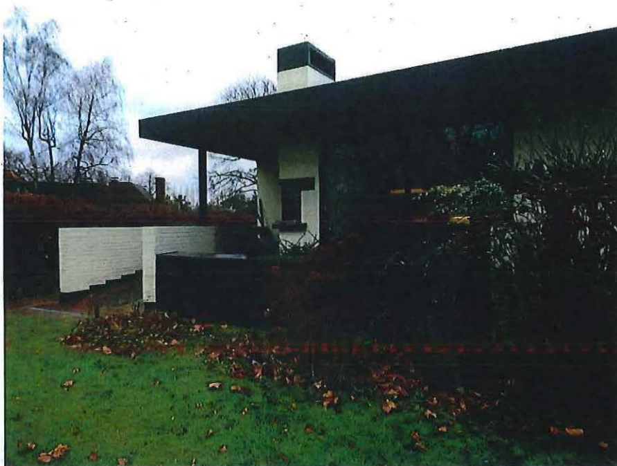
Foto 10: Westgevel, detail avondterras (21 december 2018).
