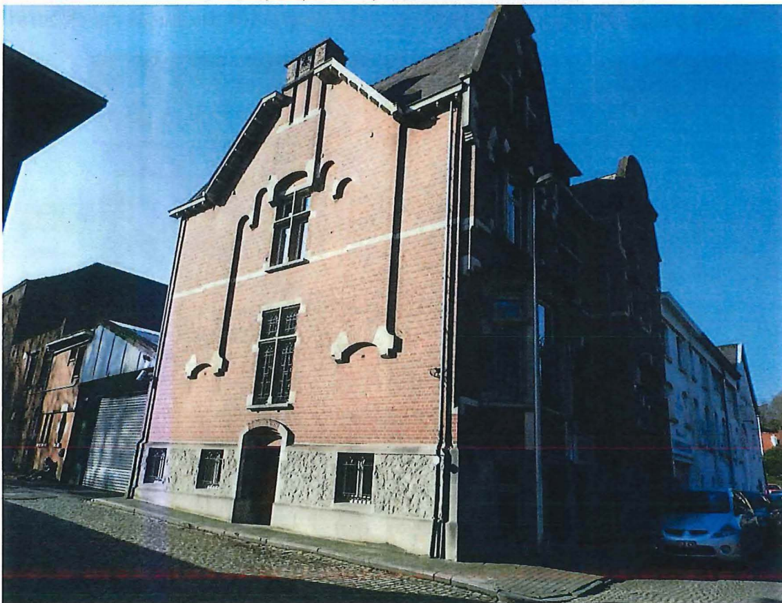
Foto 4: Brouwerswoning, oostgevel langs de buurtweg (05/02/2018).
