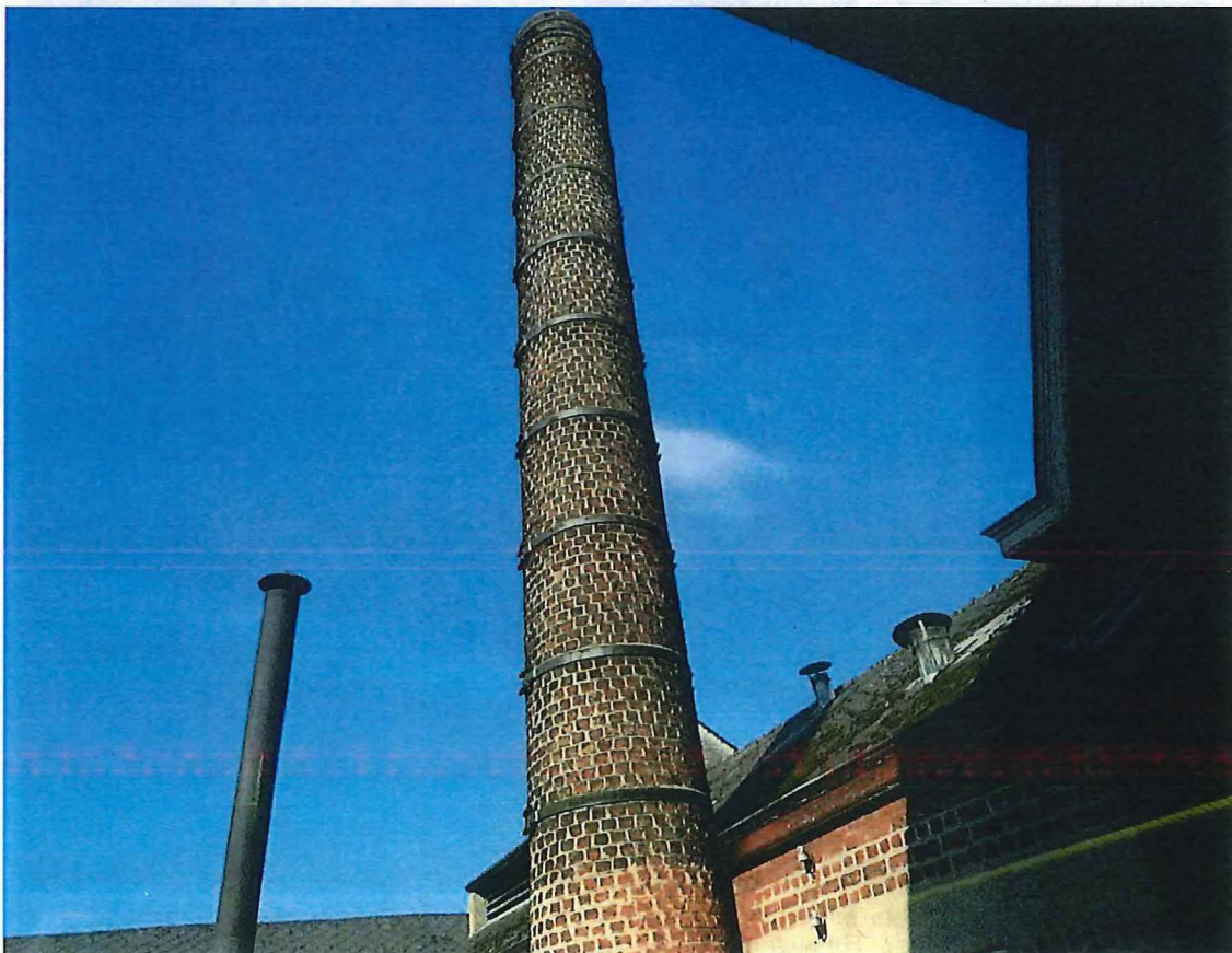
Foto 14: Schoorsteen tegen de achtergevel van de brouwerij (05/02/2018).
