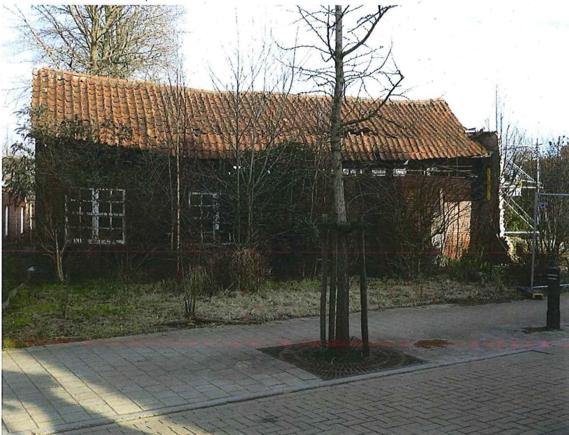
Foto 2: Blokstal met voorliggende zone voor stockage van hout.
