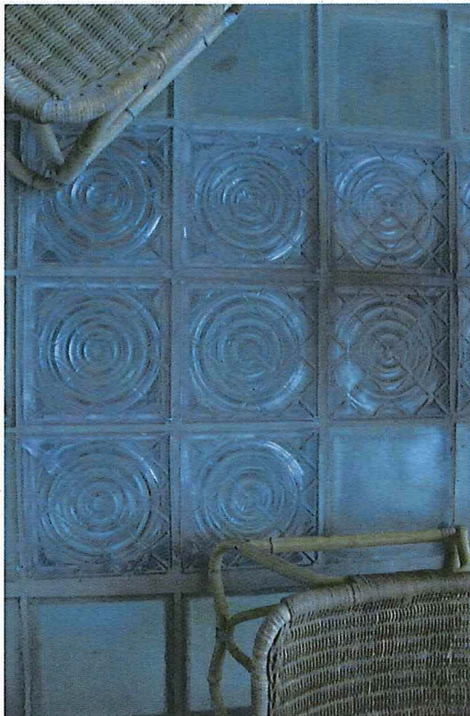
Foto 22: Detail, vloer van het terras met flessenbodem-glasdalen in een metalen roostering.
