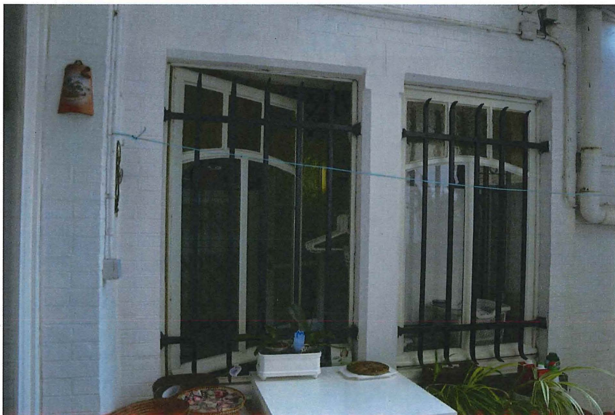
Foto 19: Vensters van de wasplaats, gezien vanuit de koer van het souterrain. Bewaard schrijnwerk met gebogen drieledige bovenlichten met okerkleurig gehamerd glas.
