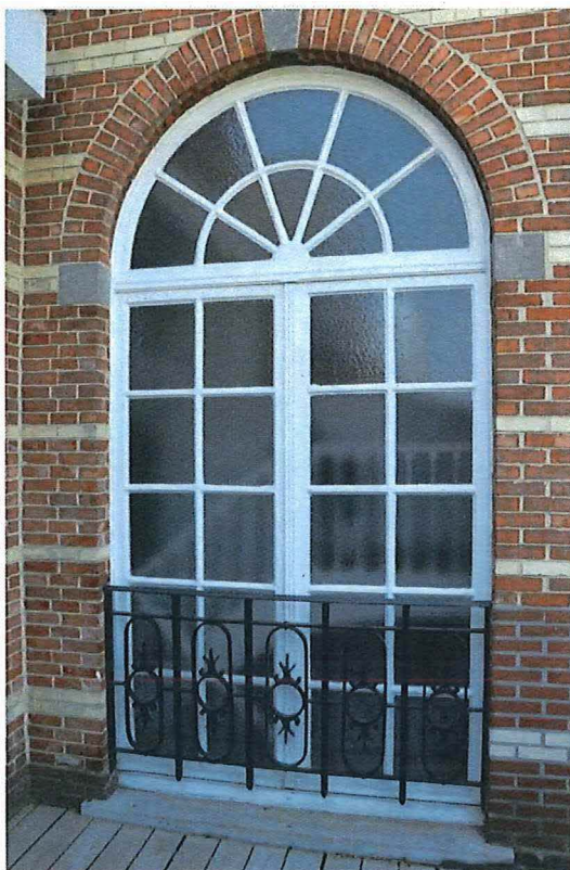
Foto 24: Groot venster dat de hoofdtraphal verlicht, gezien vanaf het balkon op de verdieping, met bewaard schrijnwerk.
