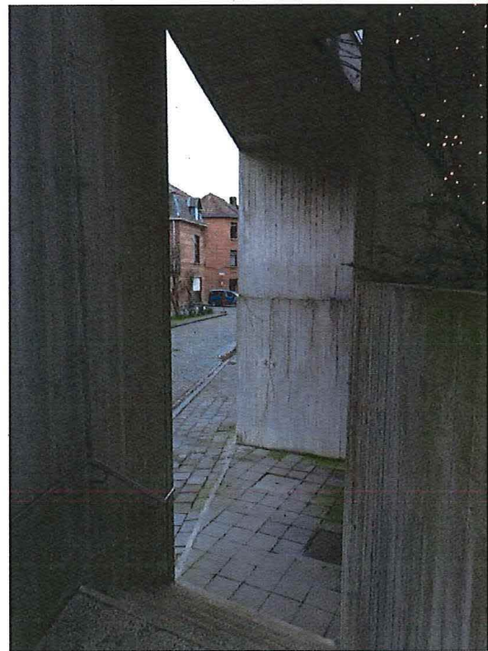
Foto 7: oostgevel, zicht vanaf 1ste bordes naar portiek aan de straat
