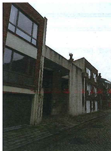
Foto 5: oostgevel vanuit zuiden
