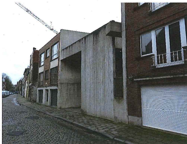
Foto 3: oostgevel vanuit noordzijde
