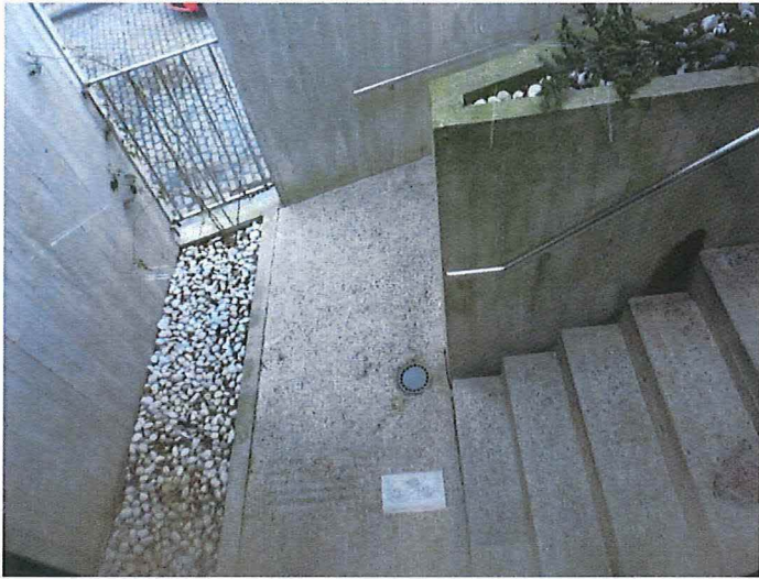
Foto 9: oostgevel, detail trap en bordes met plantenbakken
