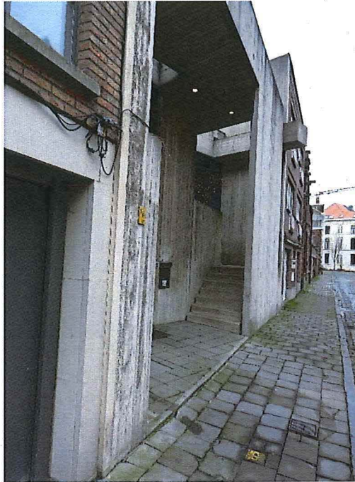
Foto 6: oostgevel vanuit zuiden, ingangspartij met portiek
