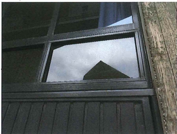
Foto 15: oostgevel, detail van raamwerk en garagepoort
