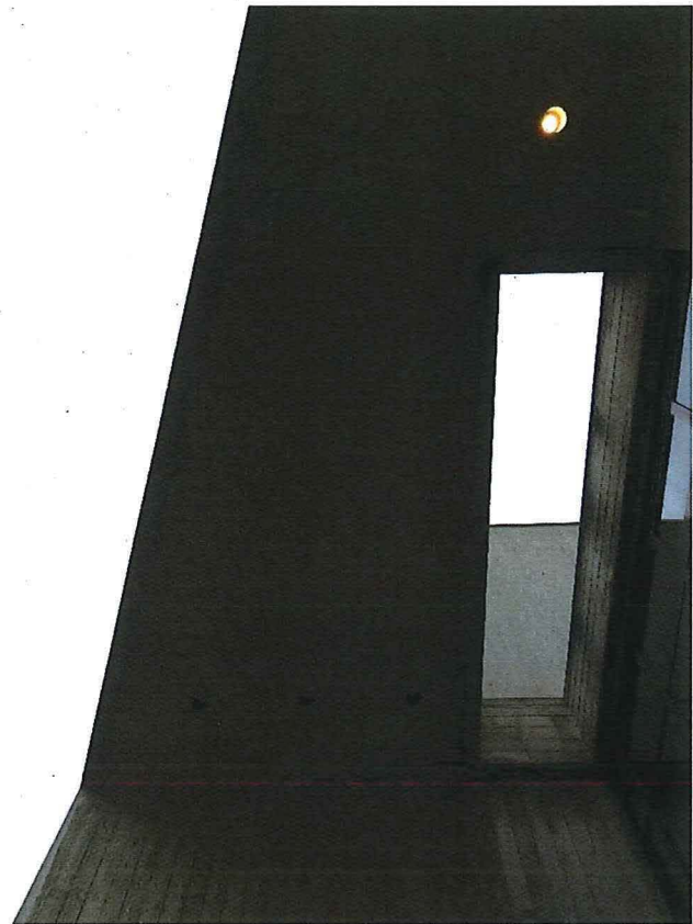
Foto 12: oostgevel, portiek en dakdoorbreking ter hoogte raam praktijkruimte 2
