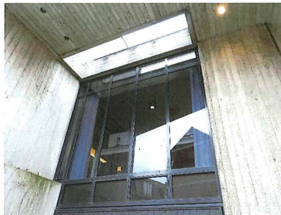
Foto 16: oostgevel, praktijkruimte 2, vensterzone en dakdoorbreking
