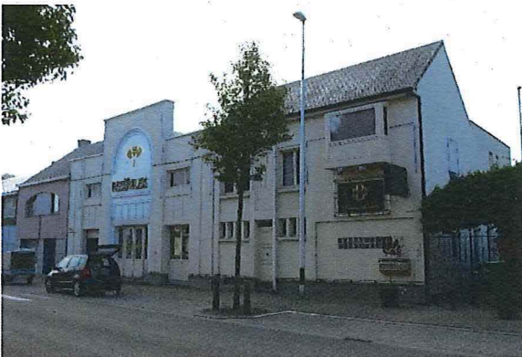
Foto 2: Feestpaleis, voorgevel, 5 november 2018
