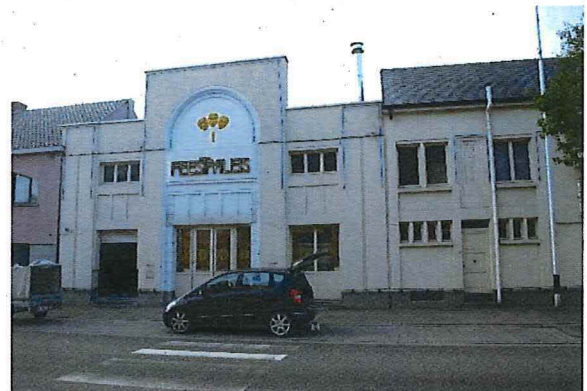
Foto 3: Feestpaleis, voorgevel, 5 november 2018
