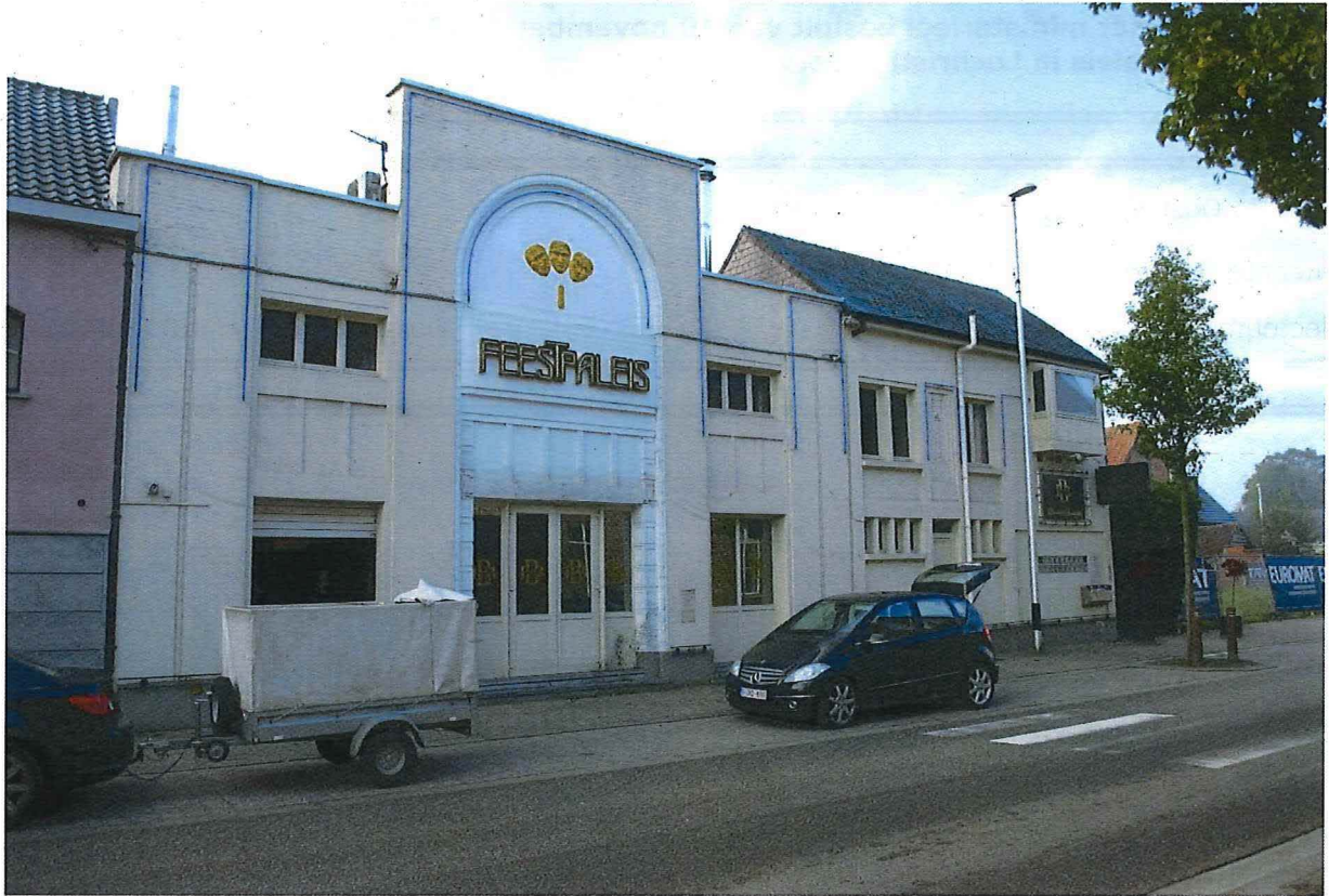
Foto 1: Feestpaleis, voorgevel, 5 november 2018
