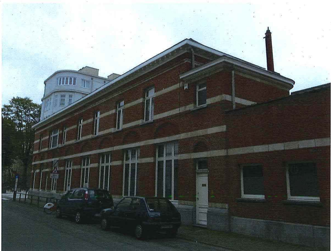
Foto 8: Het kantoorgebouw dat snel na de bouw verlengd werd.
