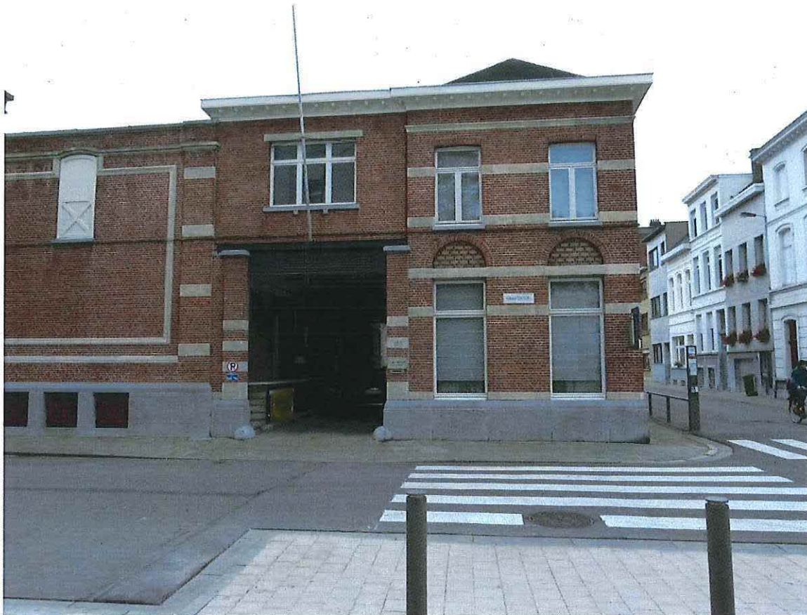
Foto 3: Gevel van het bureaugebouw en de overdekte doorgang naar de binnenplaats.
