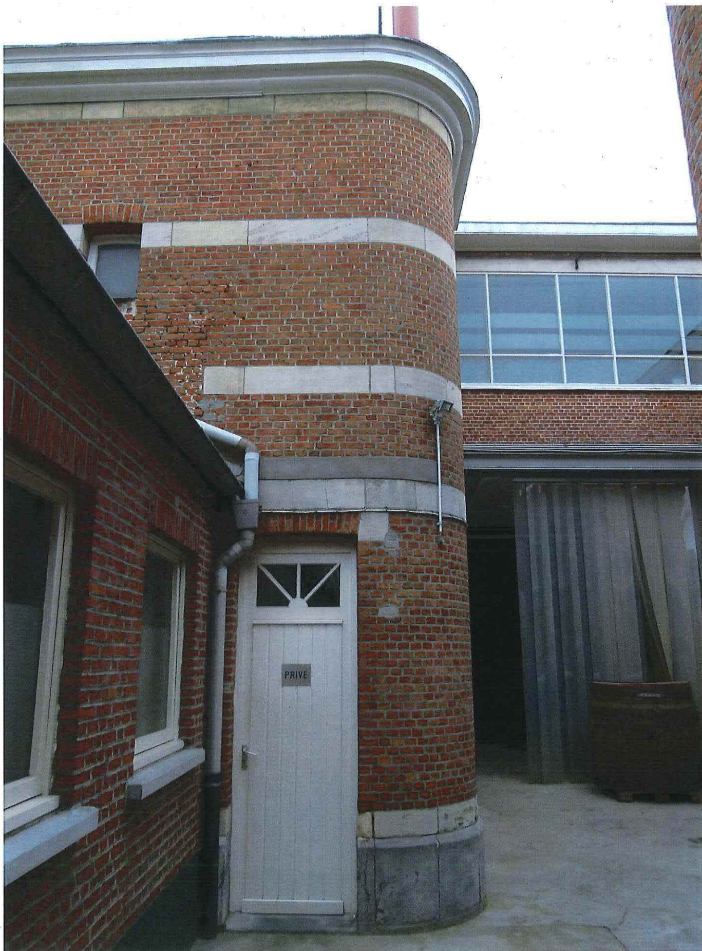
Foto 13: De binnenplaats met gezicht op de overdekte doorrit en links ervan het kantoorgebouw.
