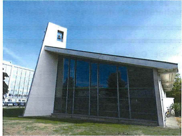
Foto 2: Vliesgevel in het zuidwesten
