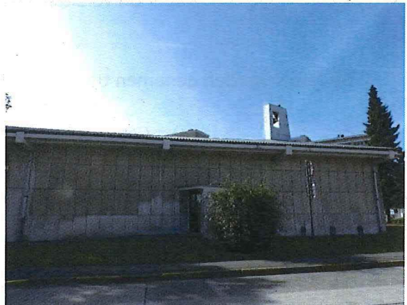
Foto 4: Noordgevel in witte portlandsteen
