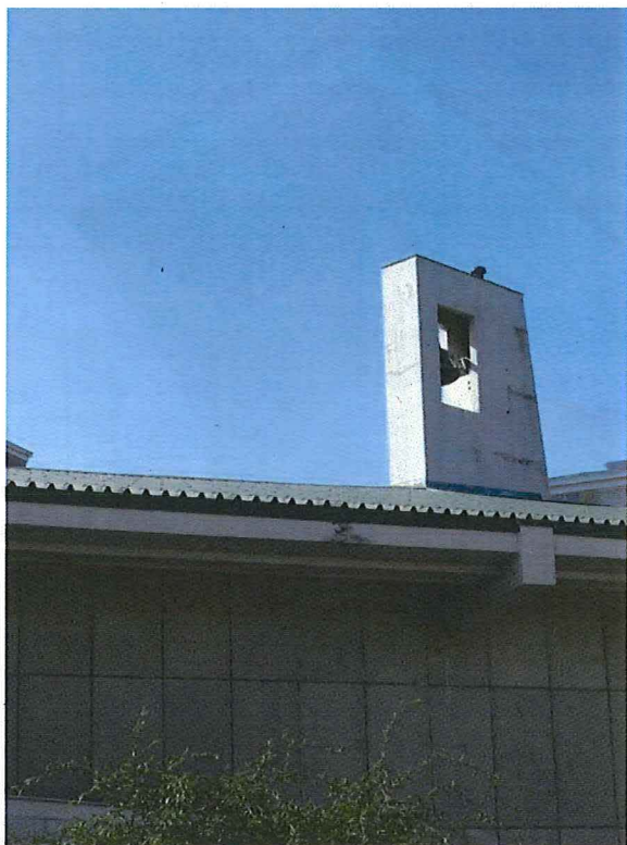
Foto 11: Detail dak en klokkenstoel
