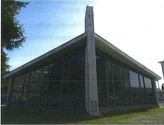
Foto 1: Noordwestelijke en zuidwestelijke vliesgevels
