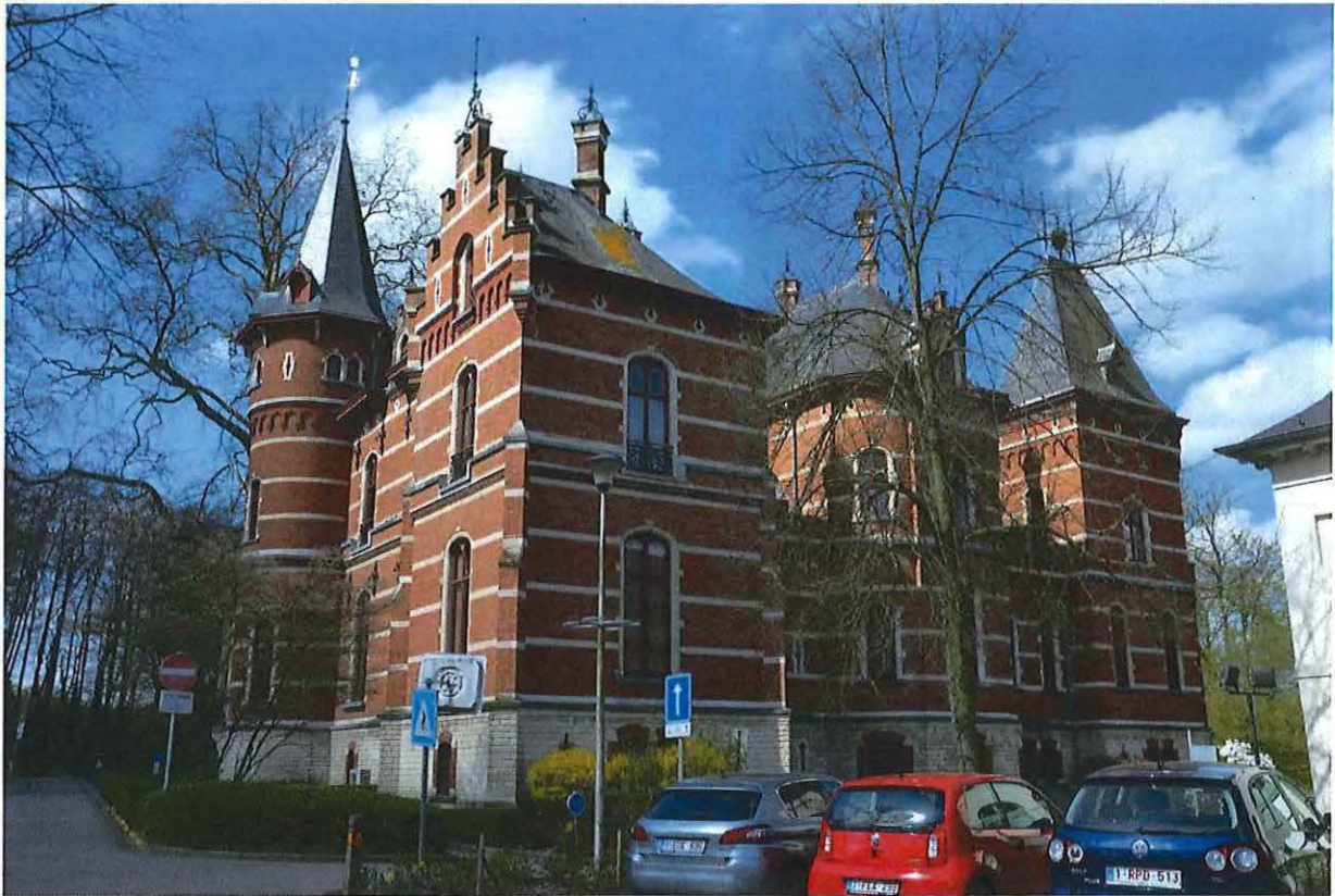
Foto 7: Achtergevel, algemeen beeld (10/04/2018).
