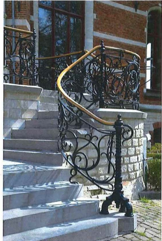
Foto 13: Voorgevel, buitentrap met smeedijzeren balustrade (10/04/2018).
