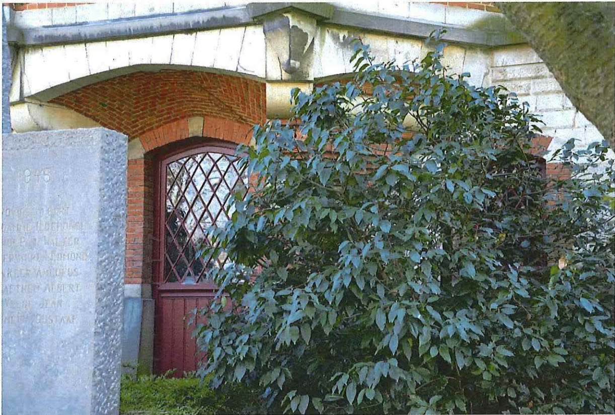
Foto 21: Noordelijke zijgevel, dienstingang onder de erkeruitbouw van de eetkamer (10/04/2018).
