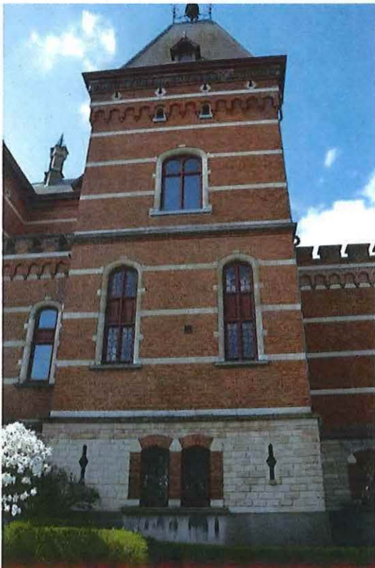
Foto 19: Achtergevel, noordoostelijke hoektoren (10/04/2018).
