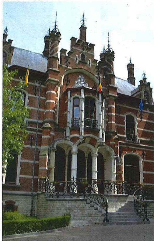
Foto 15: Voorgevel, middenrisaliet met buitentrapp (25/05/2018).
