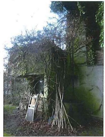
Foto 44: Uitbouw garage, terras en waterput (06/03/2018).
