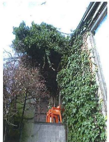
Foto 47: Zicht naar het bovenliggend terras (06/03/2018).
