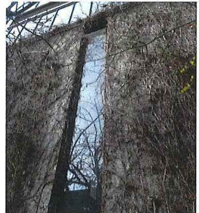
Foto 34: Oostgevel, gevelhoog venster (06/03/2018).
