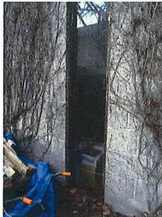
Foto 33: Oostgevel, gevelhoog venster (06/03/2018).
