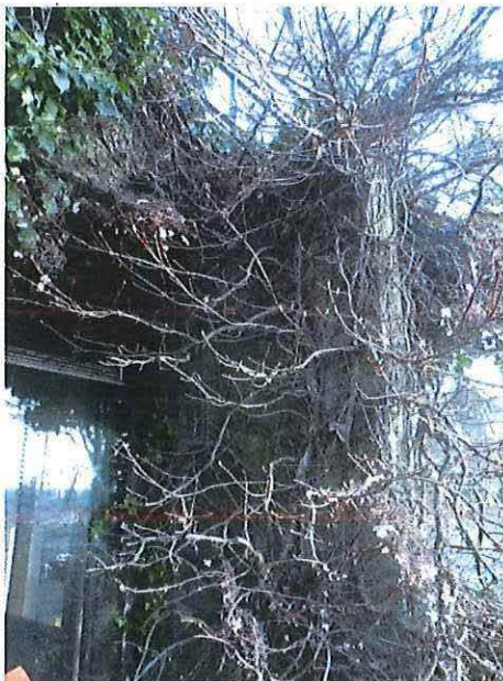
Foto 61: Terras, betonstenen muurtje tot dak (06/03/2018).
