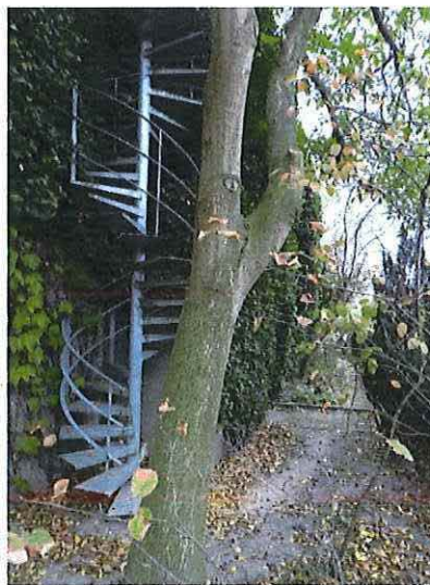
Foto 21: Westgevel, zicht naar zuiden (24/10/2018).
