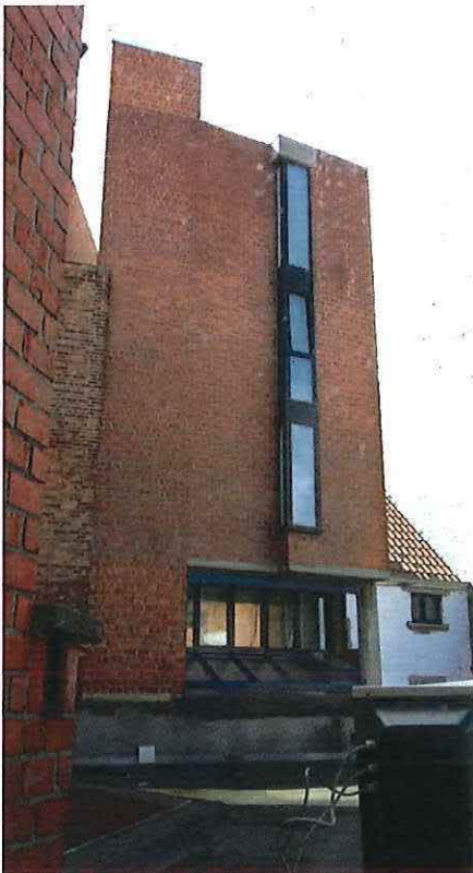
Foto 6: Woning De Zordo – achtergevel, 10 augustus 2018
