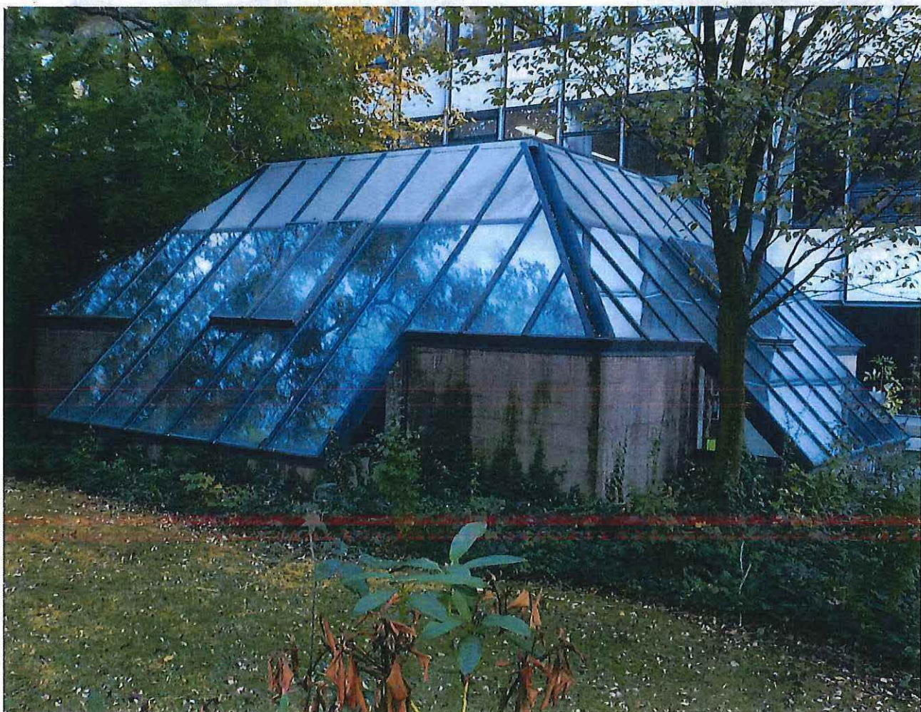
Foto 12 : blok G (noordwestgevel, leraarskamer), Henleykaai 83-84 (6 november 2018).
