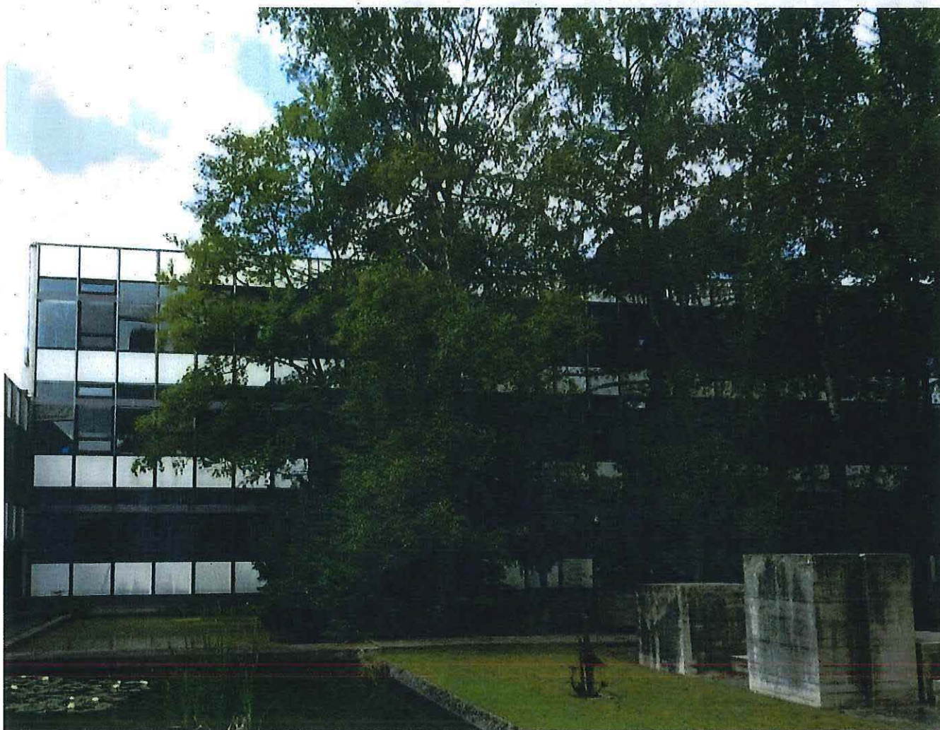
Foto 25 : blok E (zuidoostgevel), Abdisstraat 56 (13 juni 2018).
