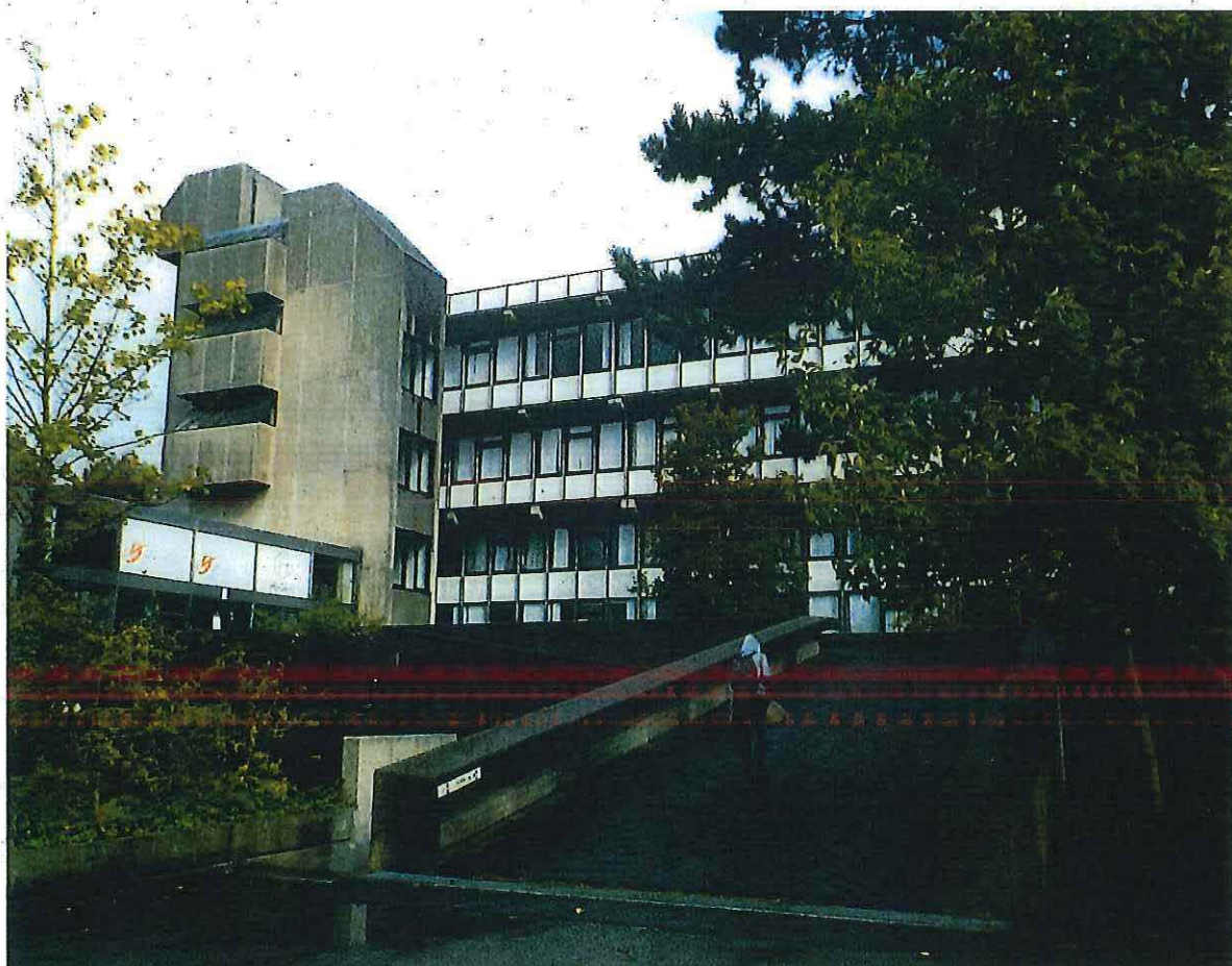
Foto 2 : blok G (zuidwestgevel), Henleykaai 83-84 (5 december 2017).
