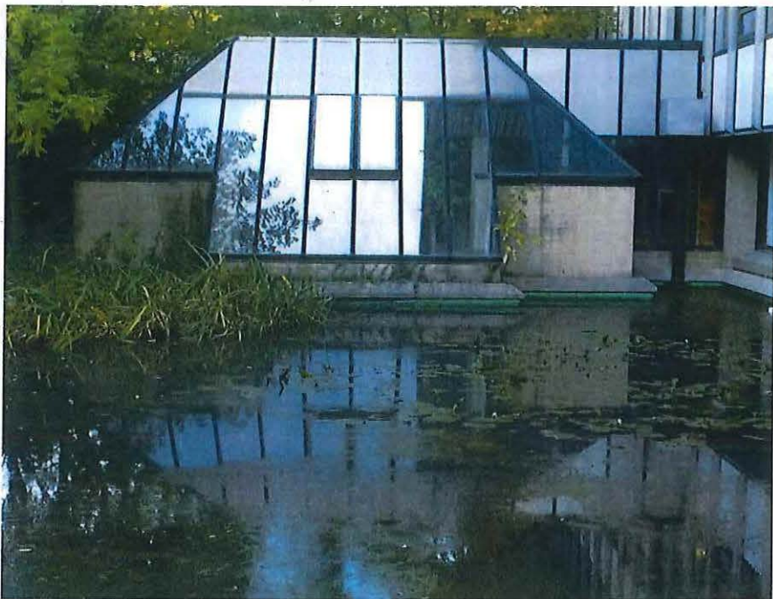
Foto 13 : blok G (noordwestgevel, leraarskamer), Henleykaai 83-84 (6 november 2018).
