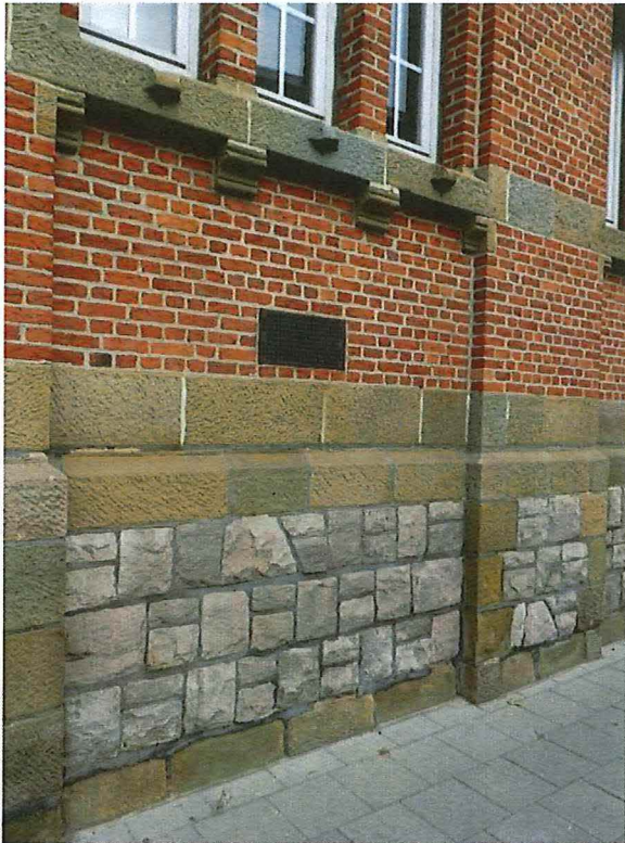
Foto 6: Voorgevel, detail materiaalgebruik.
