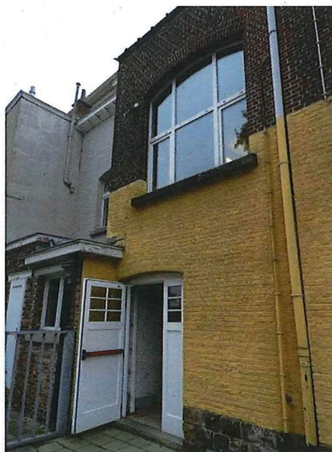
Foto 28: Achterzijde van de voormalige conciërgewoning.
