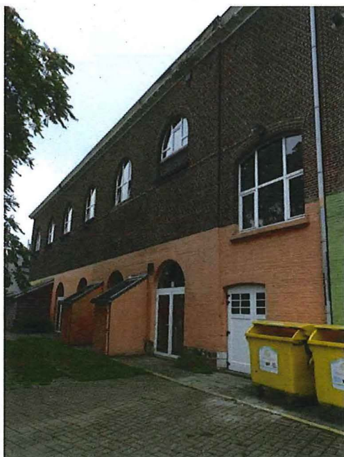
Foto 27: Achtergevel, de zeven noordwestelijke traveeën.
