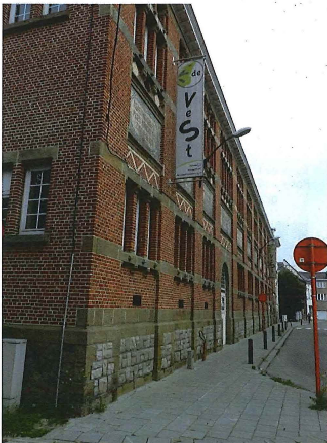
Foto 4: Voorgevel aan de Vestenstraat, hoek met Achterham.
