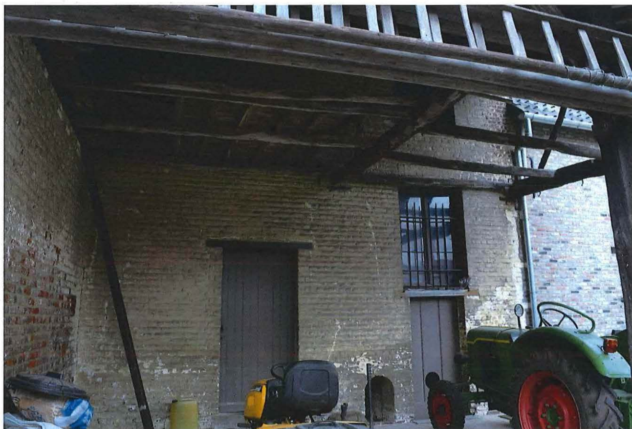
Foto 16: open schuur (of wagenhuis) onder aandaak en met houten beschot, gebouwd tegen de achtergevel van de rechter of oostelijke aanhorigheid (datum 9 april 2018)
