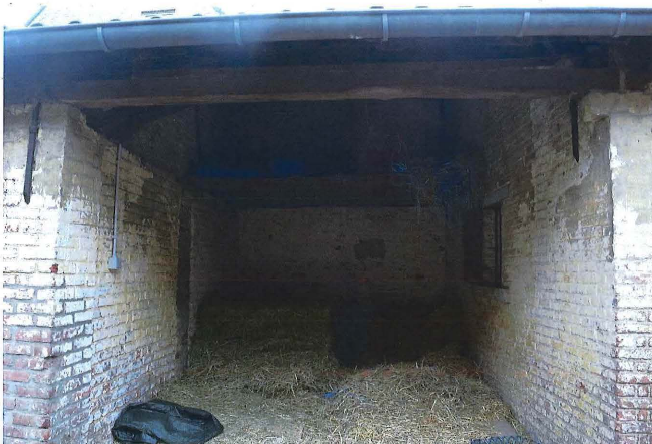
Foto 18: jongere open stal met balkenzoldering horend bij de rechter aanhorigheid, gebouwd tegen de oude ommuring van de vroegere moestuin (datum 9 april 2018)
