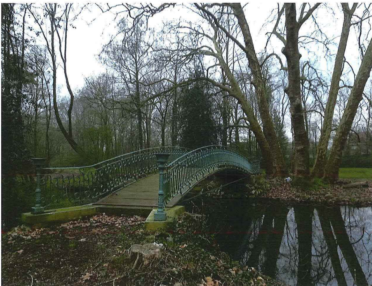
Foto 24: zicht op de recent gerestaureerde tuinbrug (datum 9 april 2018)
