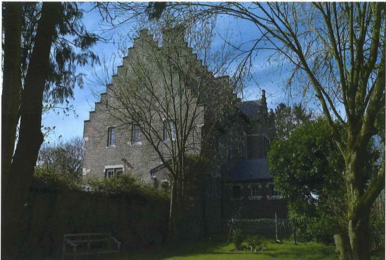
Foto 7: zijtrapgevel van de oostelijke of rechtersvleugel (datum 27 maart 2017)
