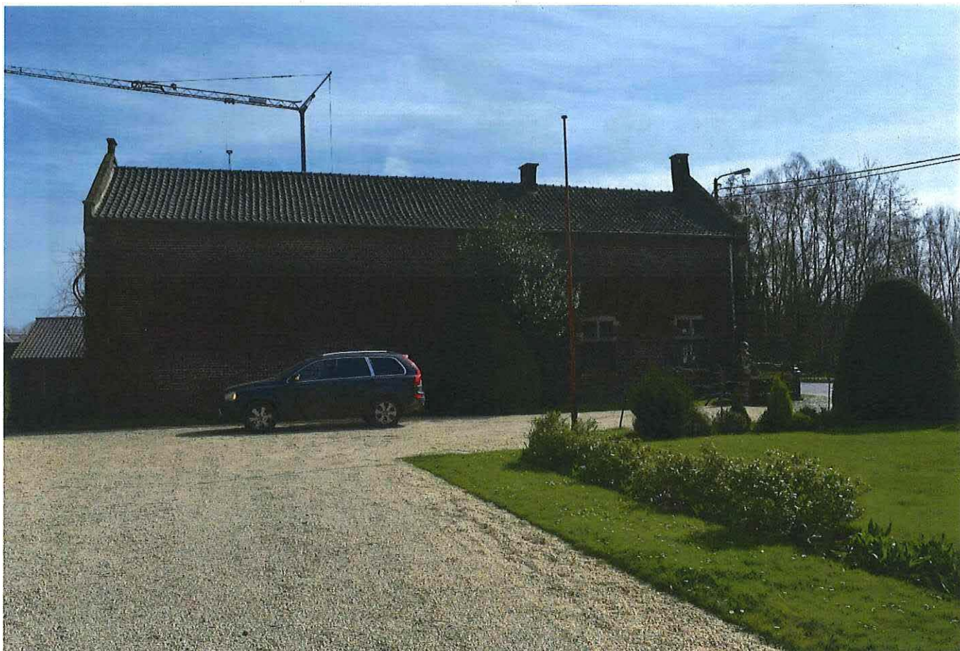
Foto 13: de rechter of oostelijke aanhorigheid met grotendeels blinde voorgevel gericht naar het erreplein (datum 9 april 2018)
