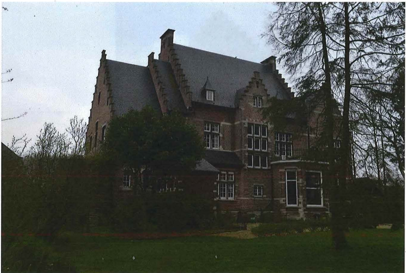
Foto 8: zicht op noordelijke achtergevel van het landhuis, met centraal hogeropgaand middendeel en twee flankerende lagere volumes onder verspringende zadeldaken (datum 9 april 2018)
