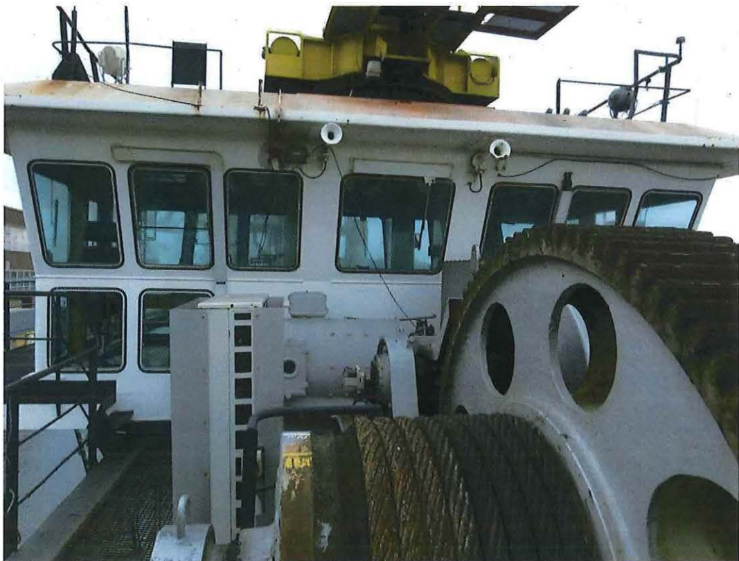
Foto 8: Ladderier en bedieningshuis.
