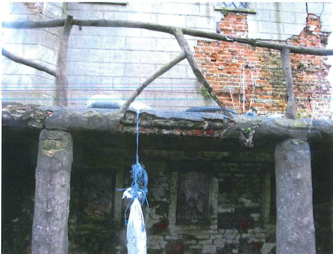
Foto 19: Corrosie van de wapening van het betonnen platform (© Triconsult 07/02/2017).
