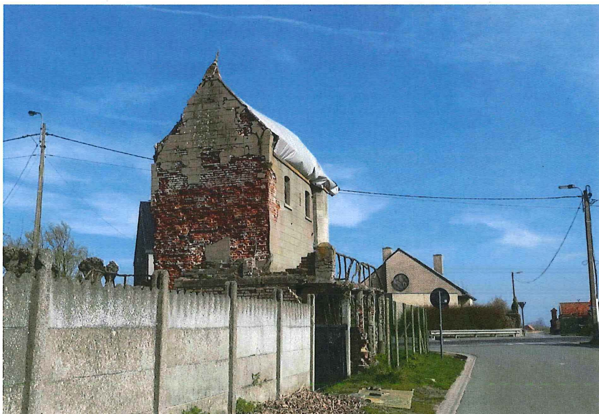
Foto 3: Achtergevel (© Bressers Architecten 22/11/2017).
