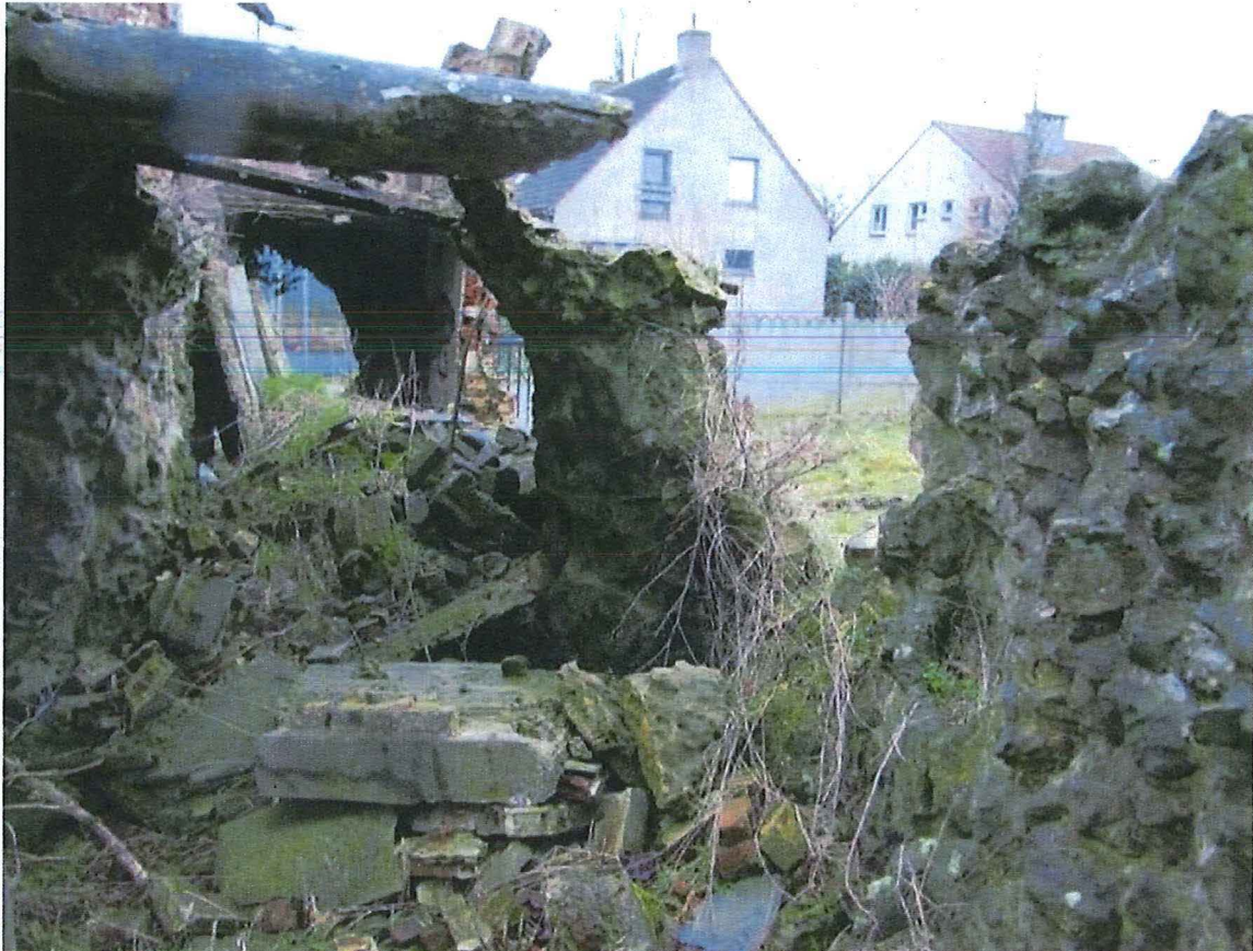
Foto 35: Grotendeels ingestort deel van de omgang aan de achterzijde (© Triconsult 07/02/2017).
