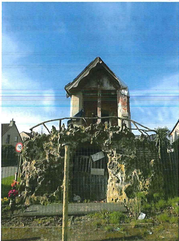
Foto 1: Voorgevel grafkapel De Kalvaer (© Bressers Architecten 22/11/2017).
