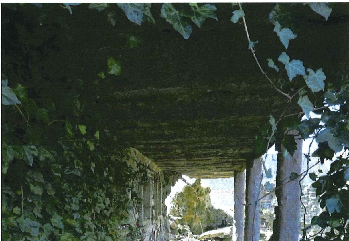
Foto 22: Omgang (© Bressers Architecten 07/02/2017)
