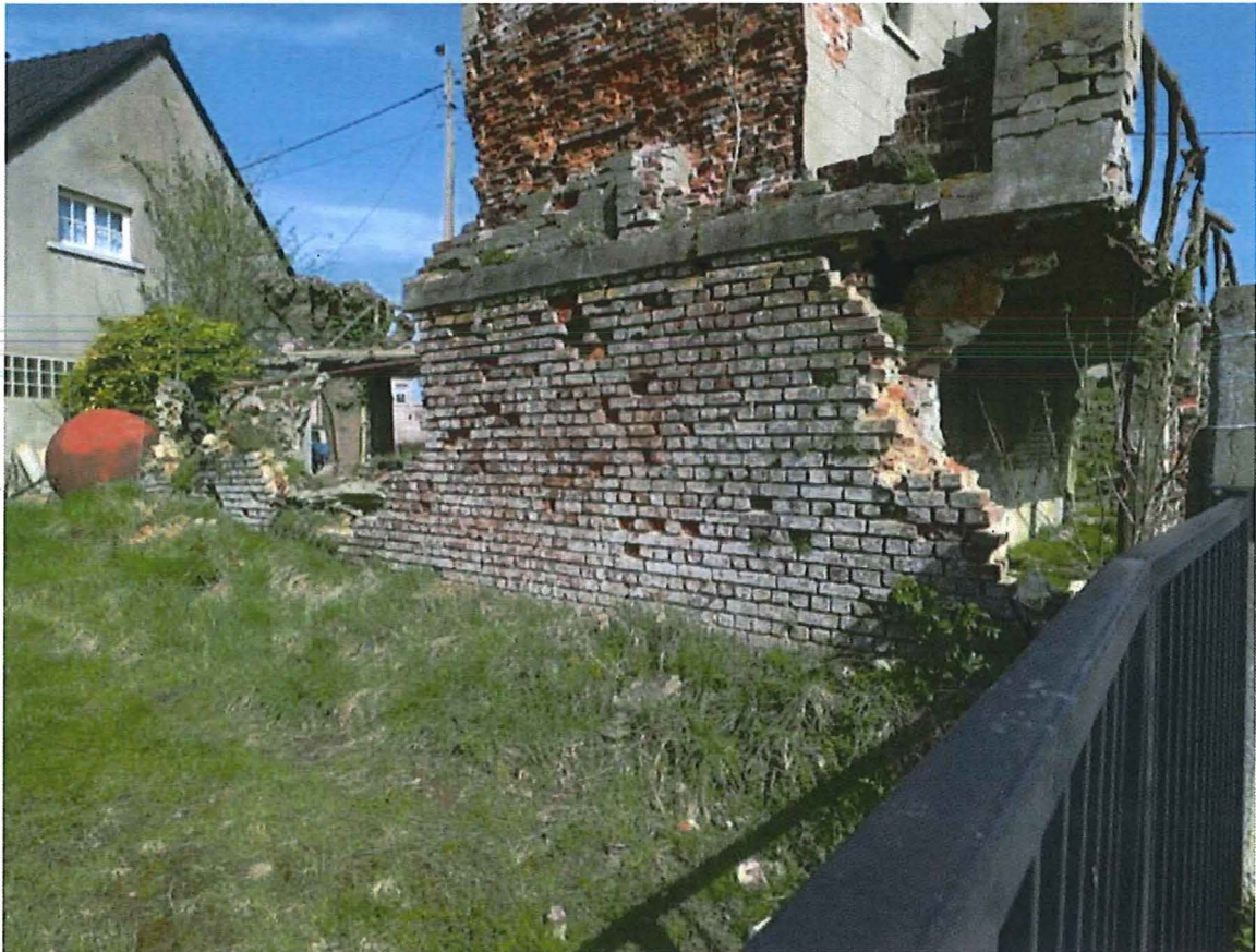
Foto 9: Zicht op deels ingestorte muur achtergevel ter hoogte van de onderbouw (© Bressers Architecten 22/11/2017).
