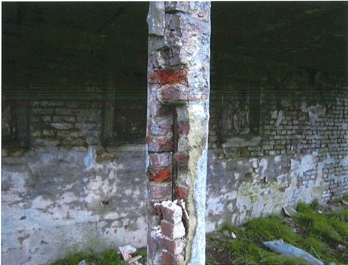
Foto 17: Detail kolommen, loszittend metselwerk en corrosie van de wapening (© Triconsult 07/02/2017).
