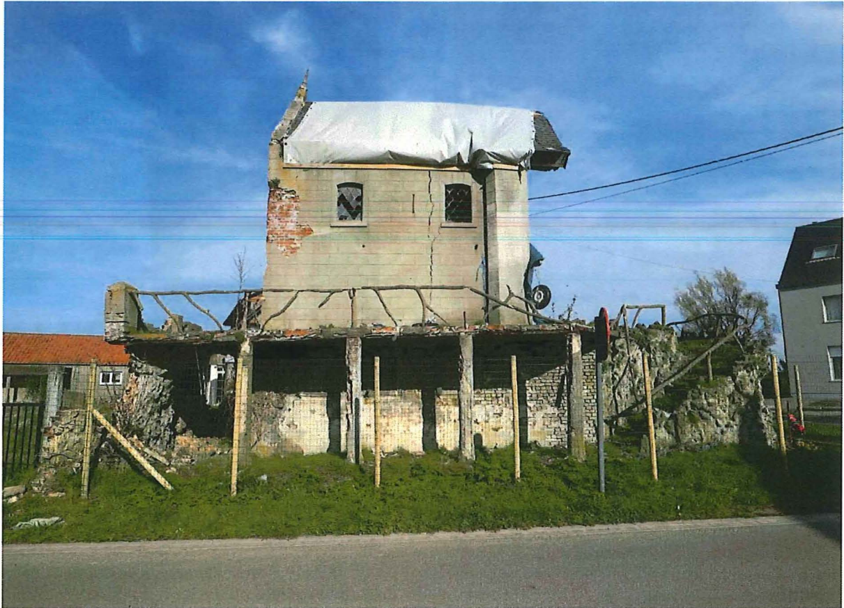
Foto 4: Zuidoostelijke zijgevel (© Bressers Architecten 22/11/2017).
