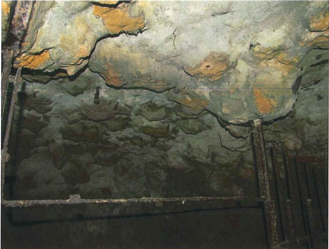
Foto 39: Detail van het rotseerwerk in de kapel Onze-Lieve-Vrouw van Zeven Weeën (© Triconsult 07/02/2017).
