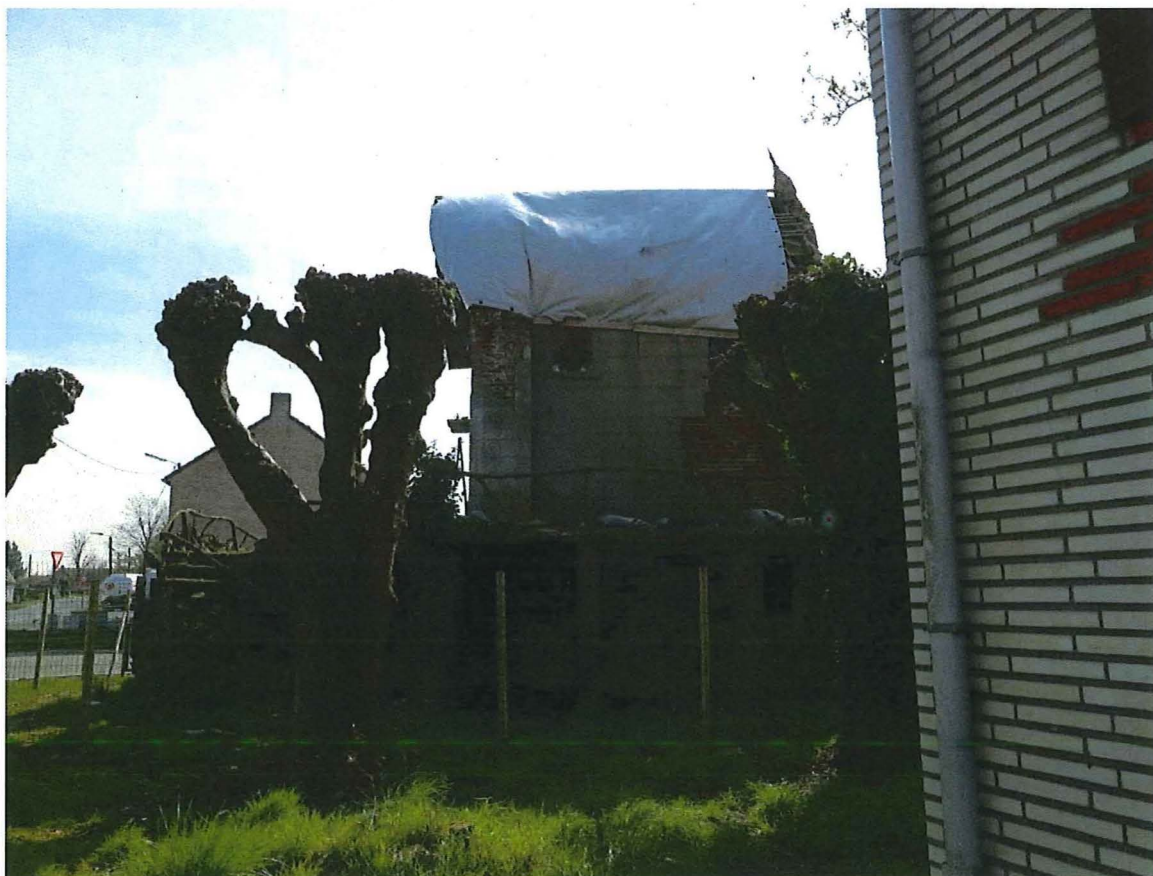
Foto 5: Noordwestelijke zijgevel (© Bressers Architecten 22/11/2017).
