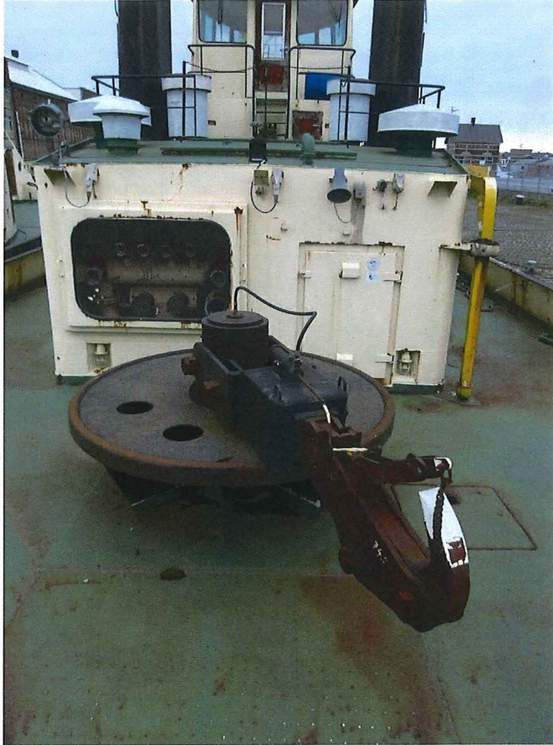
Foto 10: De sleephaak op het achterdek met, achter het glas, de brandblusinstallatie.
