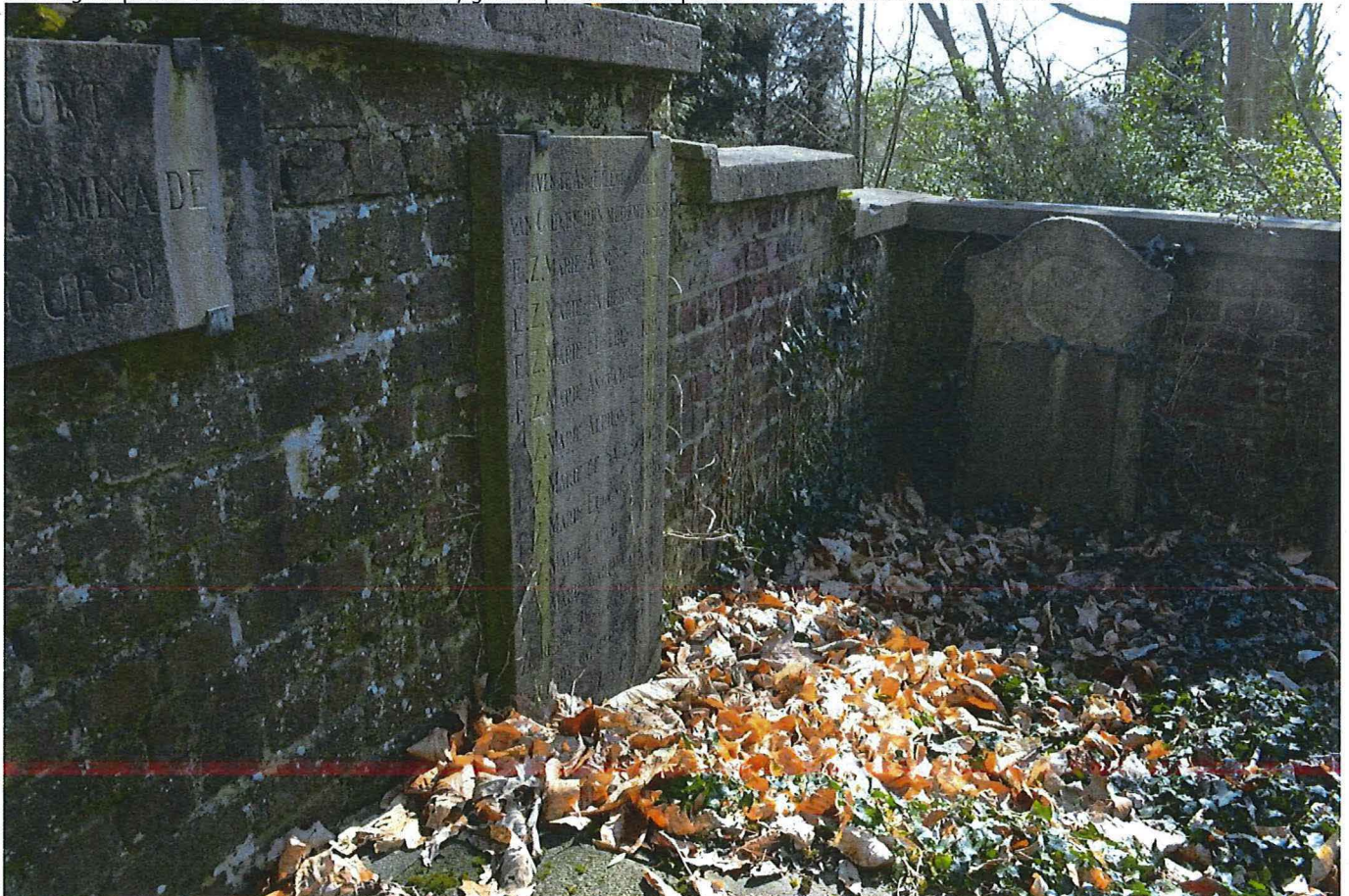
12. Begraafplaats van het Don Boscoklooster, gedenkplaat voor de Soeurs de Charité de Notre Dame du Bon et Perpétuel Secours.
