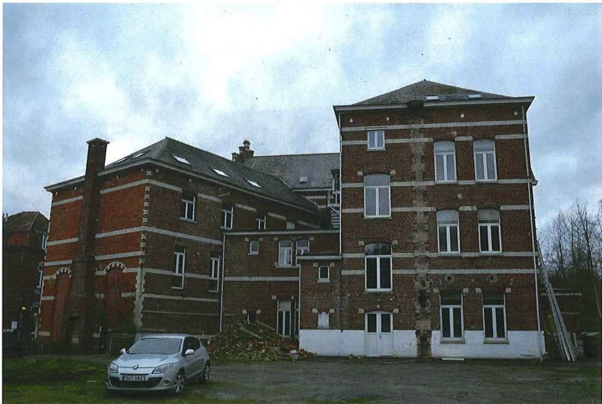
Foto 11: Achtergevels, gezien vanaf het oosten (24.01.2018).
