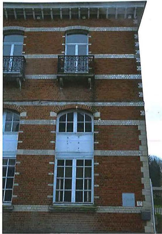
Foto 10: Volume Terblokstraat, detail gevelopeningen met deels vernieuwd schrijnwerk (15.01.2018).
