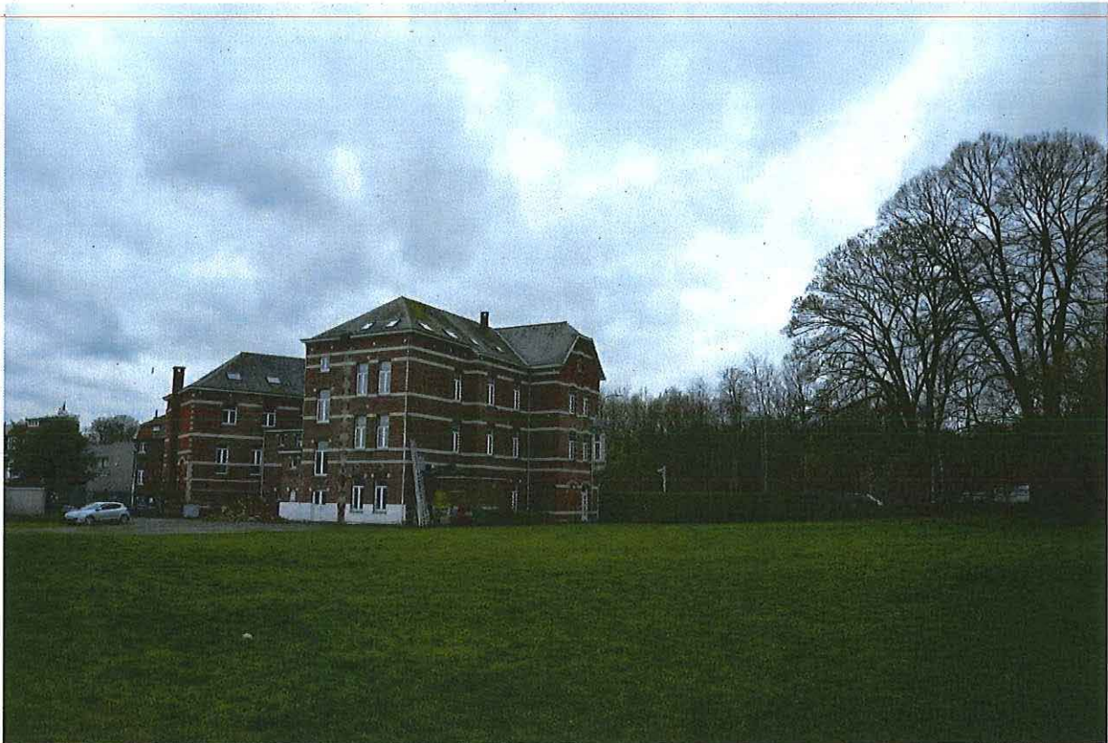
Foto 14: Het Château du Prince Léopold en de omringende tuin, gezien vanaf het noordoosten (24.01.2018).
