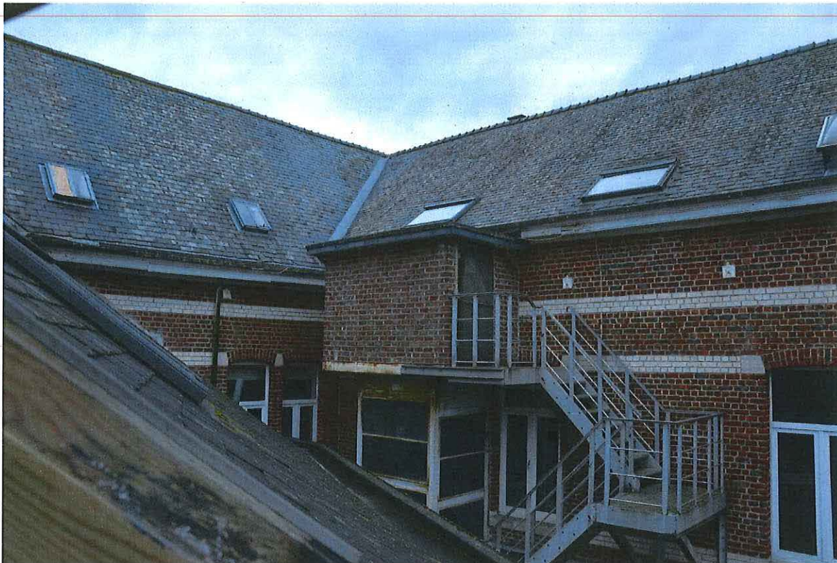
Foto 17: Zicht op de daken van het hoofdvolume en de haakse noordvleugel. Centraal de liftkoker en trap bovenop de lage bijgebouwen in de oksel van het gebouwencomplex (24.01.2018).
