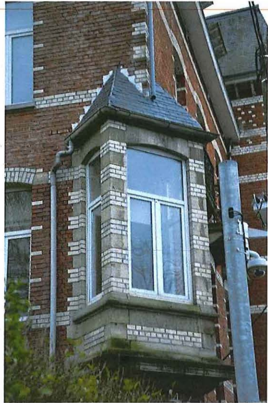
Foto 5: Hoofdgebouw Sint-Jansbergdreef, erker op de noordwestelijke hoek (24.01.2018).
