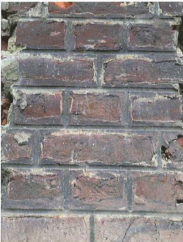
Foto 15: Haakse noordvleugel (oostelijke gevel), detail metselwerk met holle voeg. Onregelmatige bakstenen, aangestreaken met mortel en bijgekleurd. Zicht op deze oorspronkelijke afwerkingslaag die bewaard bleef achter een recent gesloopte schoorsteen (24.01.2018).
