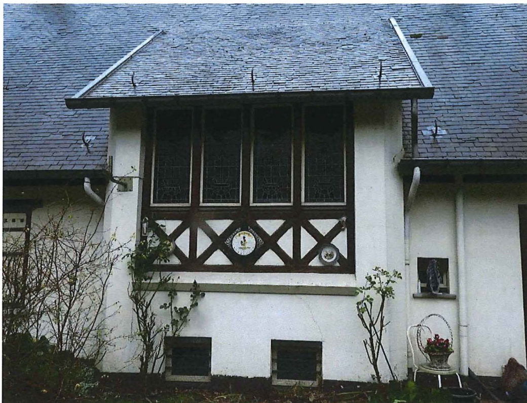
Foto 22: Achtergevel (zuidwesten), detail geveluitsprong onder lessenaarsdak. In het vierledig venster steken decoratief uitgewerkte glas-in-loodramen (4/01/2018).
