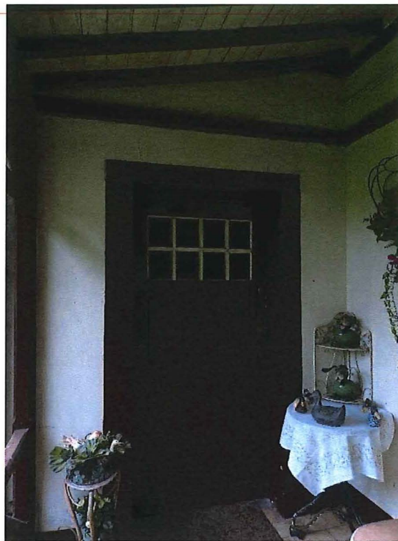
Foto 13: Voordeur Villa Herman Teirlinck. Beglaasde paneeldeur met bovenlicht (19/09/2018).
