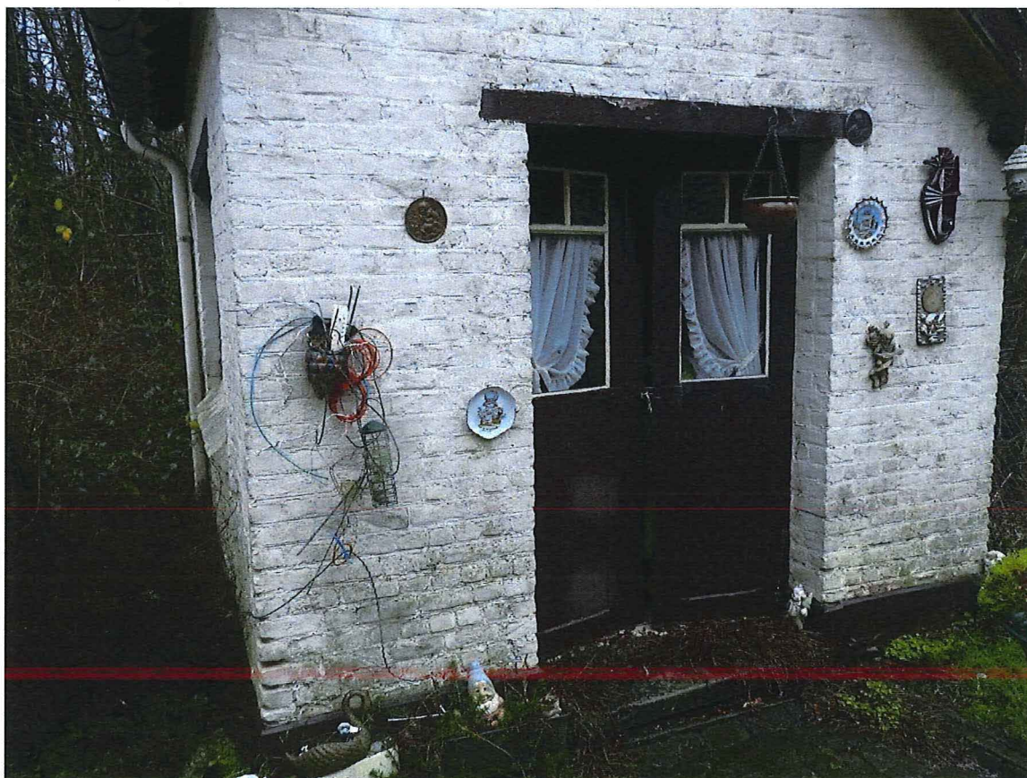
Foto 26: Detail tuinhuis Villa Teirlinck. Dubbele beglasde paneeldeur met bovenlichten (4/01/2018).
