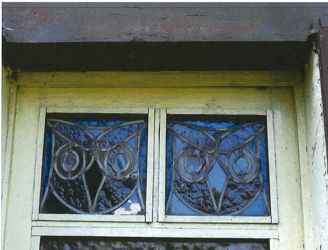
Foto 10: Detail klein rechthoekig venster in de voorgevel (noordoosten). In het bovenlicht steken decoratief uitgewerkte glas-in-loodramen met uilskopjes. Samengesteld glas in lood in vlak glas en reliëfglas. (19/09/2018).
