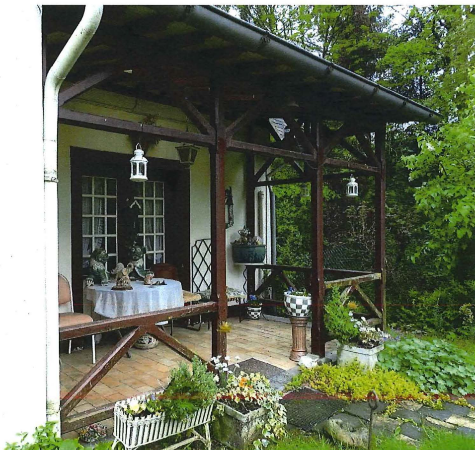
Foto 14: Overdekt terras aan noordoostelijke voorgevel (19/09/2018).
