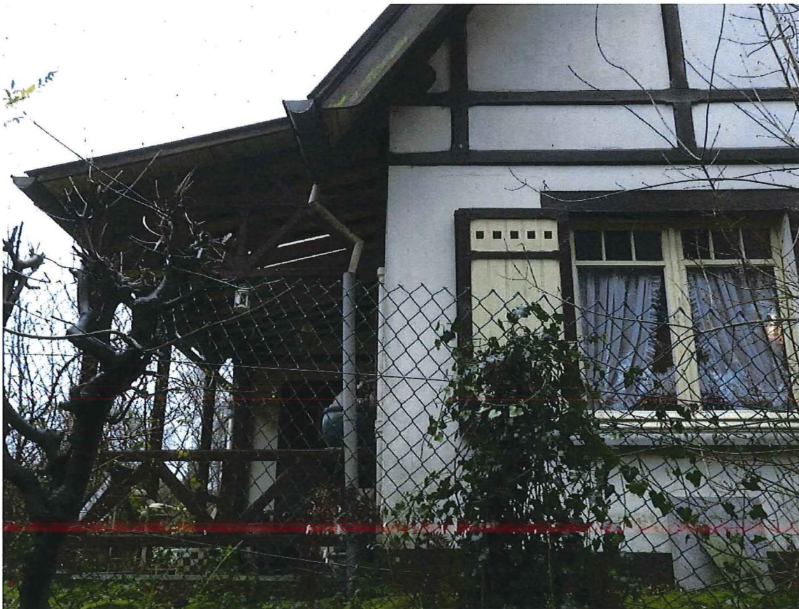
Foto 29: Aansluiting overdekt terras op de noordwestelijke zijgevel (4/01/2018).
