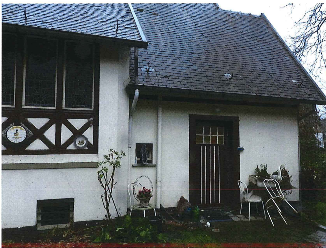
Foto 21: Detail achtergevel (zuidwesten) Villa Herman Teirlinck. De achterdeur betreft een enkele opgeklampte deur met bovenlicht. Deze geeft toegang tot de keuken (4/01/2018).
